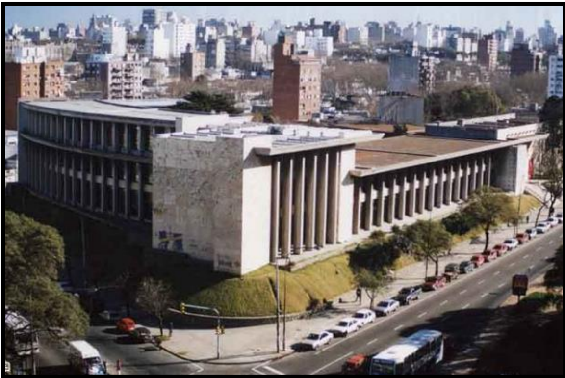
FIGURA N°1: Vista de fachada
