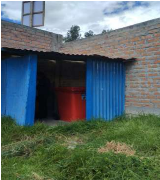
Fig. 12: Lugar donde se acopia los residuos biocontaminados y especiales
