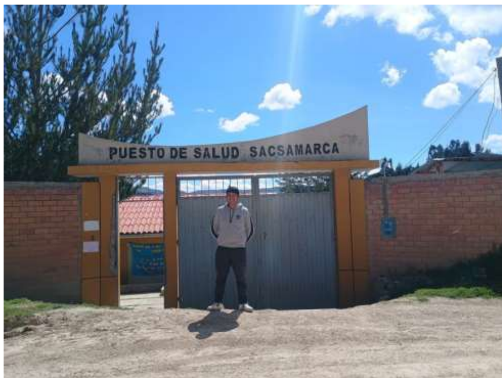
Fig. 5: Puesto de Salud Sacsamarca
