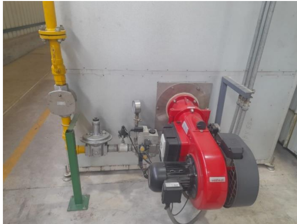
Figura 3.18: Quemador tipo lanza llama
