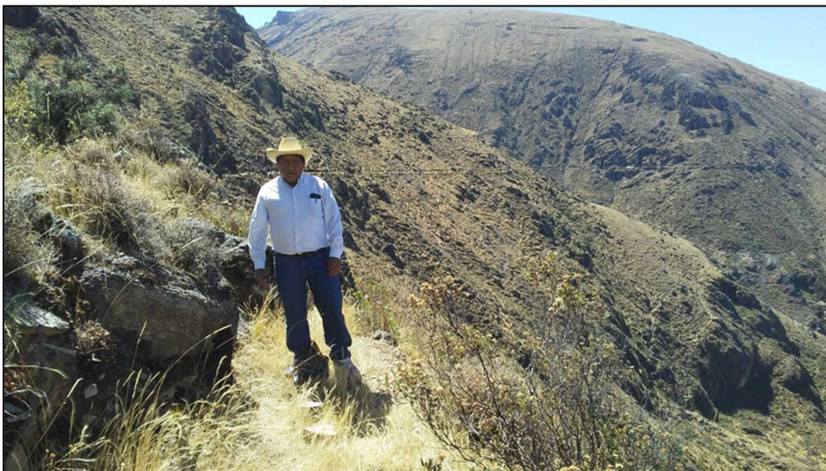
Fig. 6: Poblador señalando un tramo rocoso donde se producen infiltraciones
