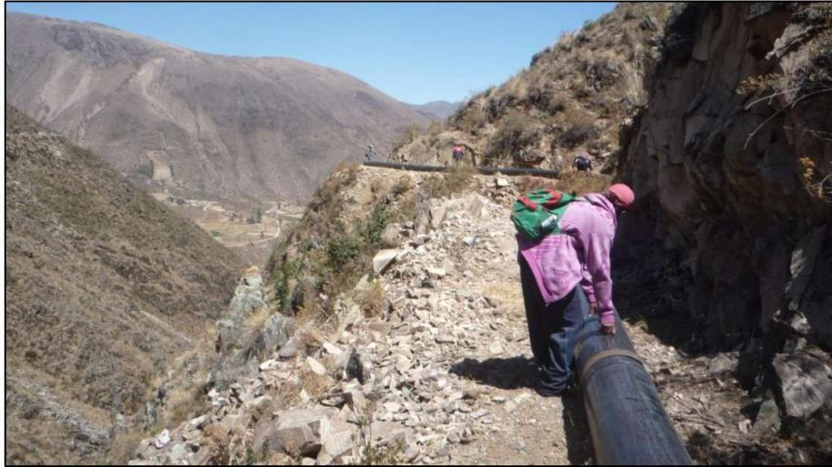
Fig. 4: Vista del tramo del canal entubado con PVC 12”
