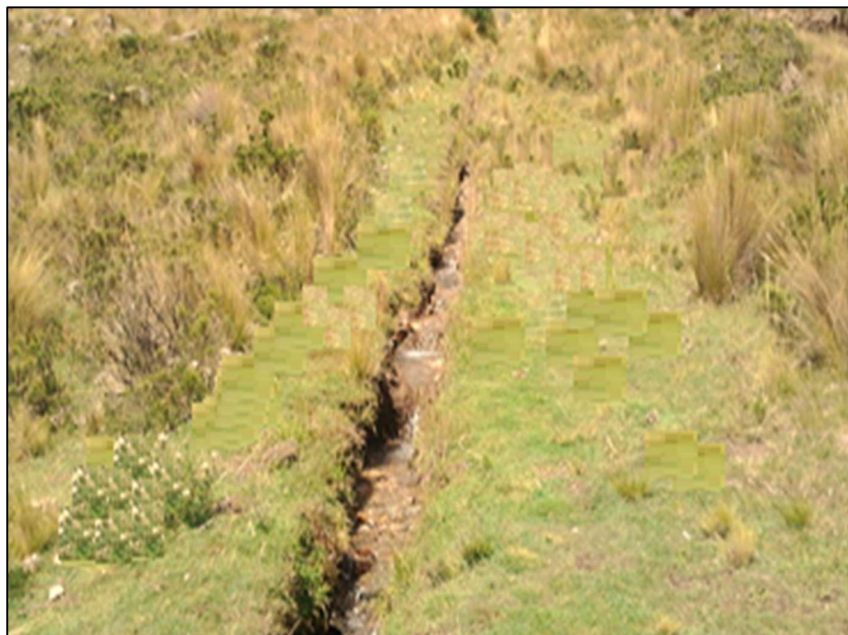
Fig. 8: Vista de un tramo recto del canal de tierra
