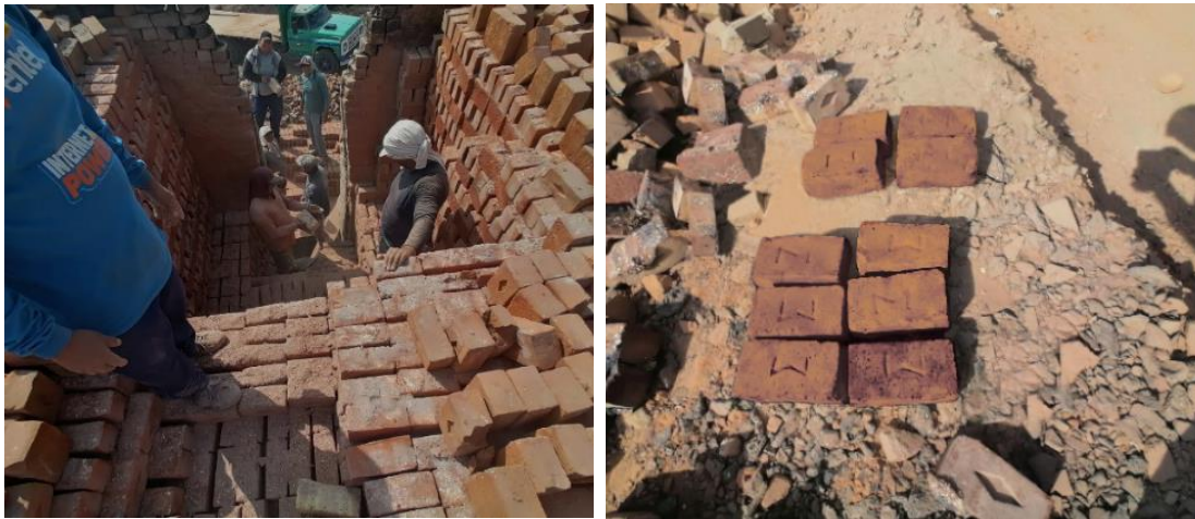
Figura 13: Extracción de ladrillos de Horno
