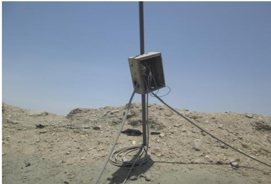
Cables expuestos
