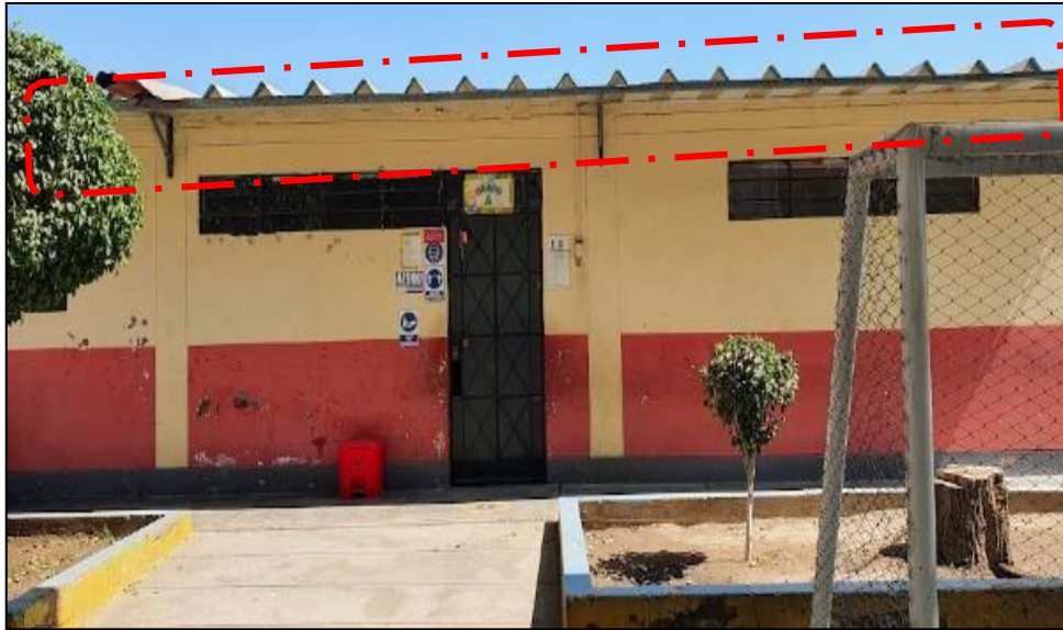
Fig. 17 Cobertura y juntas de pabellón F
