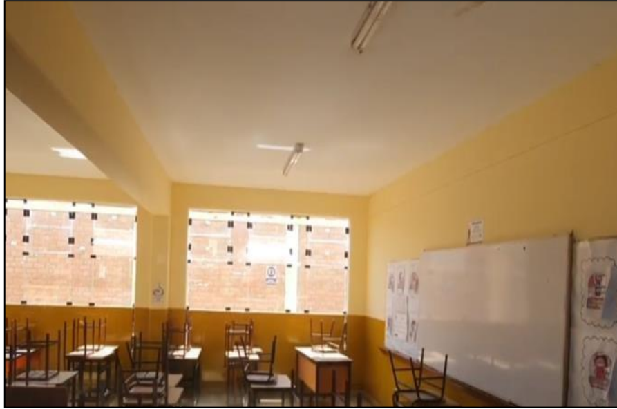
Fig. 19 Estado de conservación de ambientes internos del pabellón A
