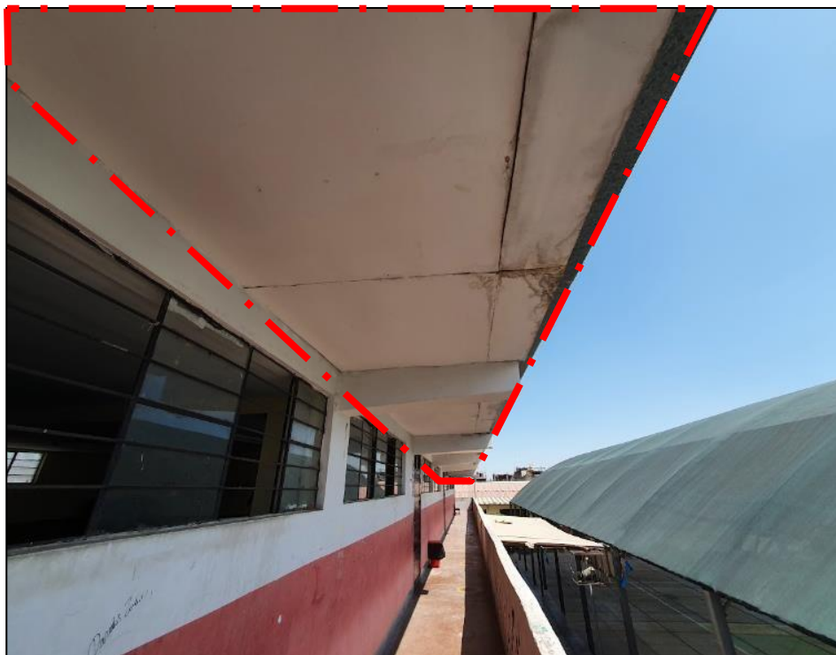
Fig. 6 Cobertura del segundo nivel en pabellón E
