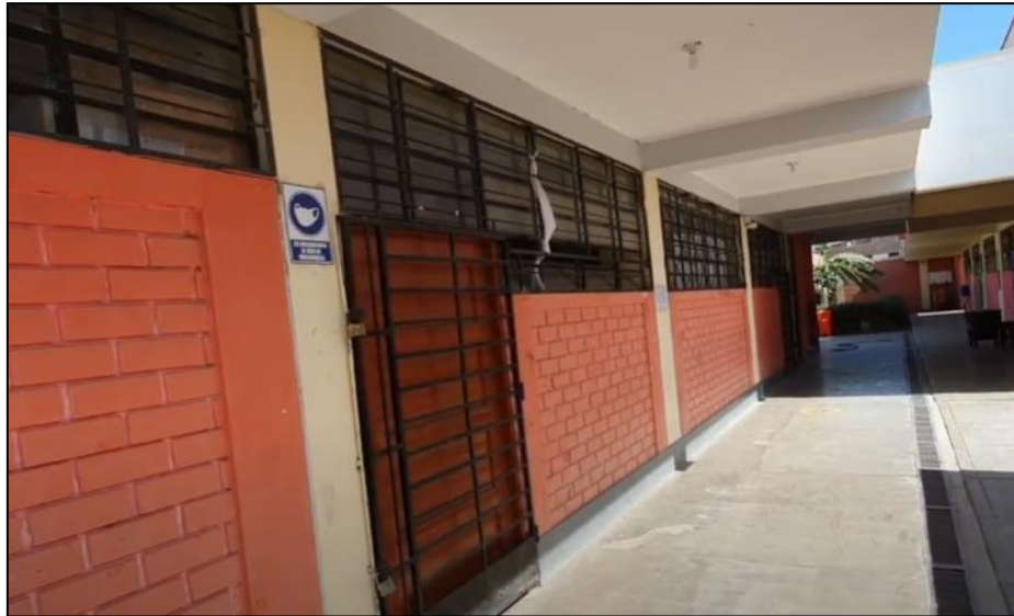
Fig. 21 Estado de conservación pabellón B
