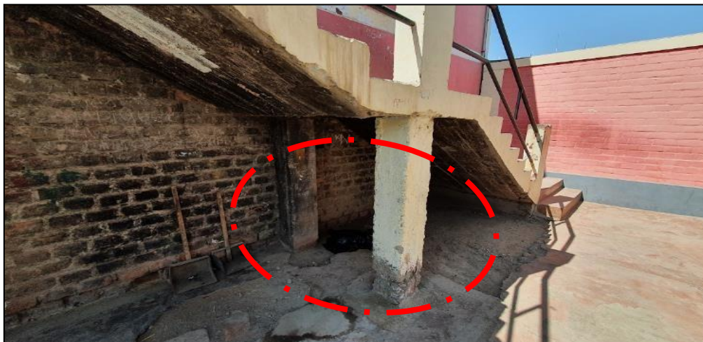
Fig. 8 Escalera de acceso a segundo nivel del pabellón E
