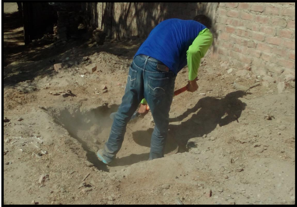
Fig. 78 Fotografía de excavación de calicata N°1
