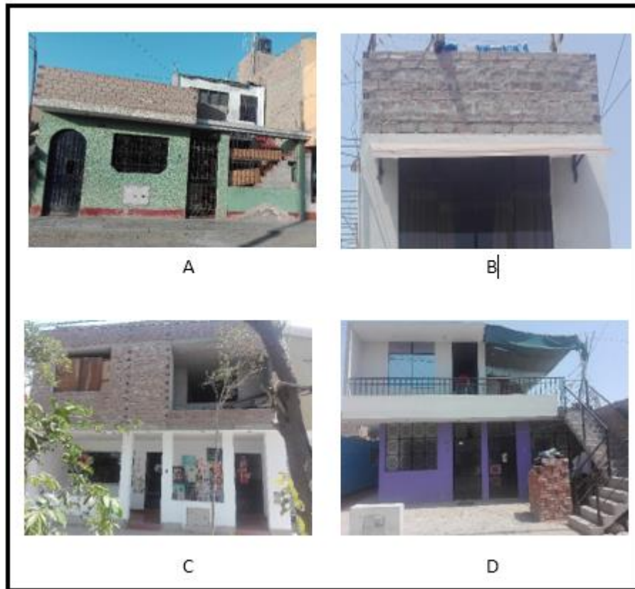
Figura N° 7: Ejemplo de elementos no estructurales.
