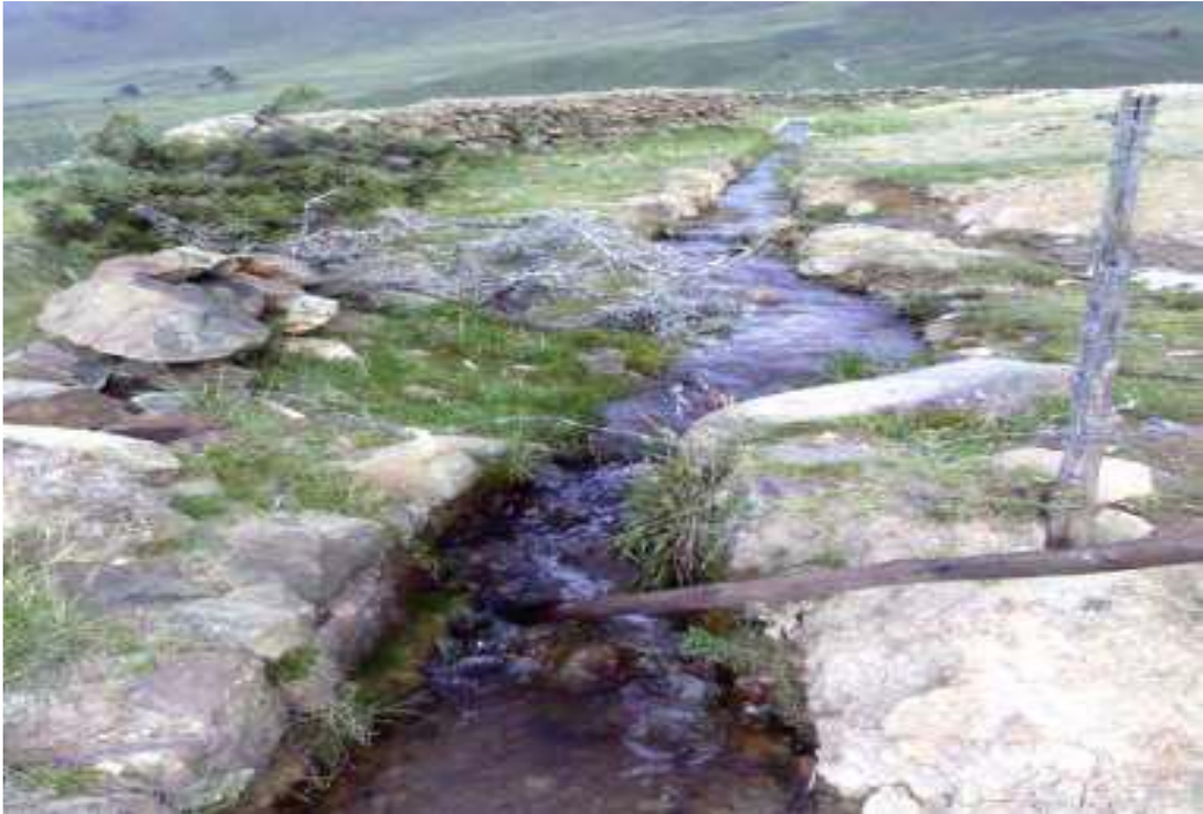
Fig. 32. Vista tercer tramo del canal en tierra, se observan trabajos rústicos en piedra.
