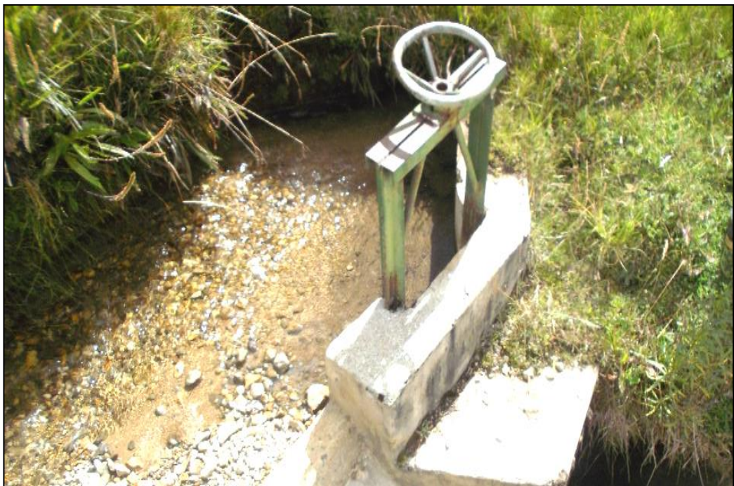
Fig. 12. Vista de la toma lateral
