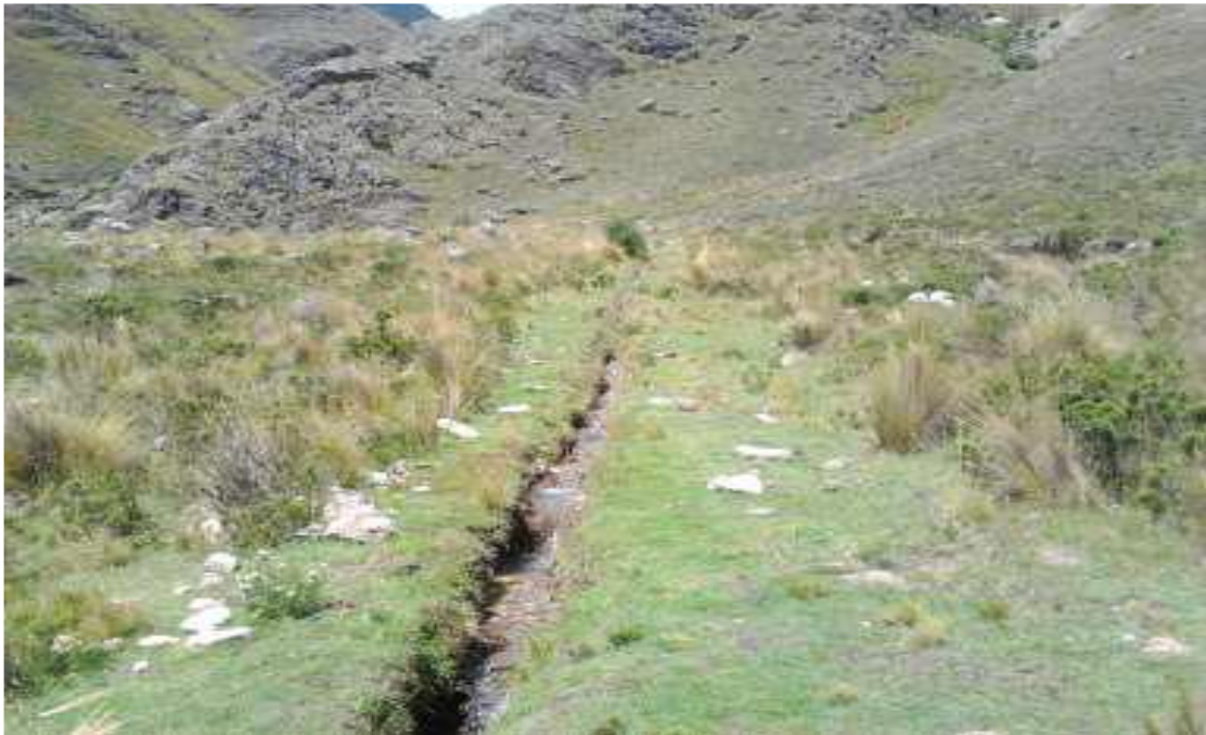
Fig. 27 Vista del tramo 1 del canal en tierra, después de la unión y antes del reservorio.
