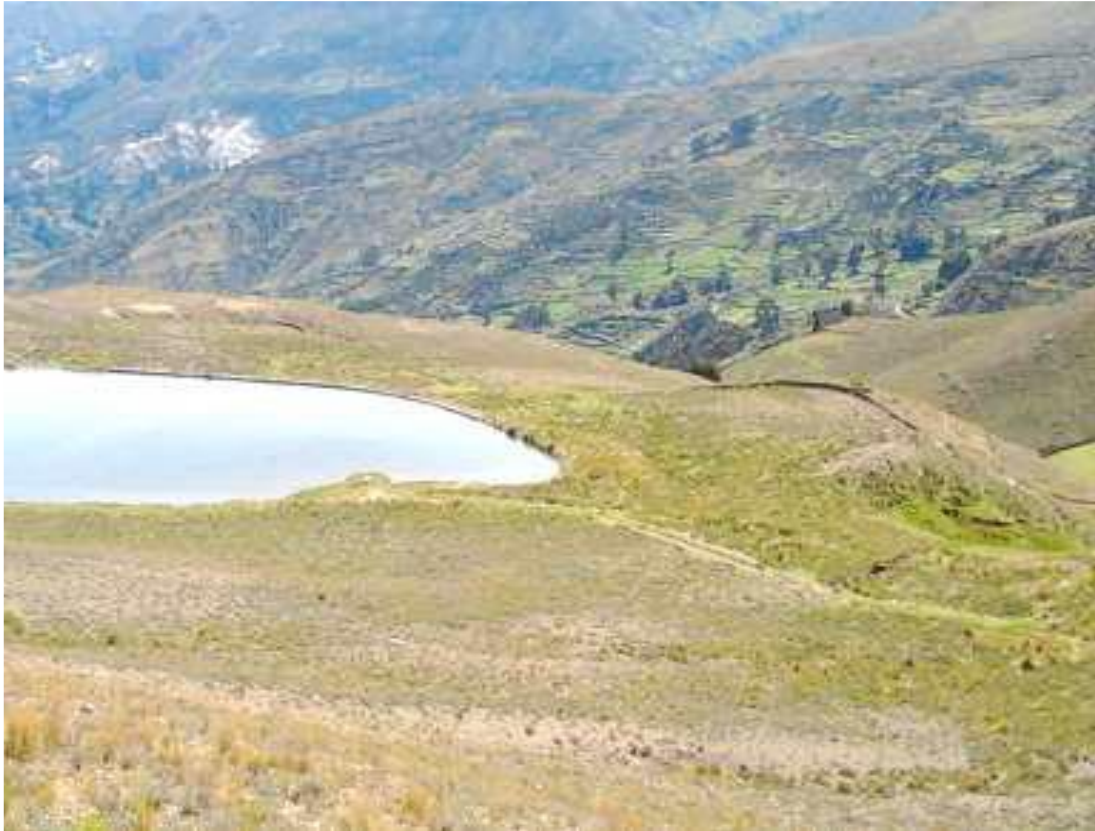
Fig. 28. Vista del reservorio de almacenamiento de 2500 m 3 , recibe al canal y este continua su recorrido.
