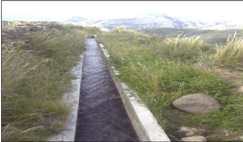
Fig. 9. Canal revestido de concreto, al terminar el Segundo Tramo del Canal en Tierra en la Progresiva 1+822.10
