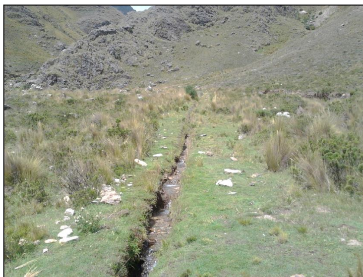
Fig. 8. Primer tramo del Canal en Tierra: Progresiva 0+00 hasta 0+761.96
