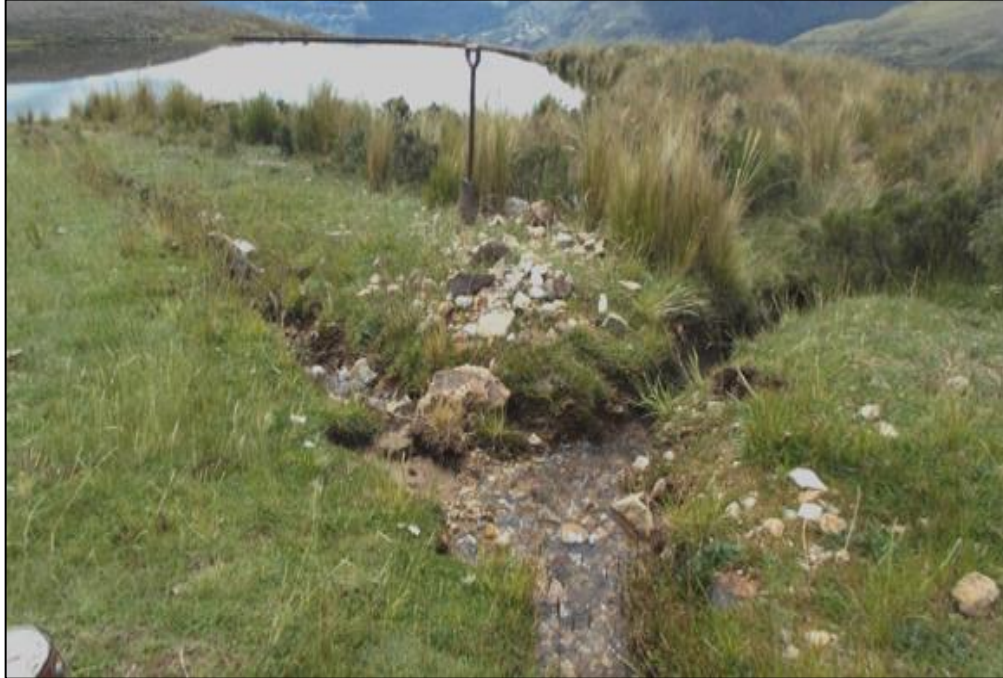
Fig. 11. Vista de la toma del canal en tierra, en la Progresiva 2+561.90
