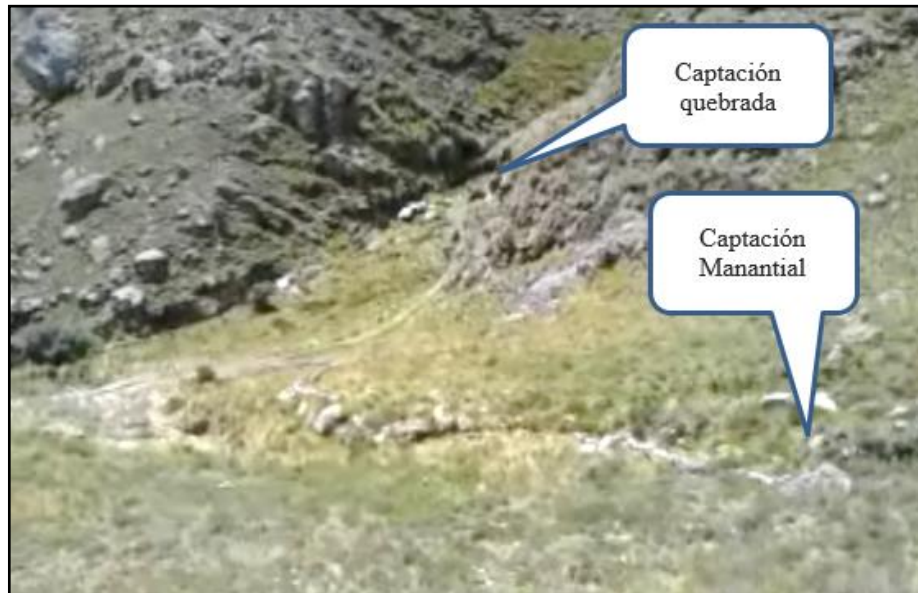
Fig. 7. Vista General de la Captación en la Quebrada y Manantial
