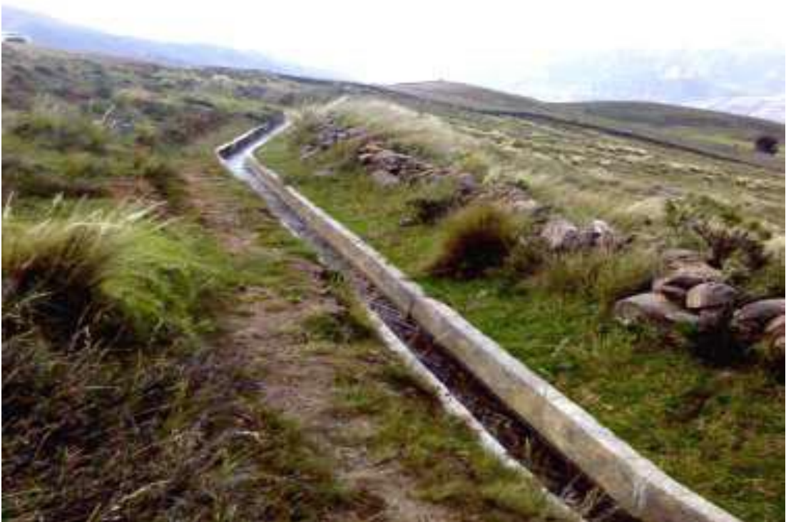
Fig. 31. Vista tramo del canal revestido de concreto en buen estado de conservación.
