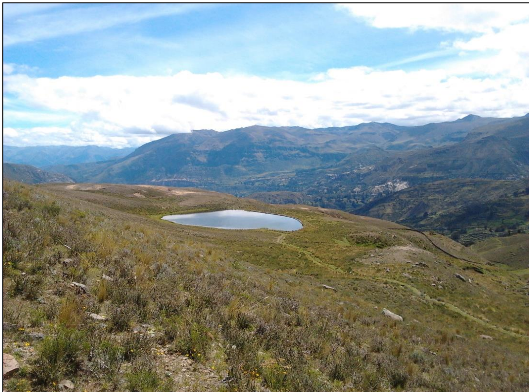
Fig. 29. Vista panorámica del reservorio de almacenamiento de 2500 m 3 .
