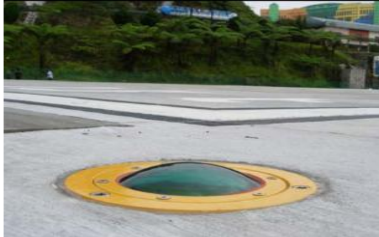
Figura 74 Instalación de Luces TLOF
