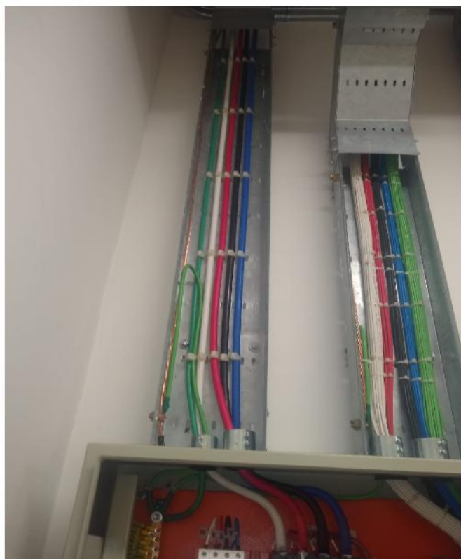
Figura 106 . Tendido de Cables Eléctricos en Tableros
