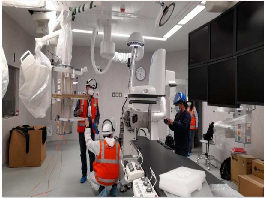
Figura 67 Luminarias Agat Clean Led 36 W 5200 Lm 840/1200X300 PLX Sala de Operaciones
