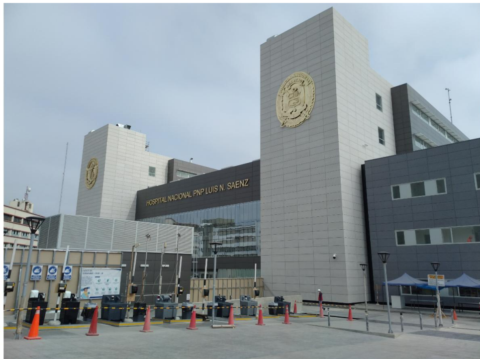
Figura 69 Instalación de Luminarias TRIAN P/ POSTE LED 60 W 4000 K
