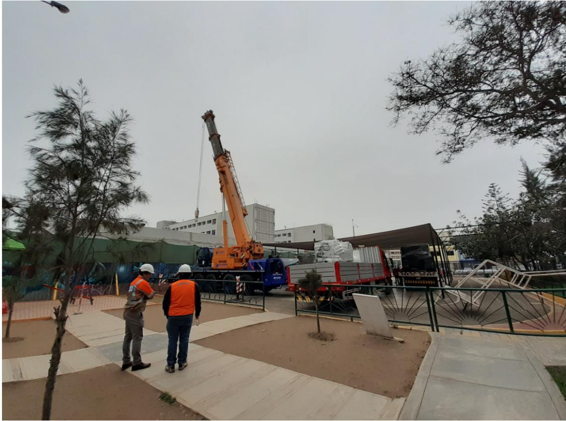
Figura 110 . Grúa Telescópica Realizando el Izaje de GE 1800KVA
