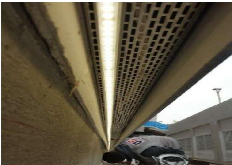
Figura 70 Instalación de Luminarias CINTA FLEXIBLED 15W/M 24V IP65 4000K
