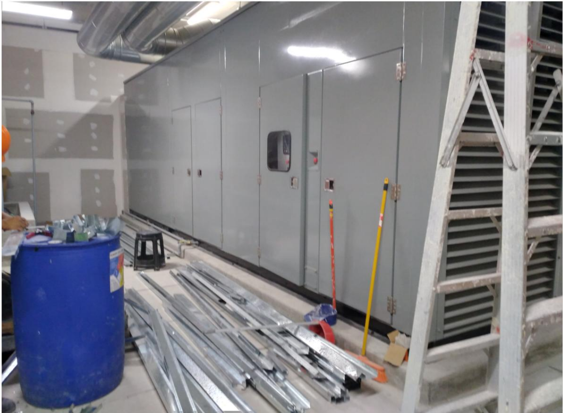
Figura 114 . Encapsulado de Grupos Electr6genos 1800KVA
