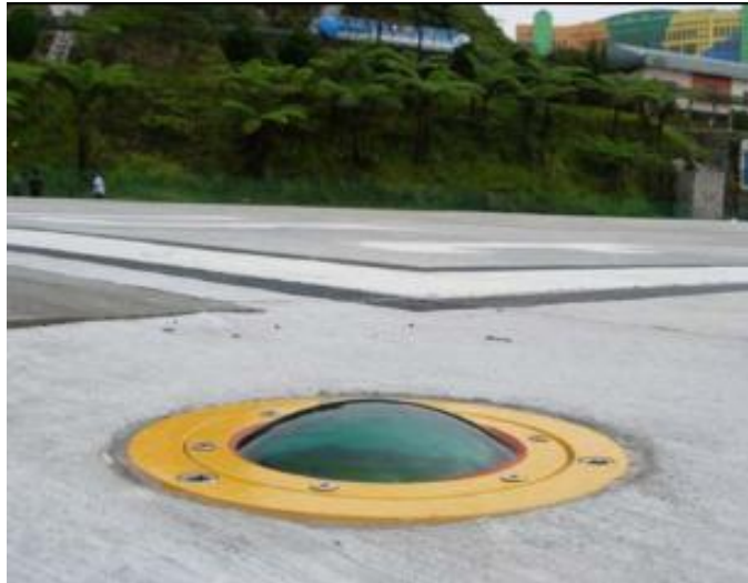
Figura 76 Instalación de Luces FATO
