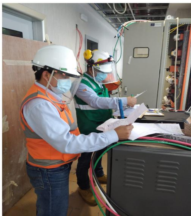
Figura 107 . Tendido de Cables Eléctricos en Tableros
