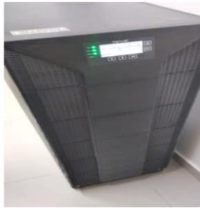
Figura 19 . UPS 60KV Zona UCI Neonatal
