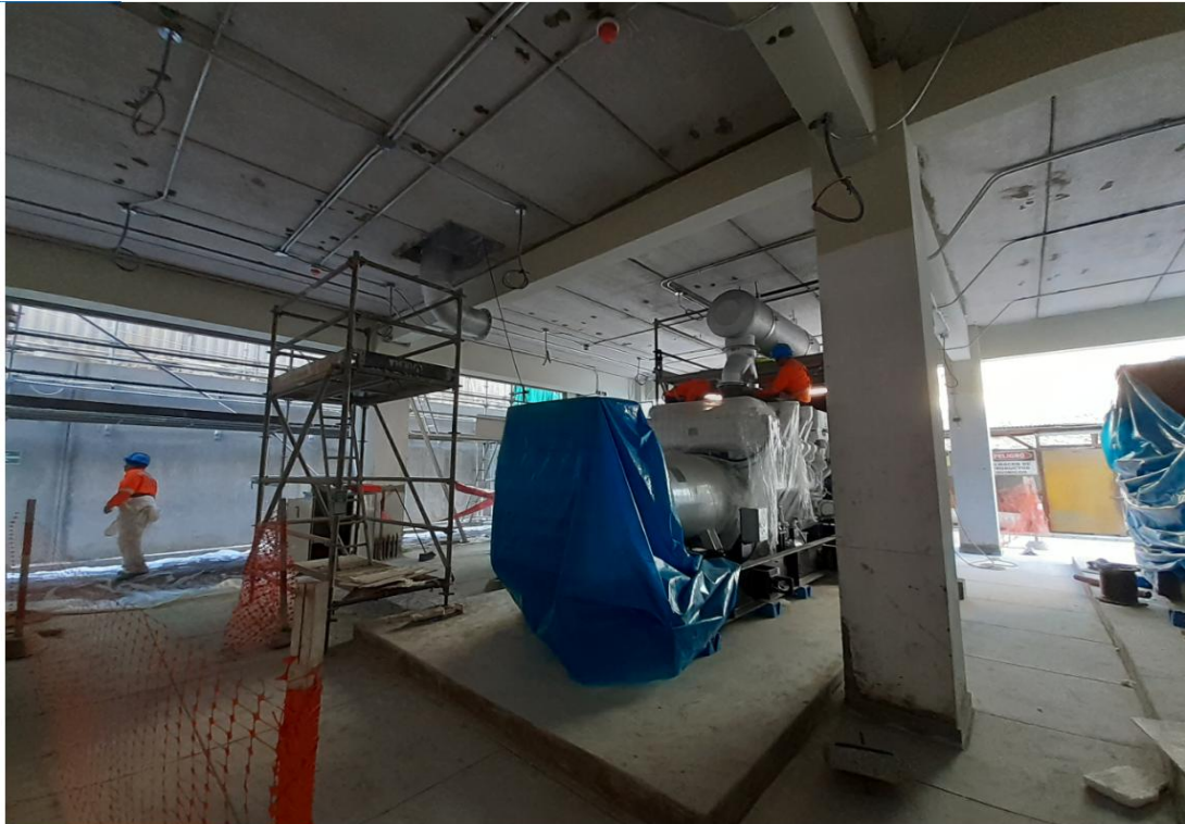
Figura 112 . Instalación de Silenciadores y Tuberías de Escape de GE 1800KVA
