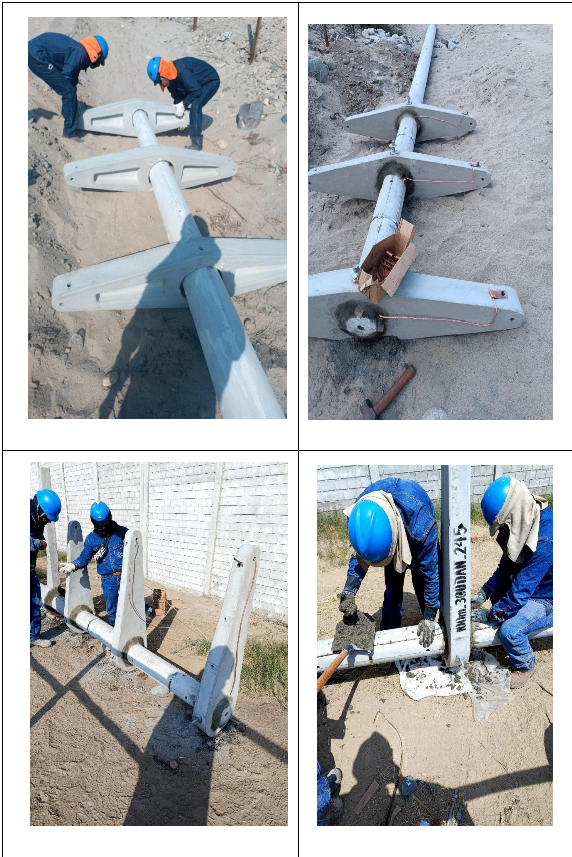
Fig. 10: Cuadro fotográfico armado y fraguado de accesorio de concreto
