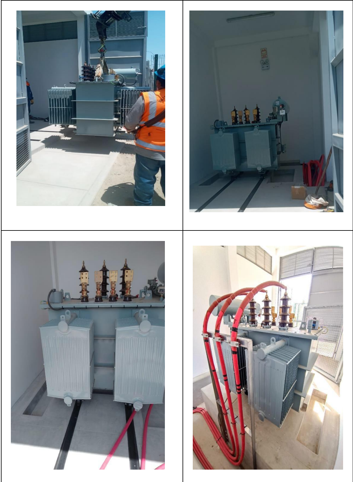
Fig. 17: Cuadro fotográfico instalación de transformador de distribución 1500KVA
