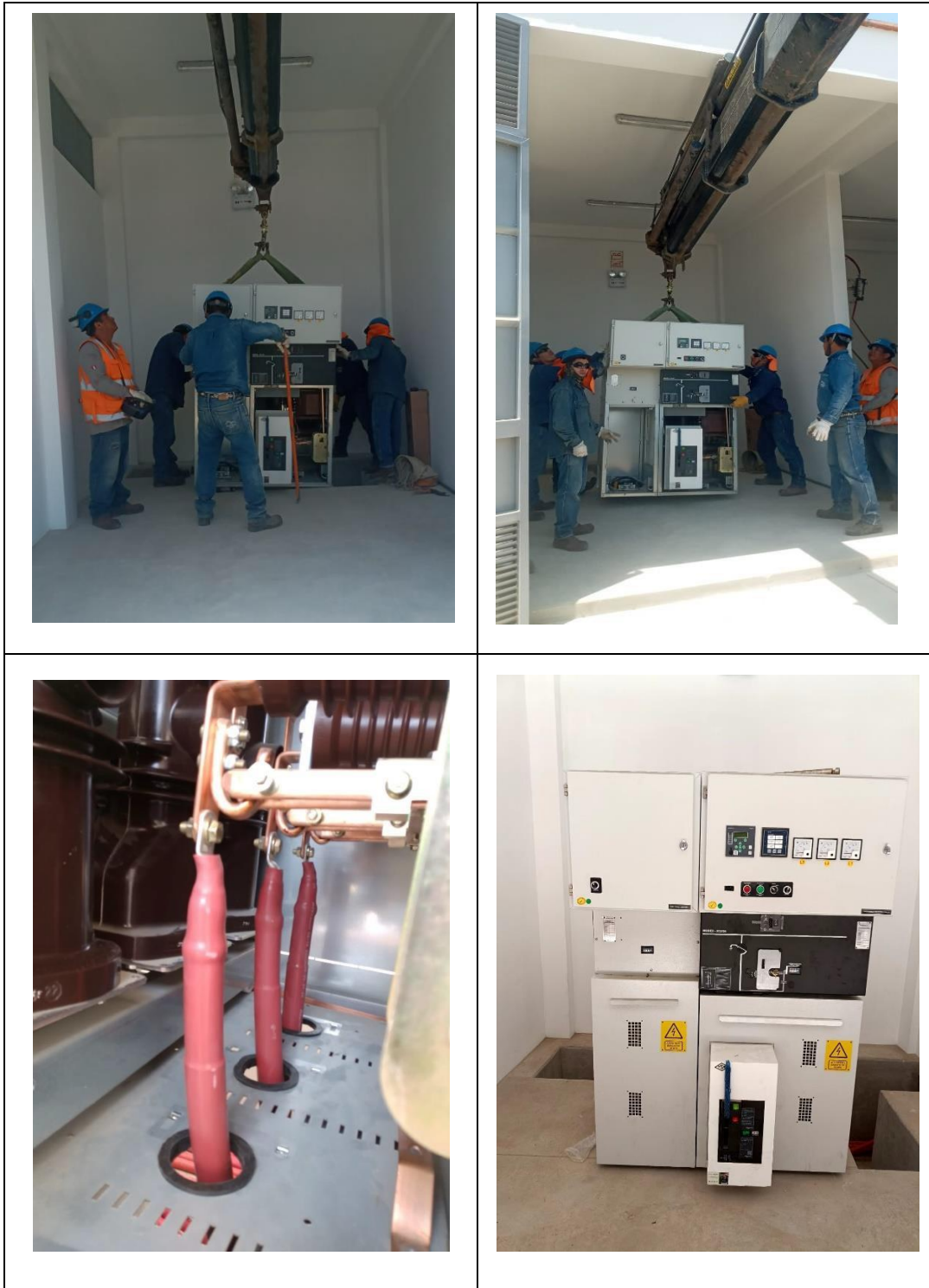
Fig. 18: Cuadro fotográfico montaje de celda de remonte y salida.
