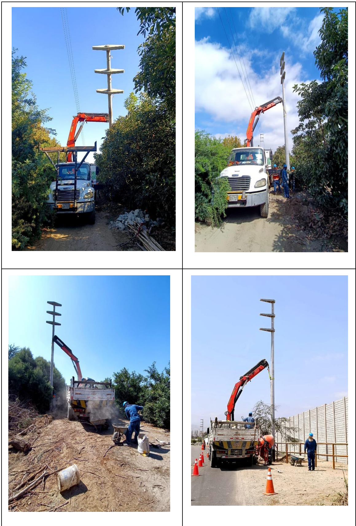
Fig. 11: Cuadro fotográfico izaje de estructuras
