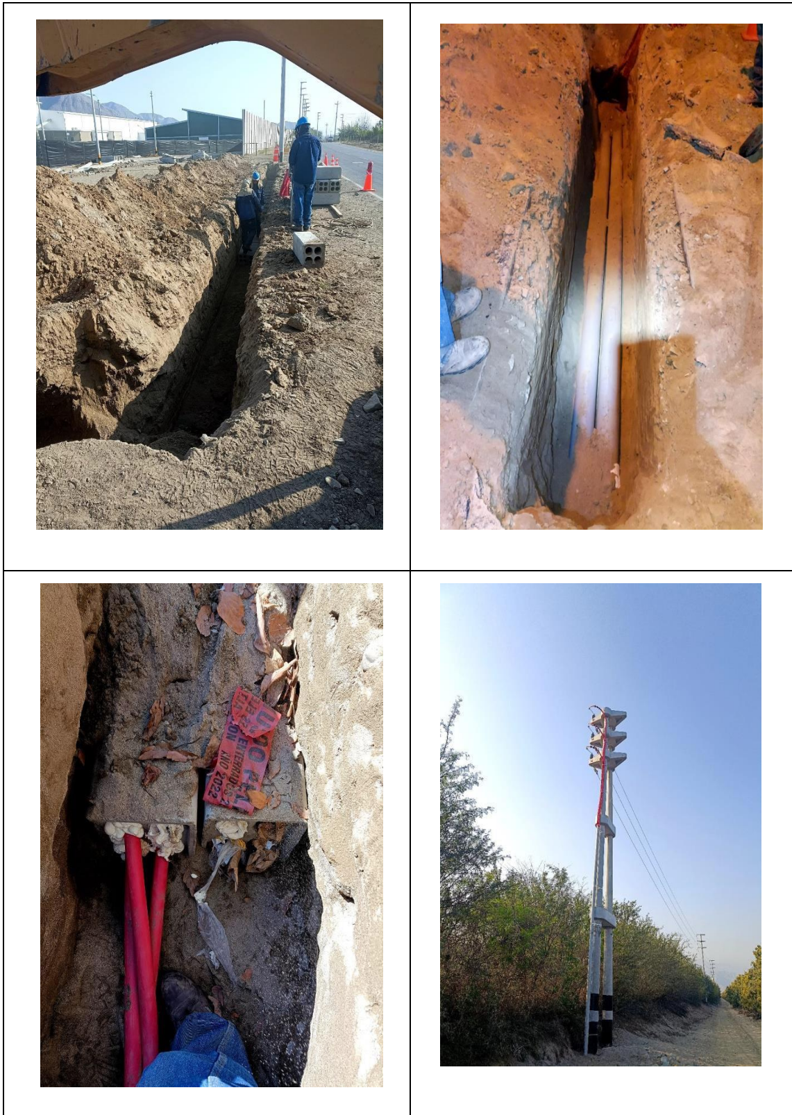
Fig. 13: Cuadro fotográfico instalación de cable subterráneo
