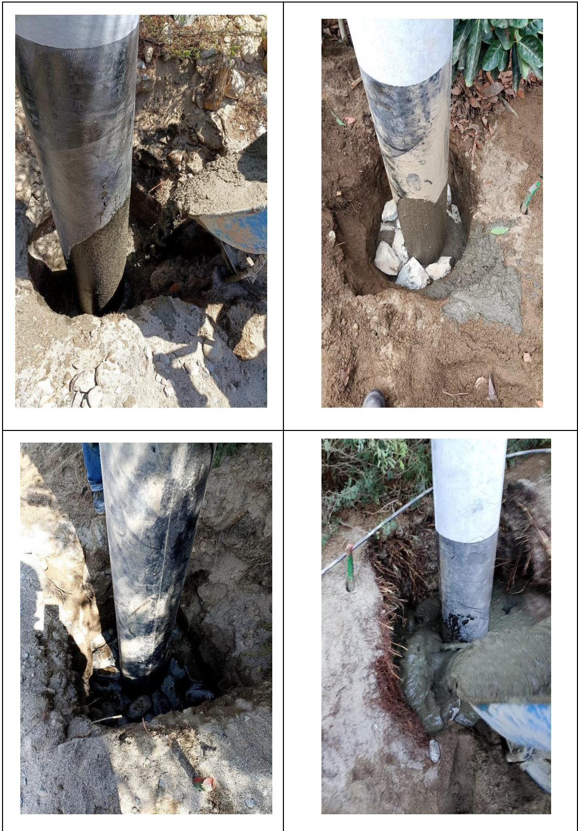
Fig. 11: Cuadro fotográfico cimentación de estructuras
