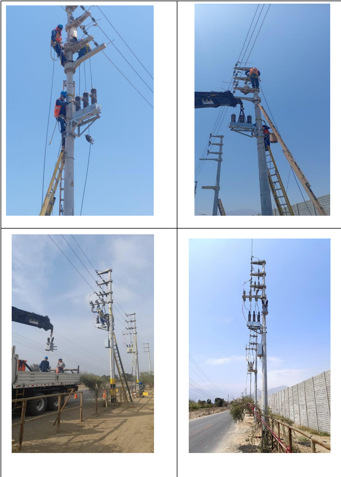
Fig. 16: Cuadro fotográfico instalación de equipo recloser
