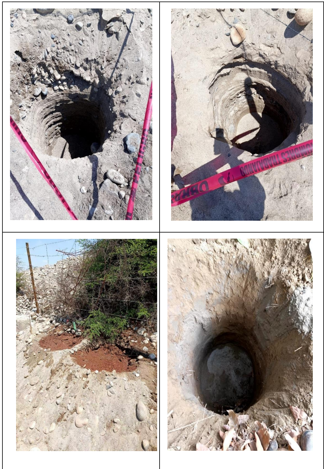
Fig. 9: Cuadro fotográfico excavación de hoyos para postes
