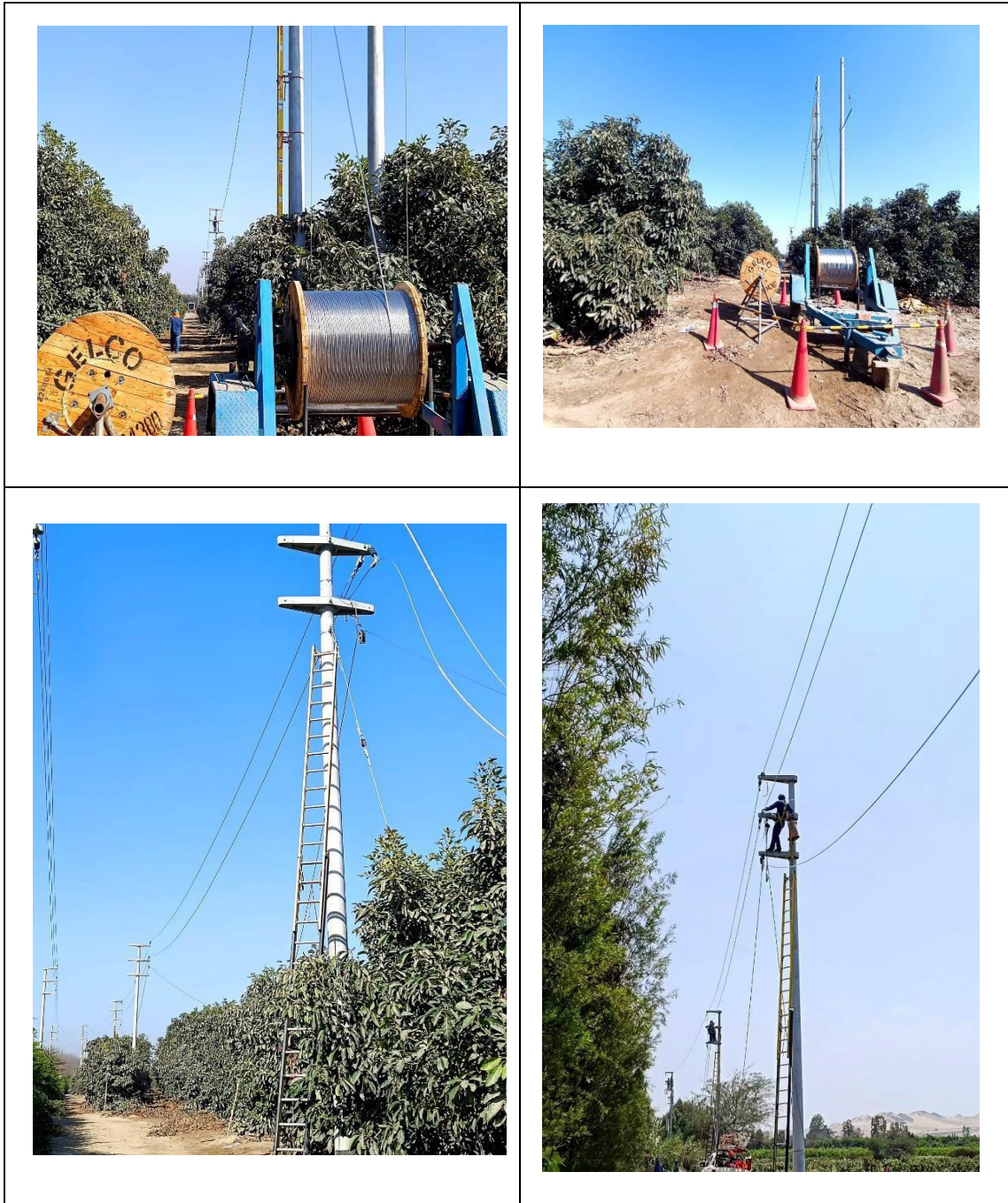
Fig. 14: Cuadro fotográfico instalación de conductor
