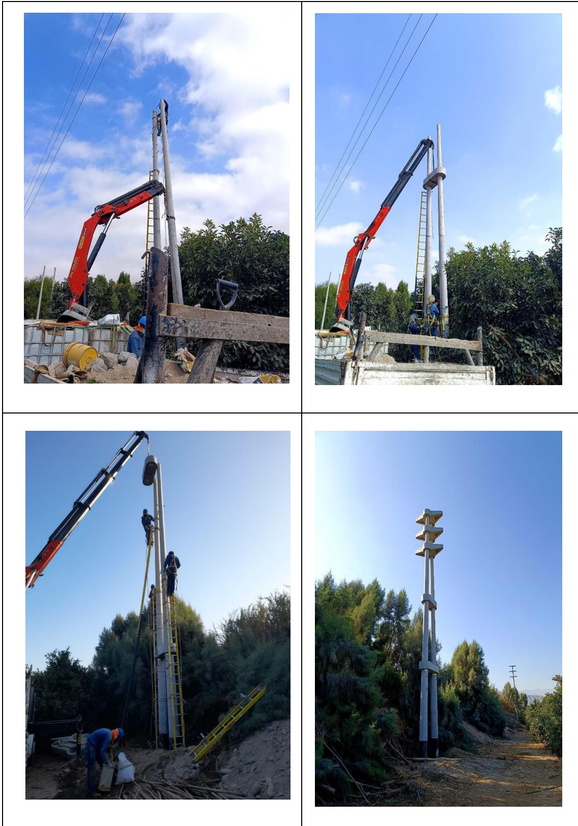
Fig. 12: Cuadro fotográfico izaje de estructuras tipo vinculo
