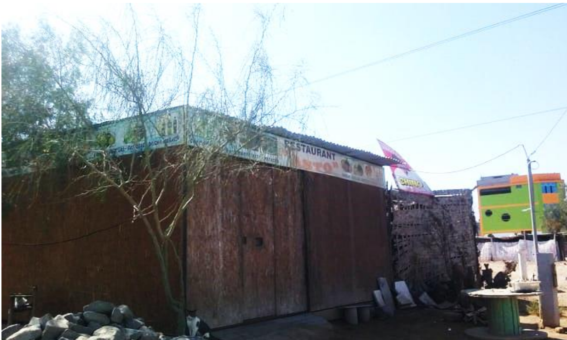
Figura 67: Estado de precariedad de una vivienda con material de construcción de triplay
