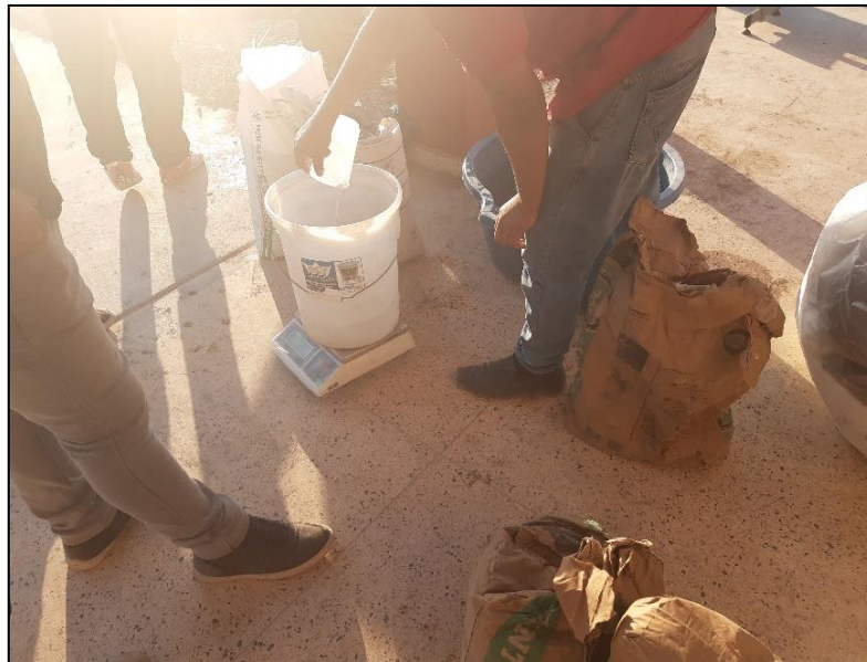
Imagen N° 6: Dosificación de agua.
