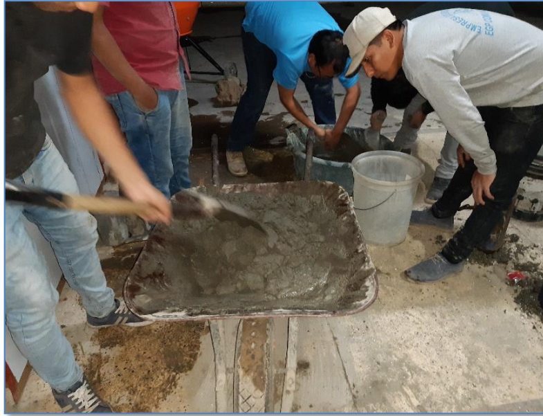
Imagen N° 7: Realización de la mezcla manual.
