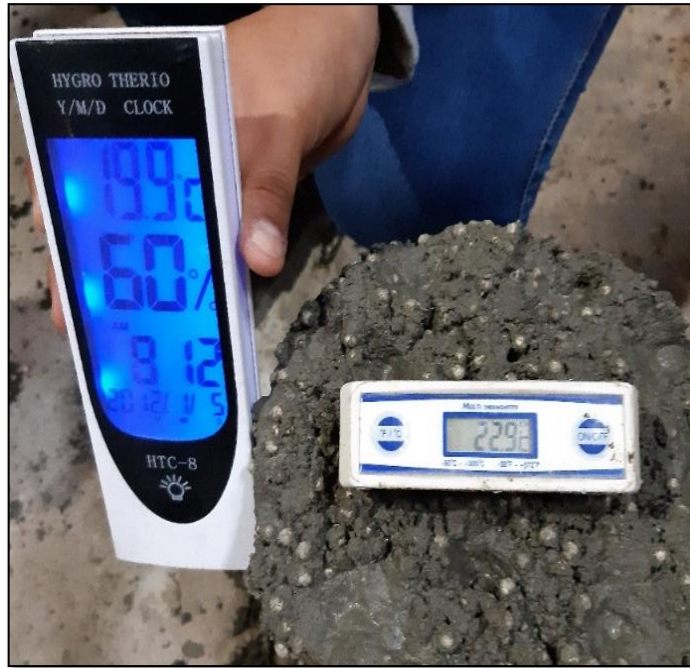
Imagen N° 11: Determinando la temperatura ambiente, humedad relativa y temperatura del concreto.
