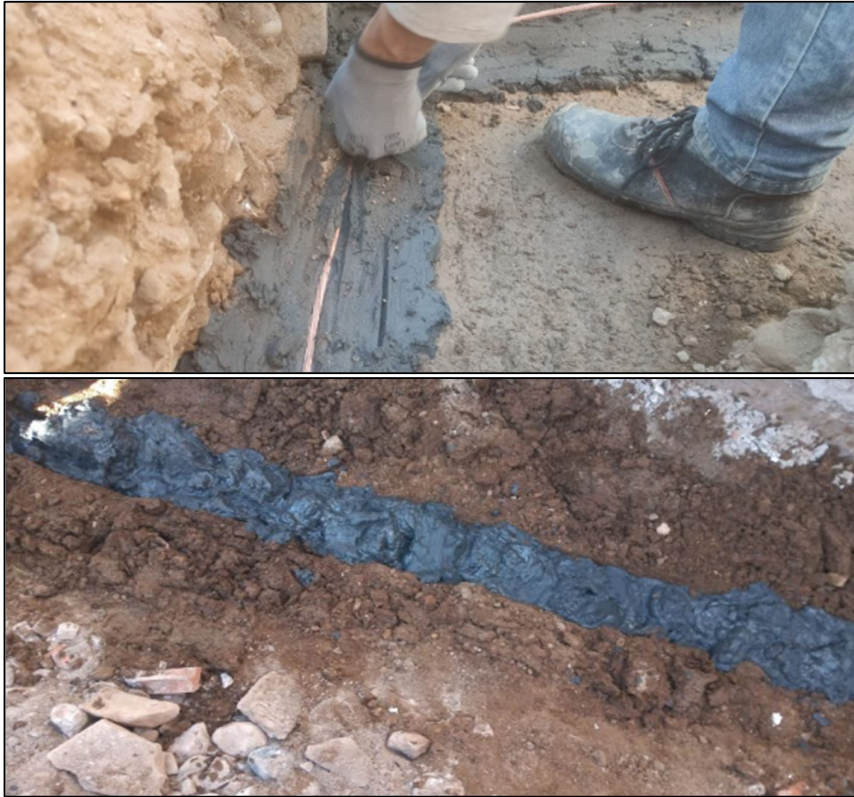
Fig. 142 Aplicación de cemento conductivo
