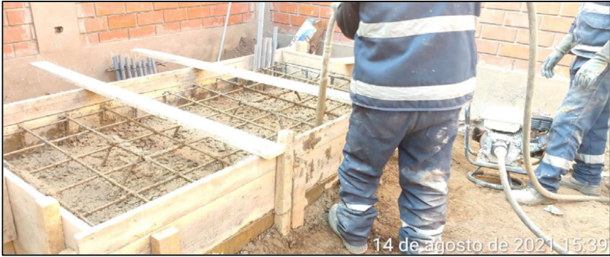
Fig. 105 Vaciado de Losa Maciza de Grupo Electrógeno
