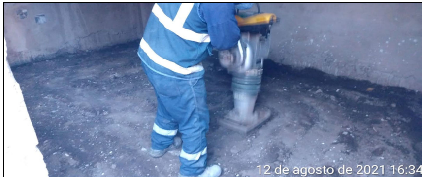
Fig. 95 Compactación en Sala de Equipos
