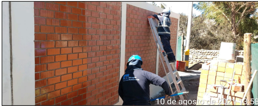
Fig. 115 Colocación de imprimante en Muro Exterior de Cerco perimétrico
