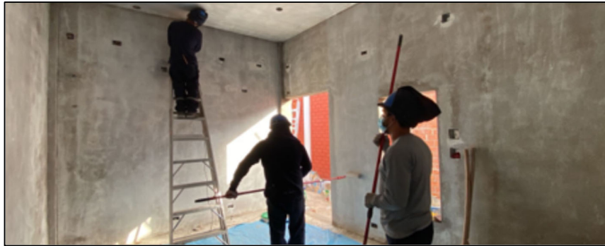
Fig. 114 Colocación de imprimante en Muro Interior de la Sala de Equipos
