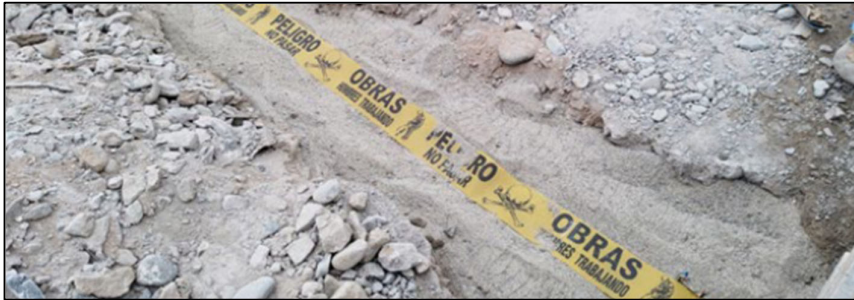
Fig. 143 Colocación de cinta de peligro en las zanjas
