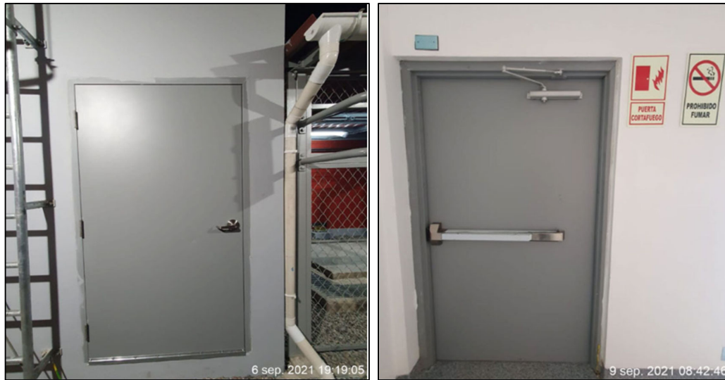
Fig. 125 Instalación de Puerta cortafuego en Sala de Equipos
