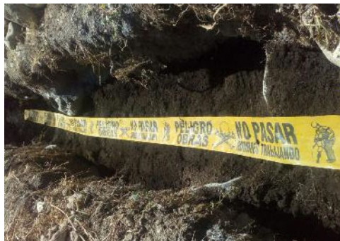
Fig. 19 Instalación de cinta señalizadora en zanja de puesta a tierra
