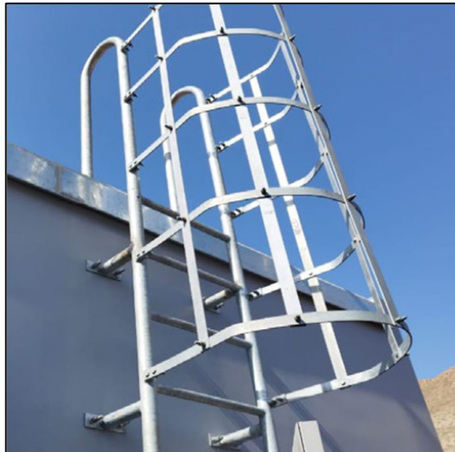
Fig. 129 Instalación de Estructura Metálicas Menores – Escalera de Gato
