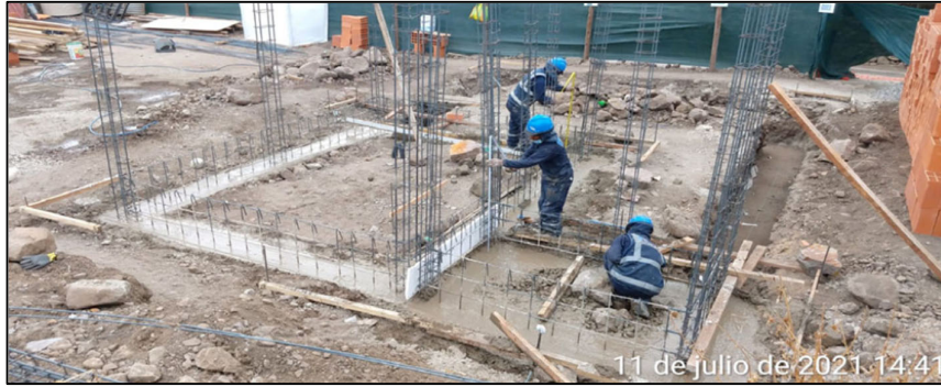
Fig. 73 Vaciado de cimentación
