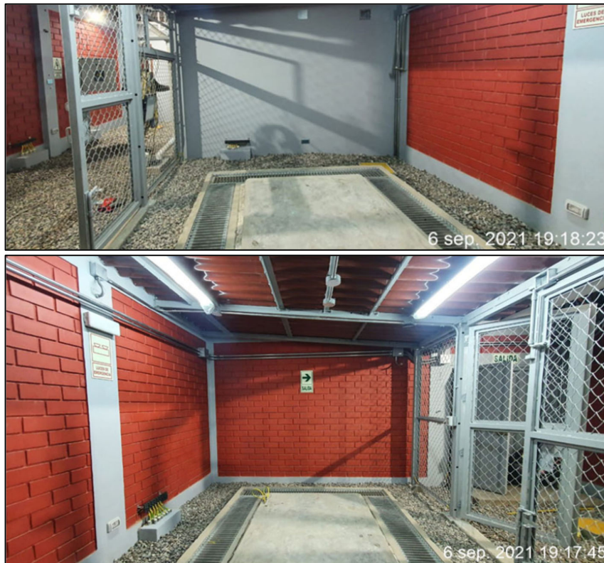
Fig. 138 Instalación de Rejilla en Losa de Grupo Electrónico
