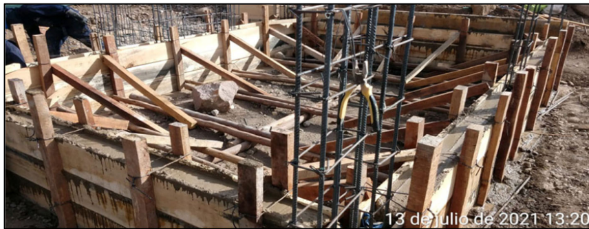
Fig. 74 Vaciado de sobrecimiento
