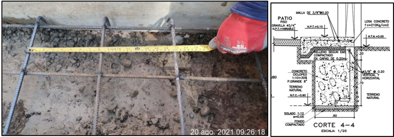
Fig. 106 Verificación de acero en Losa de Ingreso
