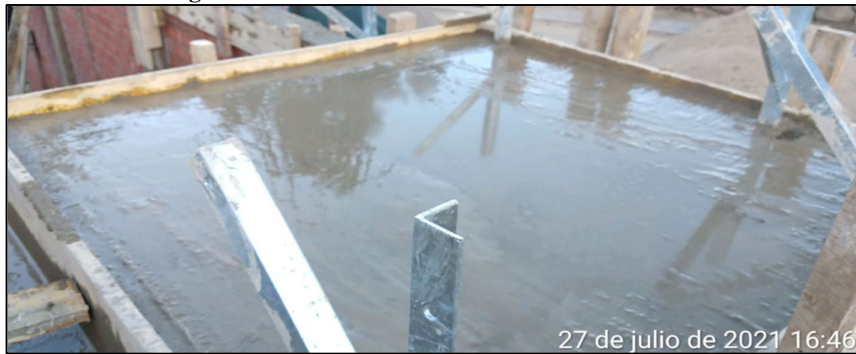
Fig. 93 Vaciado de losa maciza de SS.HH
