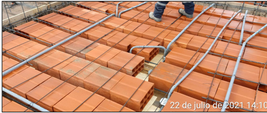
Fig. 89 Colocación de ladrillos en losa aligerada en sala de equipo
