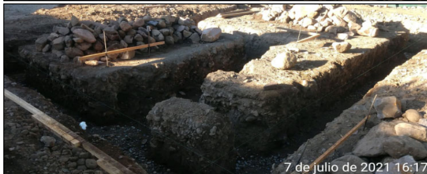
Fig. 69 Excavación de cimentación
