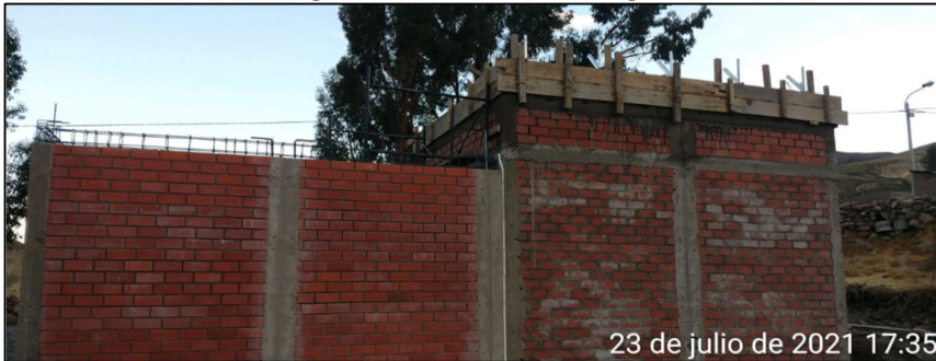
Fig. 84 Vaciado de vigas
