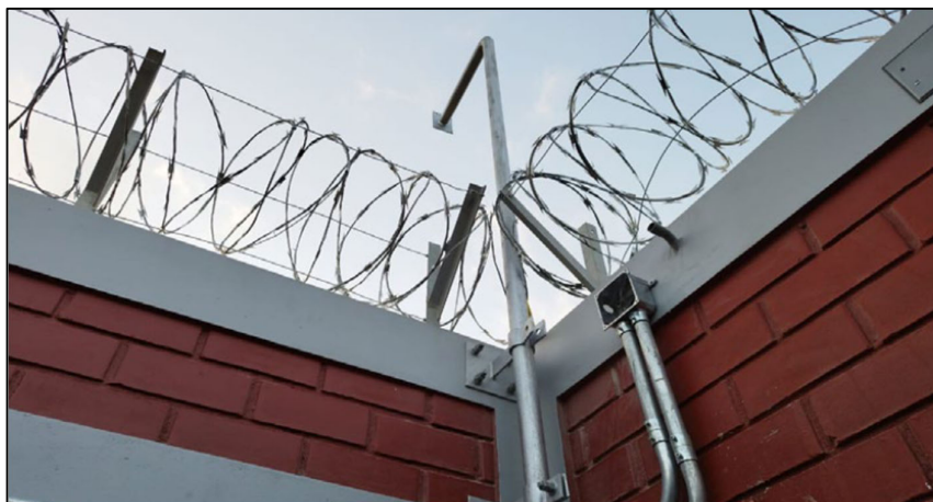
Fig. 131 Instalación de Estructura Metálicas Menores –soporte de cámara y concertina
