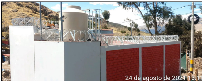
Fig. 157 Vista lateral del nodo terminado lado izquierdo
