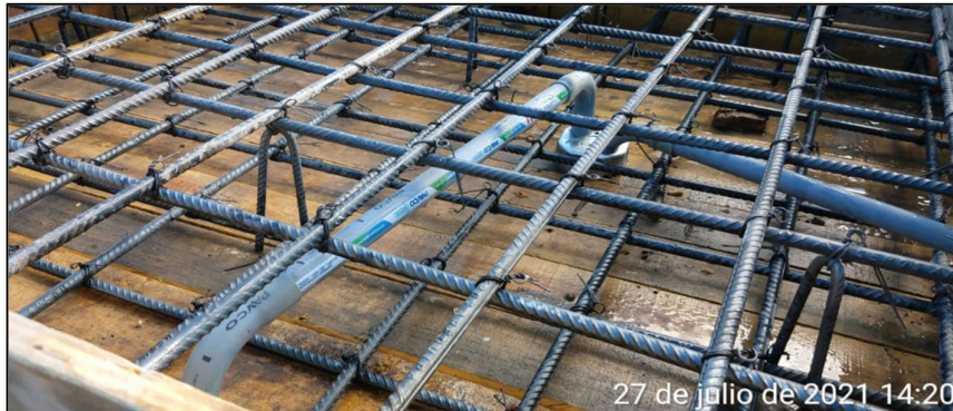
Fig. 92 Armado de acero de losa maciza de SS.HH
