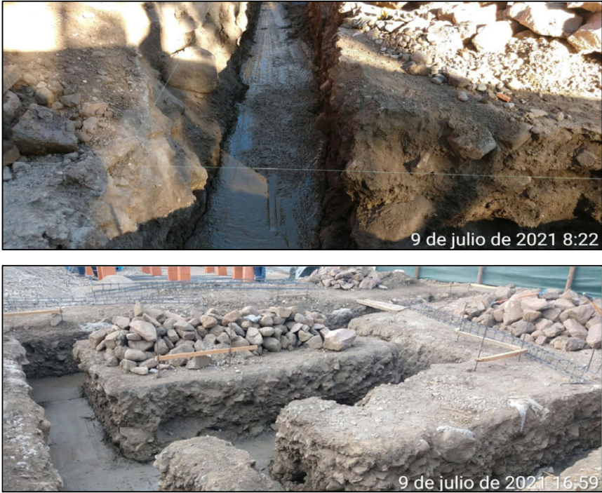
Fig. 70 Vaciado de solado de cimentación
