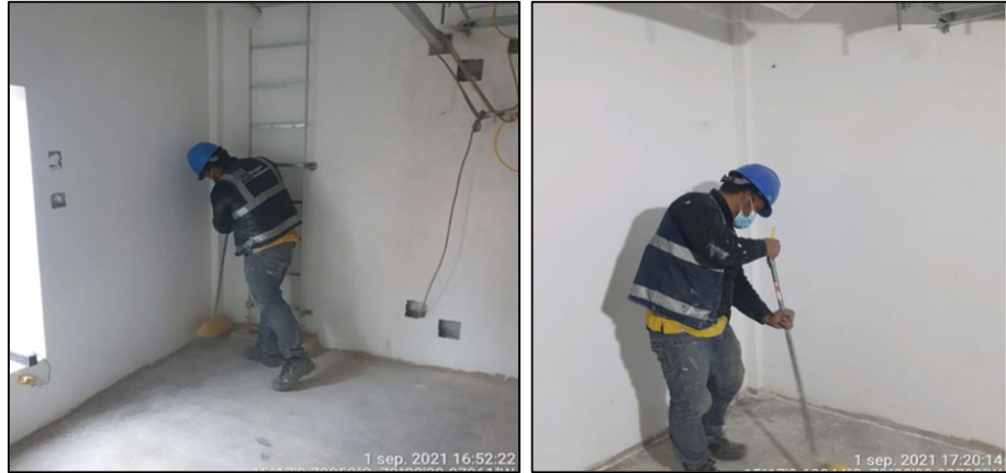
Fig. 134 Instalación de piso antiestático en Sala de Equipos – Limpieza
