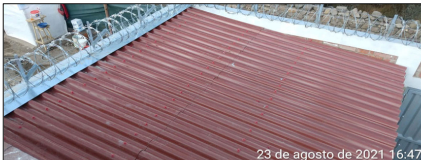
Fig. 124 Instalación de cobertura liviana – Fibra Forte
