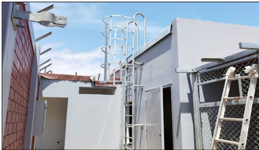
Fig. 130 Instalación de Estructura Metálicas Menores – soporte de pararrayo
