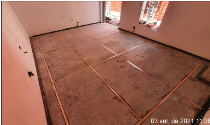
Fig. 136 Instalación de piso antiestático en Sala de Equipos – colocación de lámina de cobre
