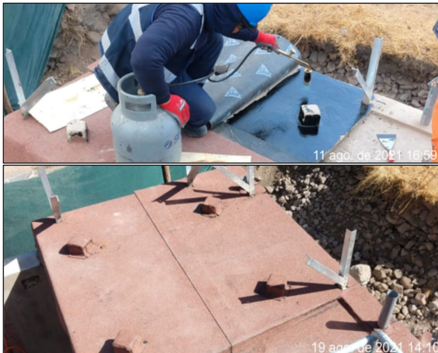
Fig. 123 Colocación de manto asfáltico en losa de maciza de SS.HH
