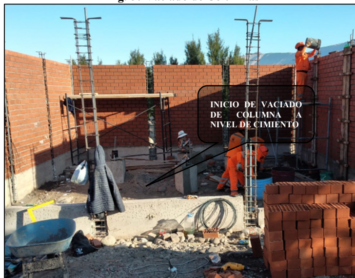
Fig. 81 Verificación de vaciado de columnas
