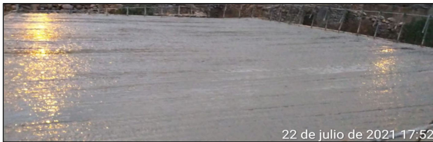
Fig. 90 Vaciado de losa aligerada en sala de equipo
