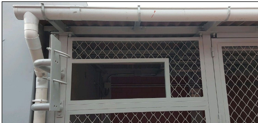
Fig. 153 Canaleta Pluvial
