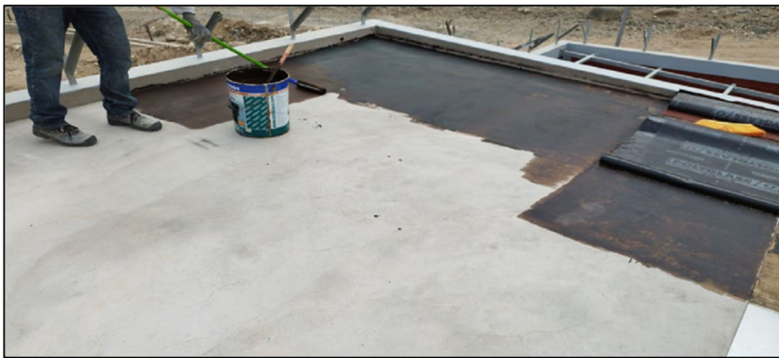
Fig. 121 Colocación de impermeabilizante en losa de aligerada
