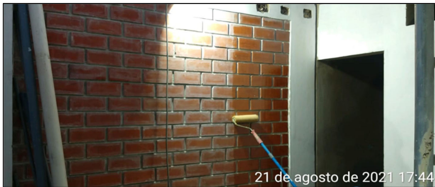
Fig. 116 Colocación de imprimante en Muro Interior de Cerco Perimétrico
