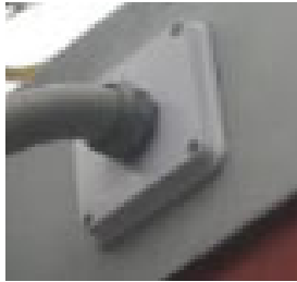
Fig. 43 Caja de paso empotrada.
