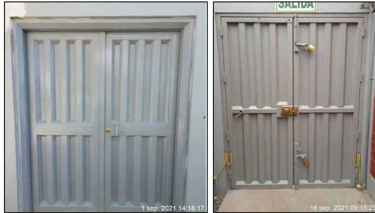
Fig. 132 Instalación de Estructura Metálicas Menores – Puerta acanalada
