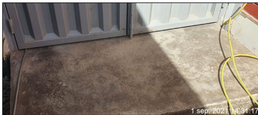
Fig. 109 Acabado de Losa de Ingreso
