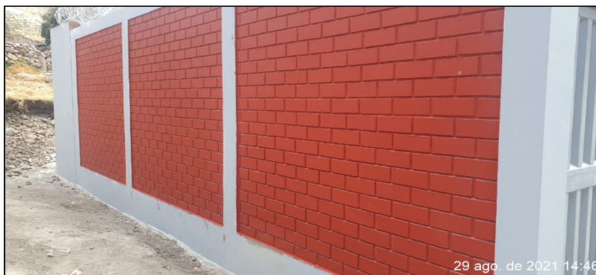
Fig. 120 Acabado de Muro exterior de Cerco Perimétrico
