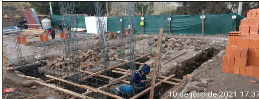
Fig. 72 Armado e Izado de aceros de columnas
