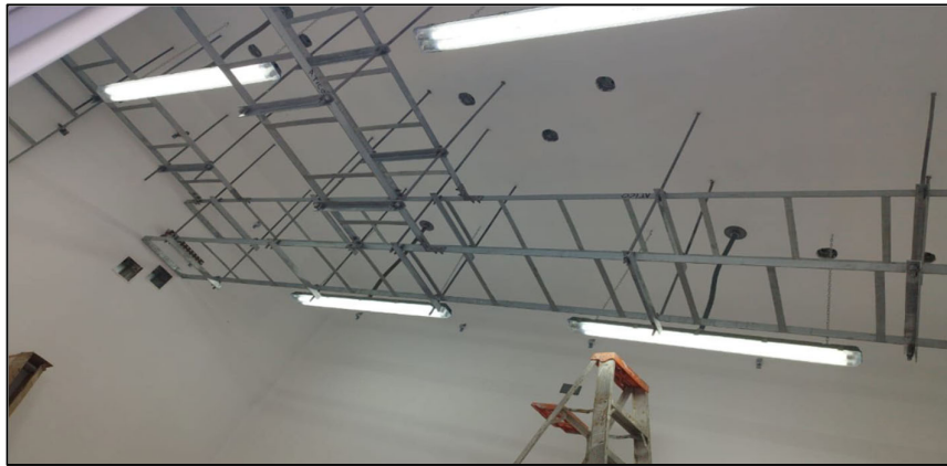
Fig. 127 Instalación de Estructura Metálicas Menores – Escalerillas
