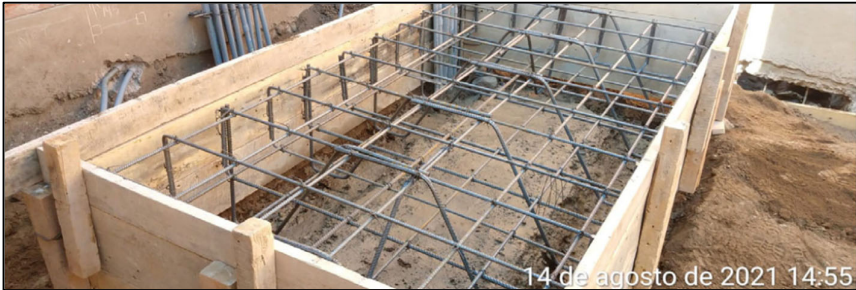
Fig. 103 Armado de acero en Losa Maciza de Grupo Electrónico
