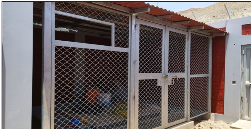
Fig. 128 Instalación de Estructura Metálicas Menores – Cercos de Malla
