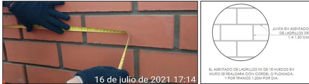
Fig. 76 Verificación de Junta de ladrillos
