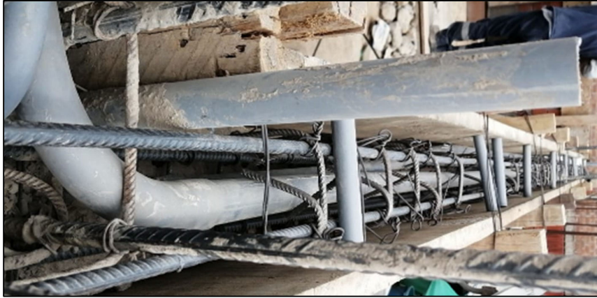
Fig. 83 Pase de tuberías en vigas
