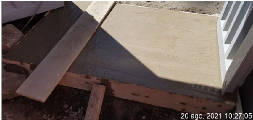
Fig. 108 Frotachado de Losa de Ingreso
