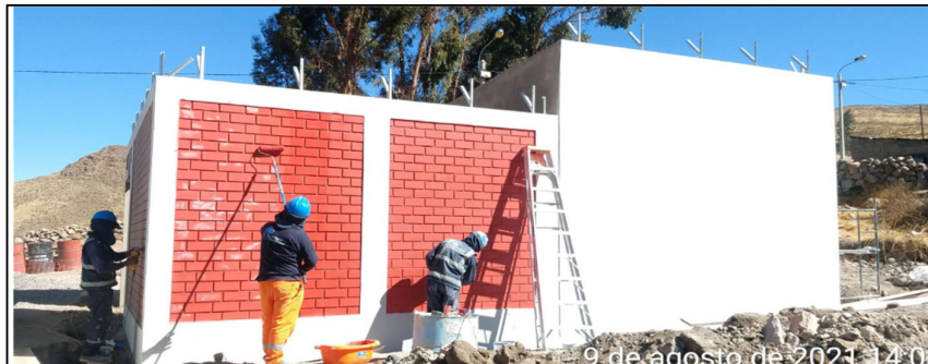
Fig. 118 Pintado Exterior de Muro lateral derecho de Cerco perimétrico y Sala de Equipos
