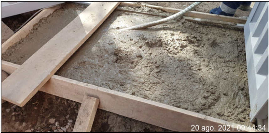
Fig. 107 Vaciado de concreto en Losa de Ingreso
