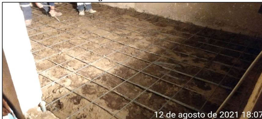
Fig. 97 Colocación acero en Sala de Equipos
