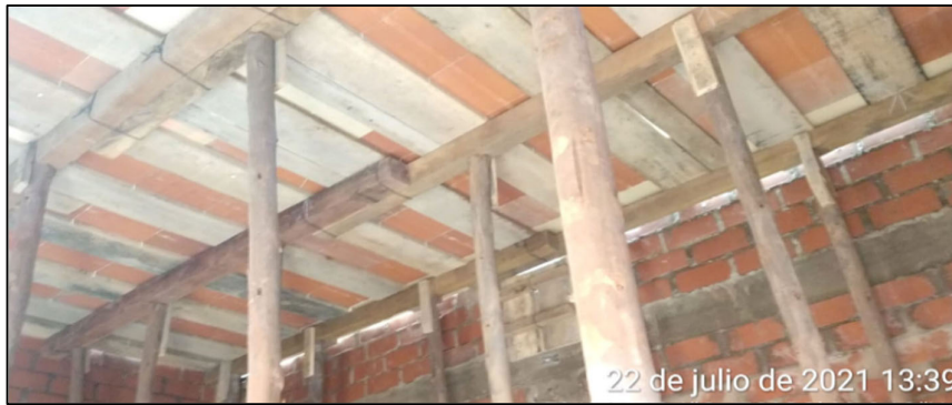
Fig. 86 Encofrado de losa aligerada en sala de equipo
