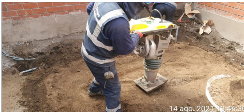
Fig. 100 Compactación en Sala de Fuerza
