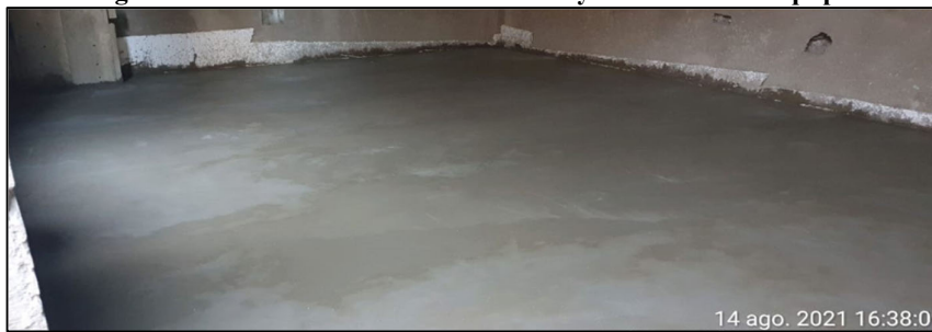
Fig. 99 Vaciado de Losa Maciza en Sala de Equipos
