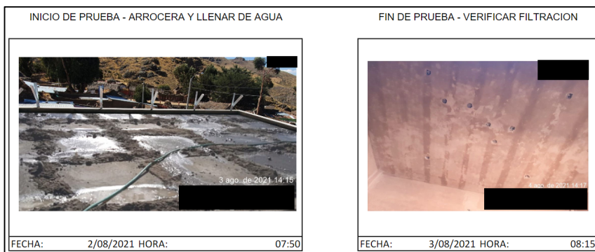
Fig. 91 Protocolo de Estanqueidad en Losa Aligerada
