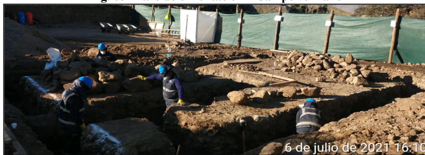
Fig. 68 Trazo de cimentación – Campo vs Plano
