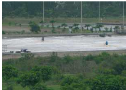
Figura 9: Sistema de lagunas aireadas que emplean aireadores mecánicos
