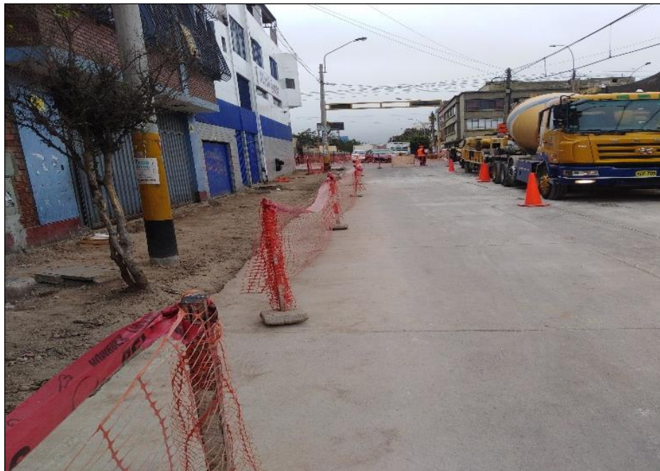
Figura 13. Señalización en obra
