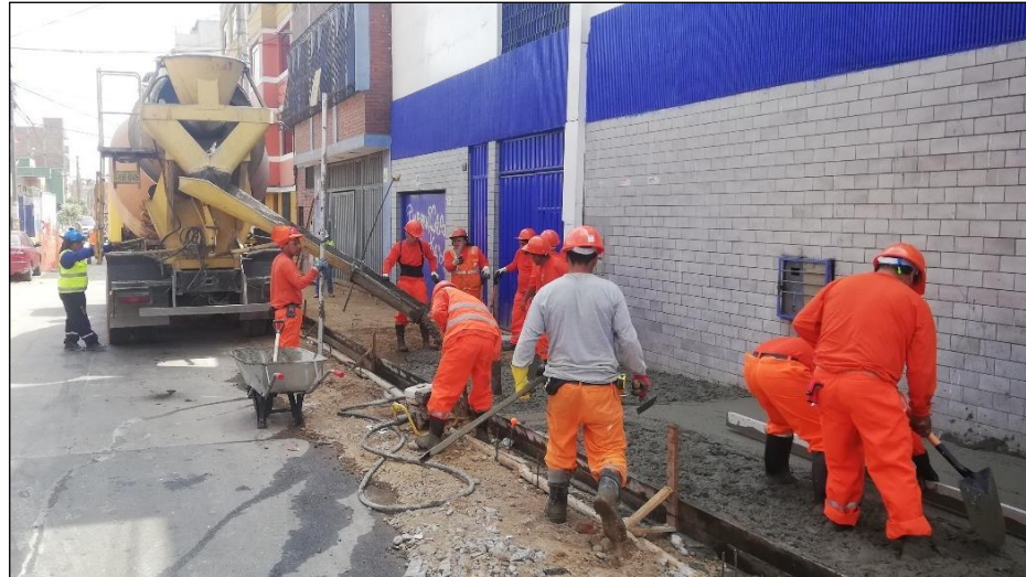
Figura 20. Colocación de concreto en veredas
