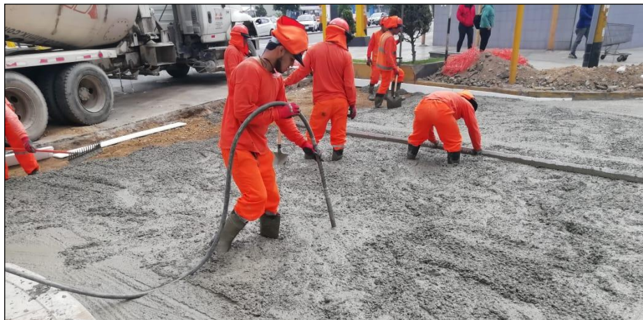
Figura 17. Colocación de concreto premezclado en bacheos
