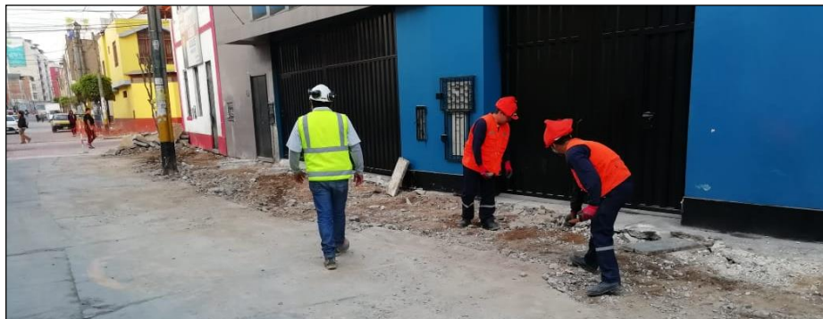
Figura 19. Excavación del terreno para veredas
