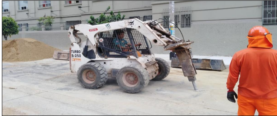
Figura 14. Demolición de pavimento rígido
