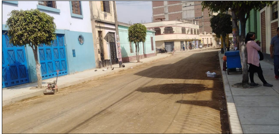
Figura 16. Colocación de base granular
