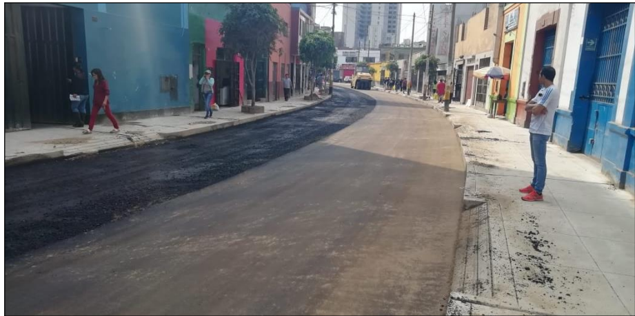
Figura 18. Colocación del pavimento asfáltico en caliente
