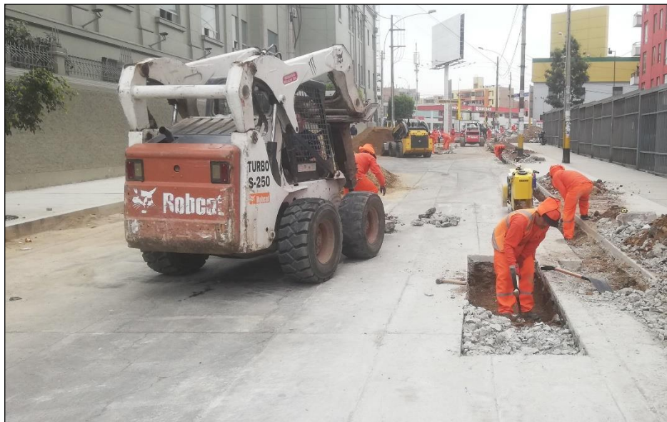
Figura 15. Excavación del terreno a nivel de subrasante
