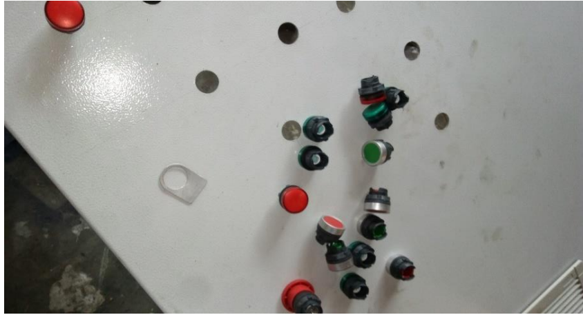
Fig. 16: Pulsadores a instalar en tablero auto soportado
