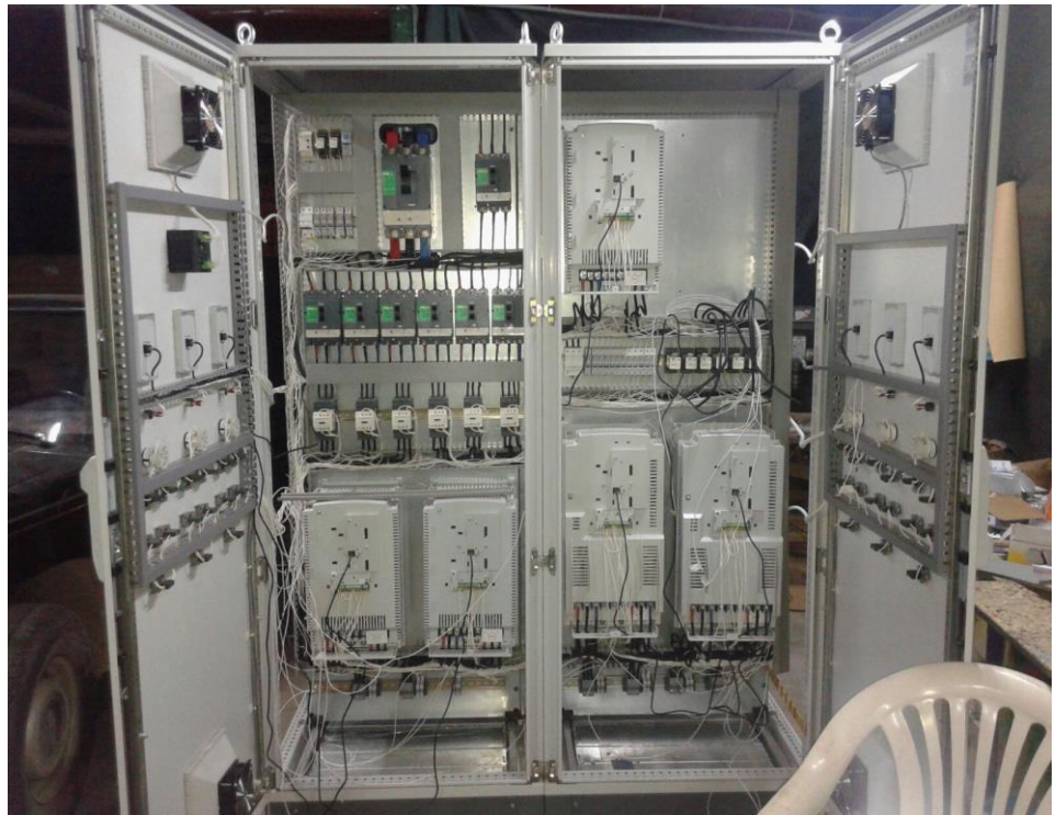
Fig. 18: Instalación de componentes y elementos principales en tablero auto soportado
