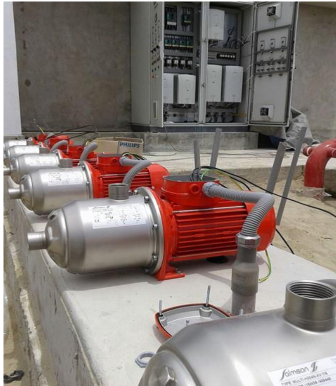
Fig. 22: Instalación de sistema de riego automatizado con variadores de frecuencia en tablero auto soportado
