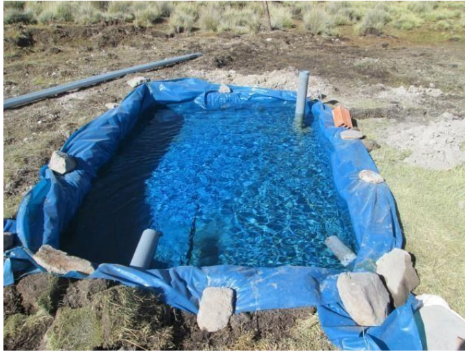
Figura 4, Desarenador No.3
