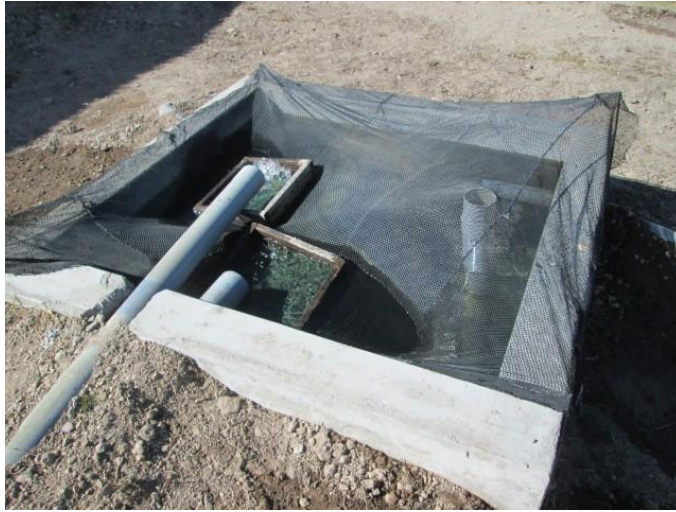
Figura 2, Reservorio de agua No 1
