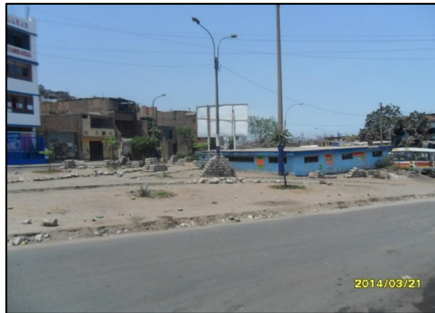
Figura 8. Estación de bombeo Booster N° 2
