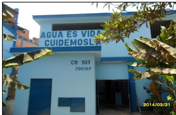
Estación de bombeo CR-101
