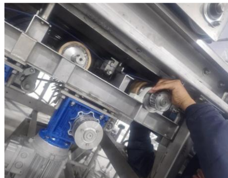
Desmontaje de chumacera
