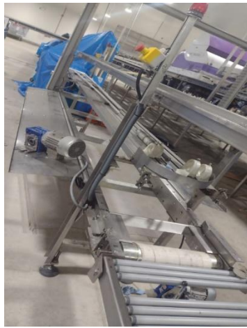
Desmontaje de motores
