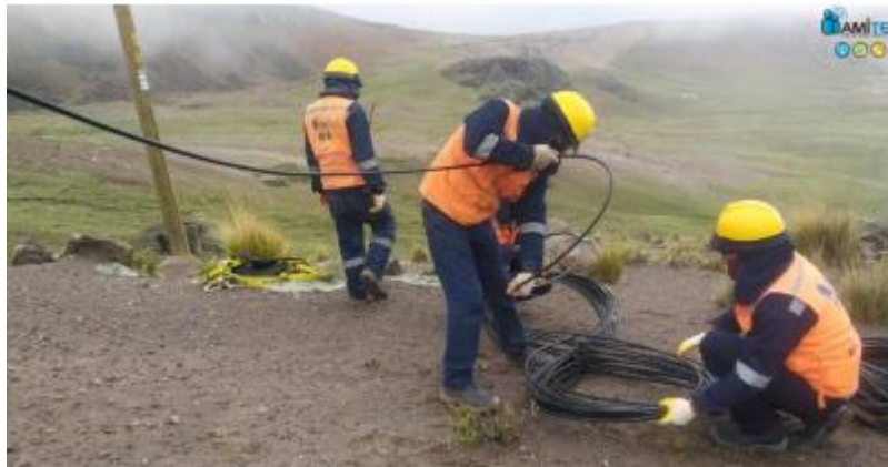
Extracción del cable en forma de 8
