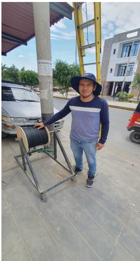
Fig. 18. Carrete de fibra para instalación
