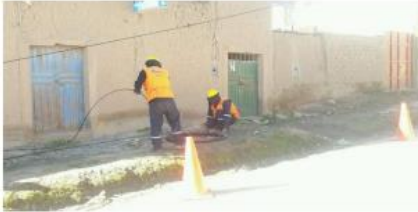
Extracción del cable de fibra óptica
