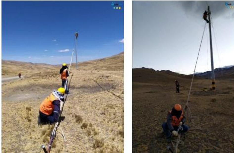
Flechado del cable de fibra óptica
