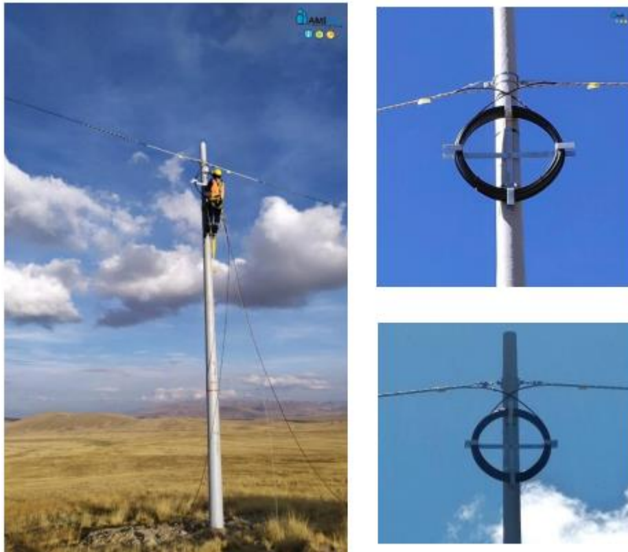
Instalación de crucetas
