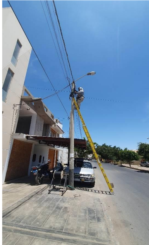
Fig. 19. Instalación de los templadores, para seguridad de la fibra.
