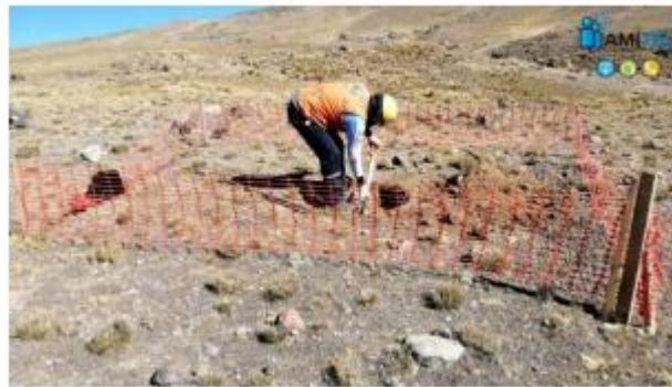
Delimitación del área de instalación
