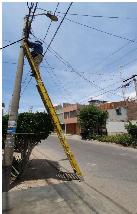
Fig. 17. Instalación del NAP principal de comunicaciones
