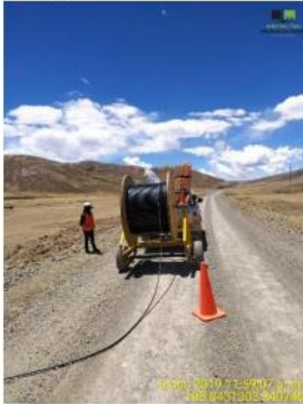
Tendido de la fibra óptica
