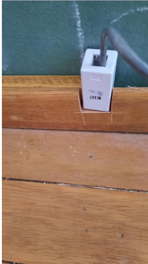
Fig. 38. Toma de datos de una salida
