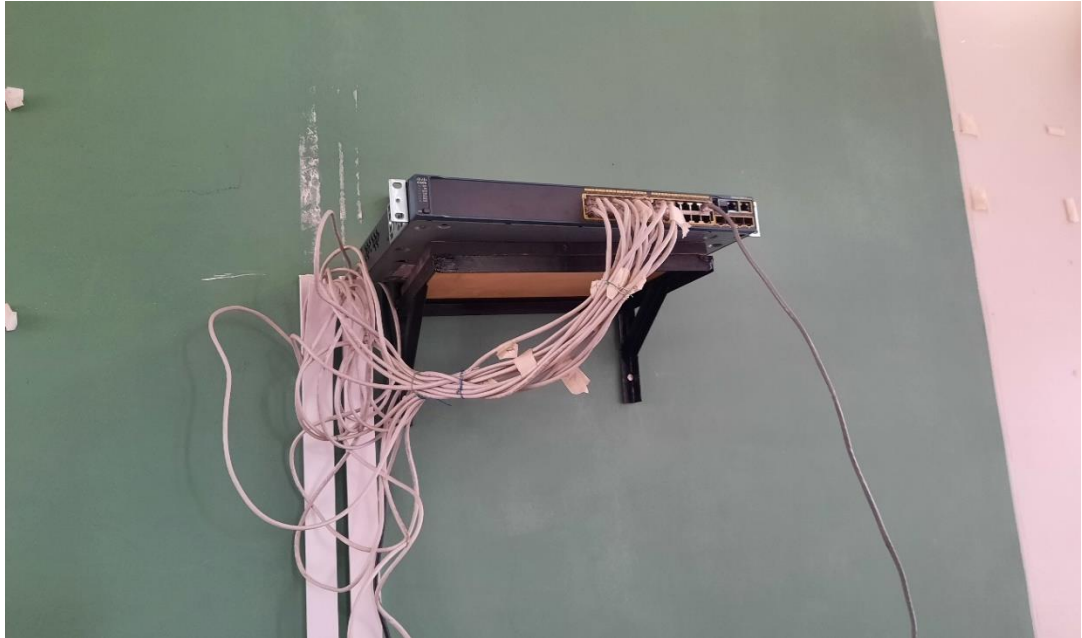
Fig. 5 Estado del switch de comunicaciones
