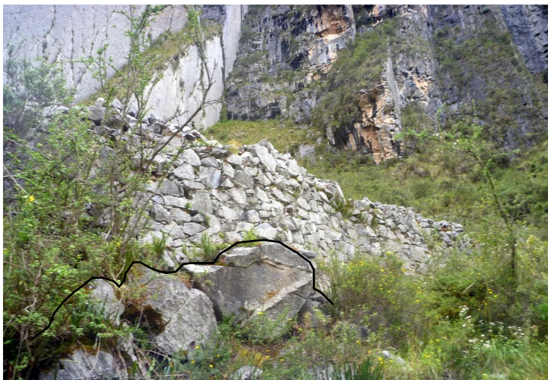
Foto 73: Aprovechamiento de las rocas grandes en la conformación de la base del andén. Fuente: Franclyn Jayo; 2022
