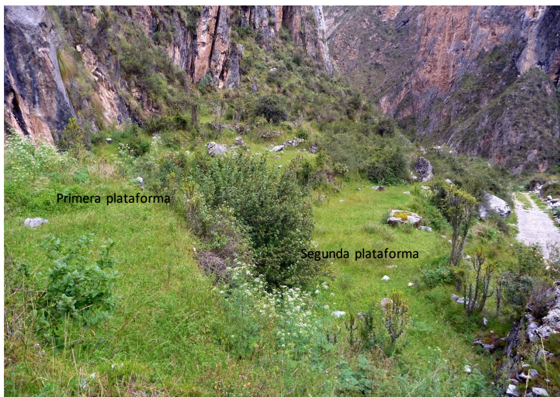
Foto 50: Vista de dos plataformas consecutivas en los que el crecimiento de arbustos no permite observar los muros de contención. Fuente: Franclyn Jayo; 2022
