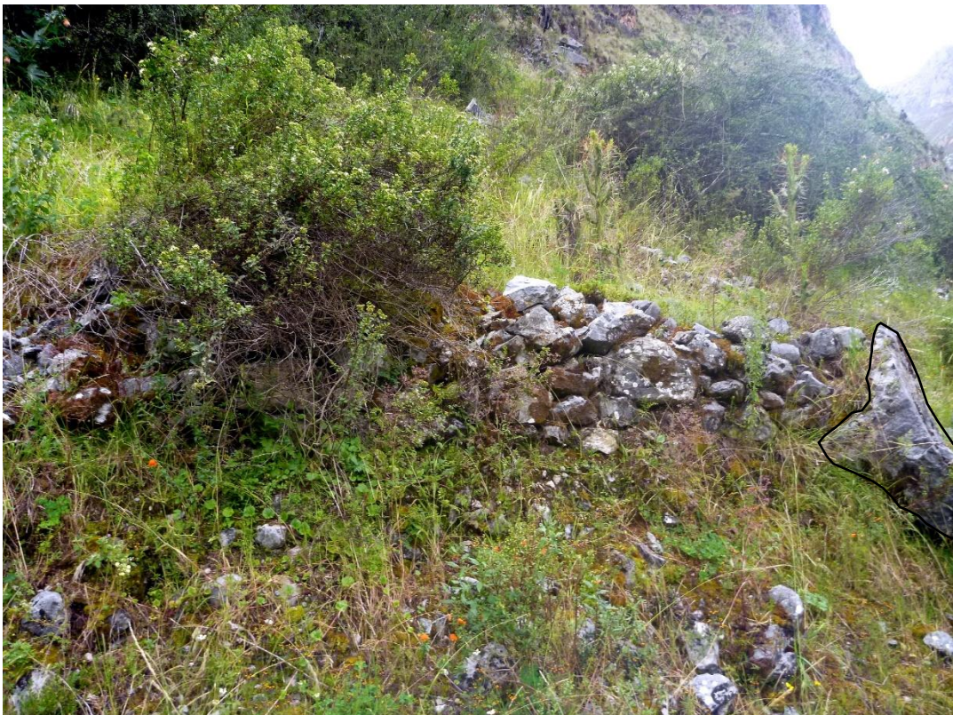
Foto 48: Muro de contención que aprovecha las grandes rocas que se encontraban dispersas en la ladera del cerro. Fuente: Franclyn Jayo; 2022
