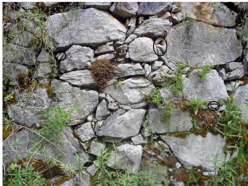
Foto 71: Pachillas en la conformación del muro de contención antes mencionado. Fuente: Franclyn Jayo; 2022
