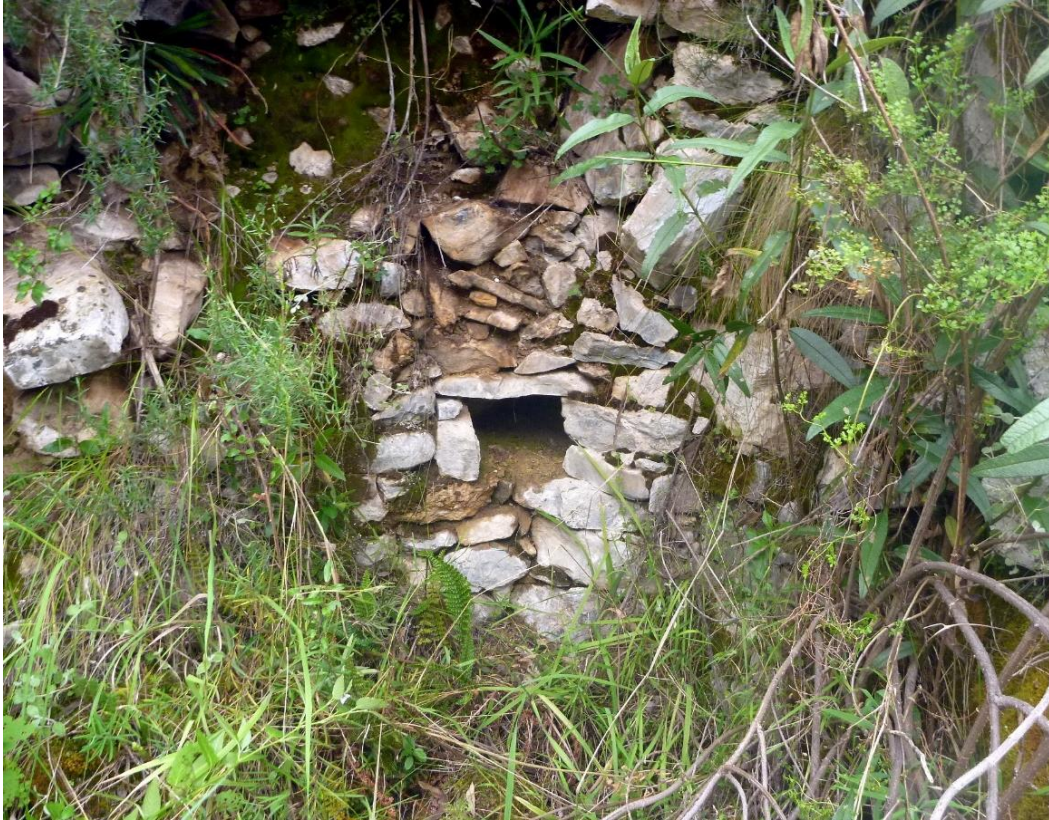
Foto 83: Nicho cuadrangular al interior de un recinto circular. Fuente: Franclyn Jayo; 2022
