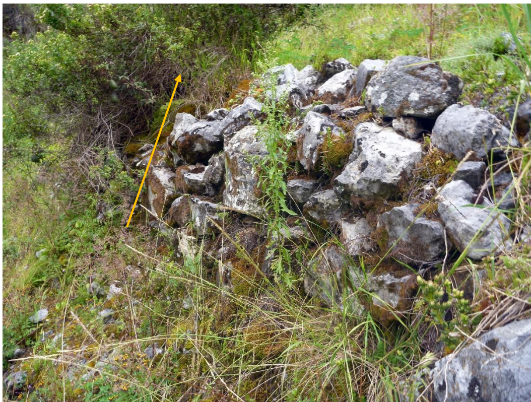
Foto 49: Muro arqueológico, cuya técnica constructiva muestra una ligera inclinación hacia el interior de la plataforma. Fuente: Franclyn Jayo; 2022
