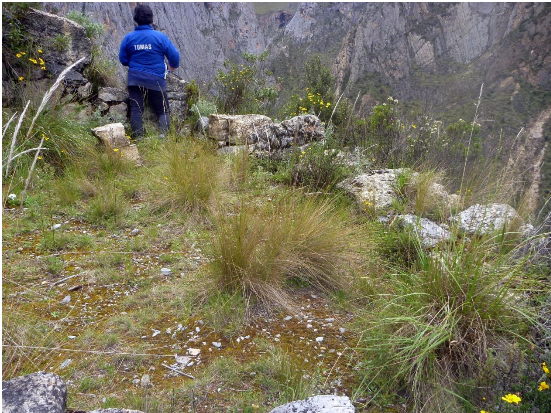
Foto 80: Vista de un recinto de planta cuadrangular, con los muros colapsados. Fuente: Franclyn Jayo; 2022
