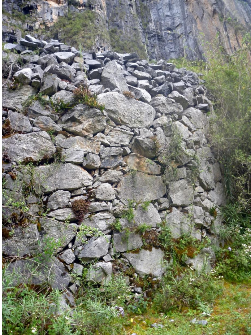
Foto 70: Muro de contención de un andén del segundo sector. Mide 7 m de altura. Fuente: Franclyn Jayo; 2022
