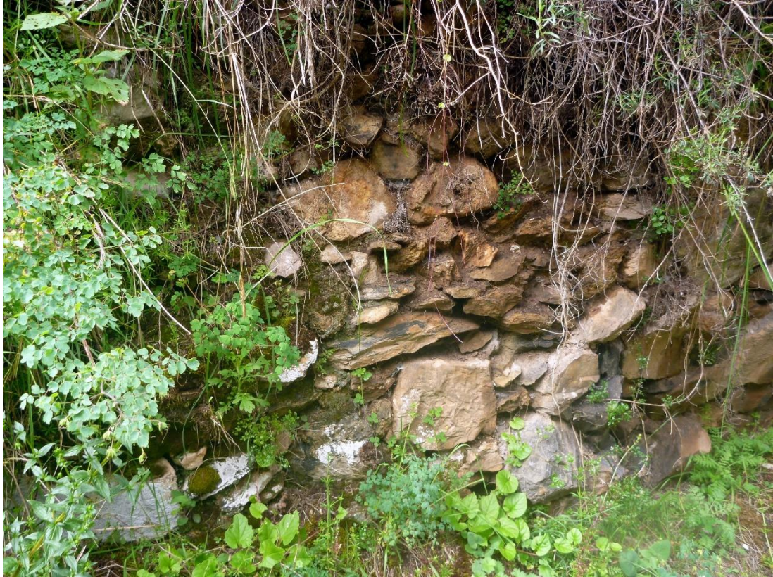
Foto 77: Paramento de un muro de contención. Nótese la argamasa en la unión de las piedras. Fuente: Franclyn Jayo; 2022
