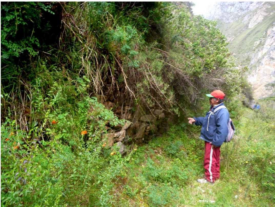
Foto 76: Muro de contención de 3 m de altura, cubierto por arbustos debido a la falta de uso. Fuente: Franclyn Jayo; 2022
