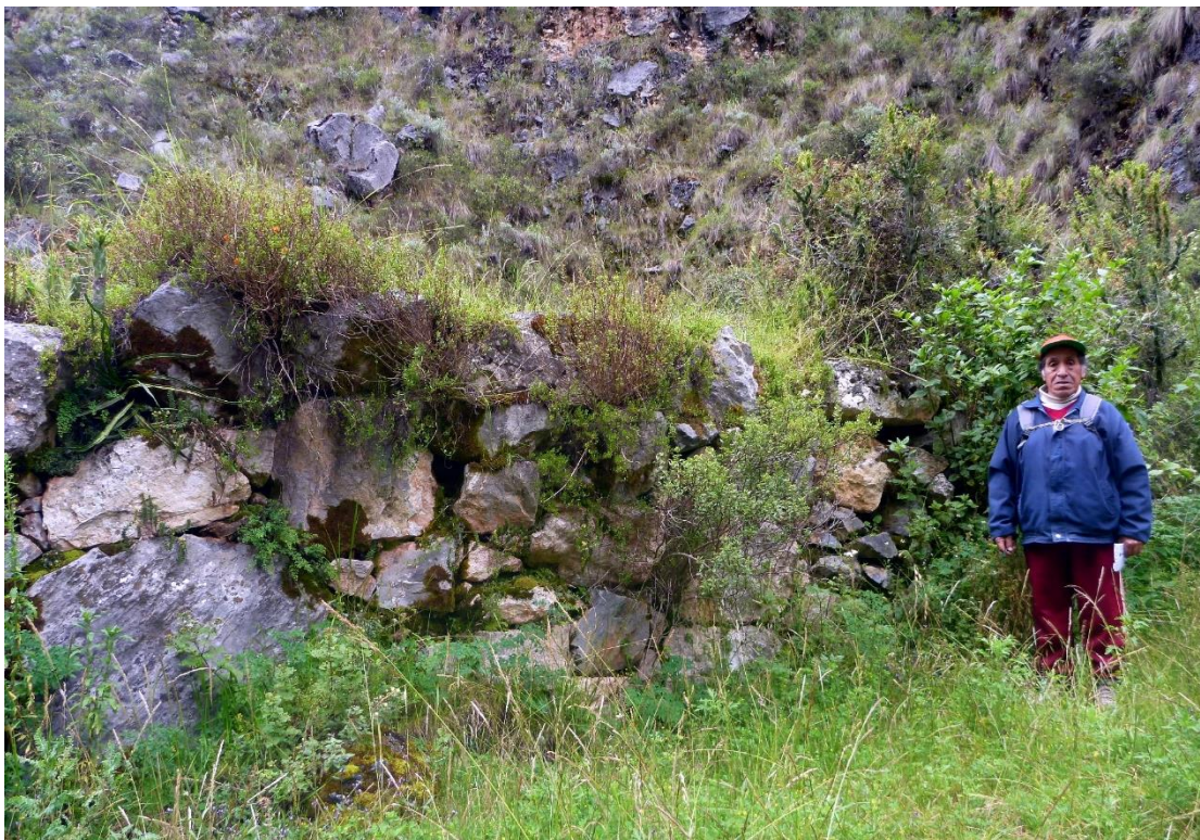
Foto 52: Andenes en la ladera alta, con un muro de contención de 1.60 m de altura. Fuente: Franclyn Jayo; 2022
