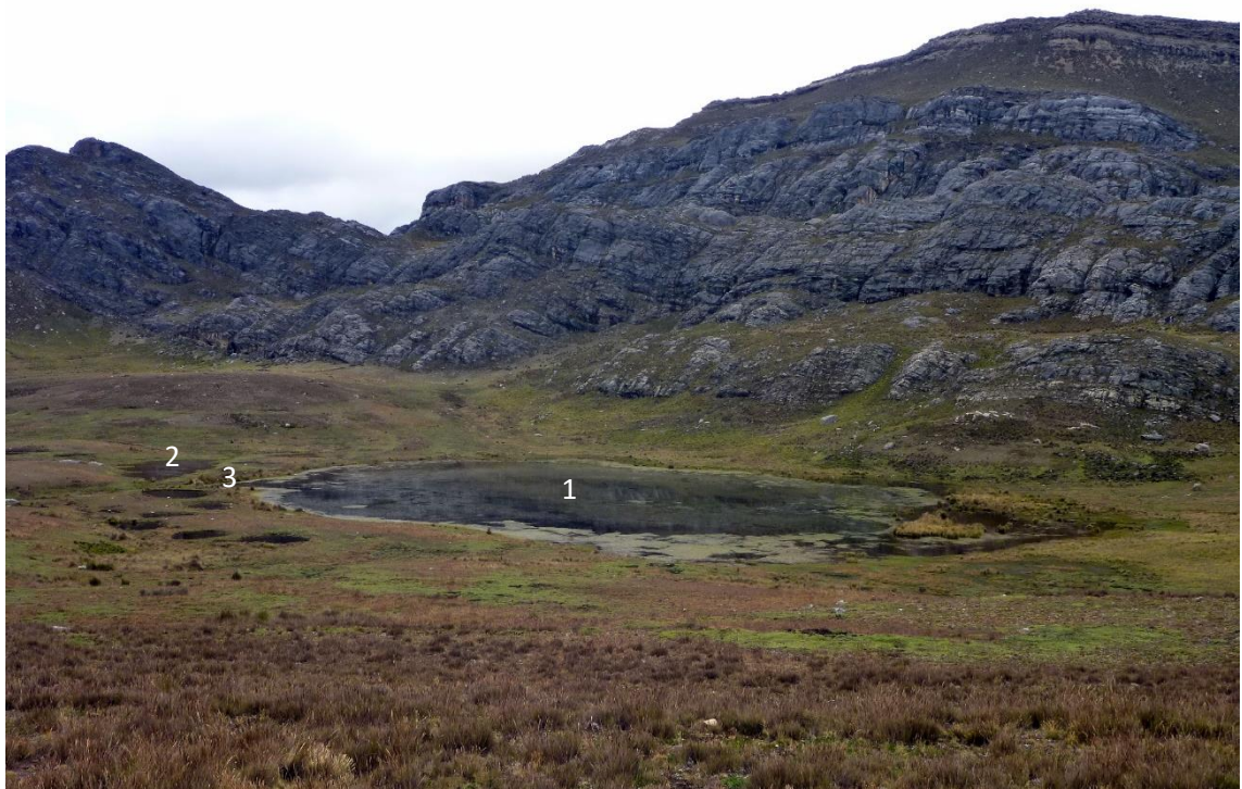
Foto 42: 1) represamiento, 2) ojo de agua por filtración de humedad, y 3) dique de tierra. Fuente: Franclyn Jayo; 2022
