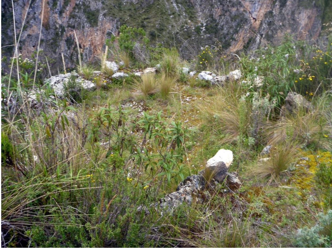
Foto 81: Vista de un recinto de planta cuadrangular, con los muros colapsados. Fuente: Franclyn Jayo; 2022
