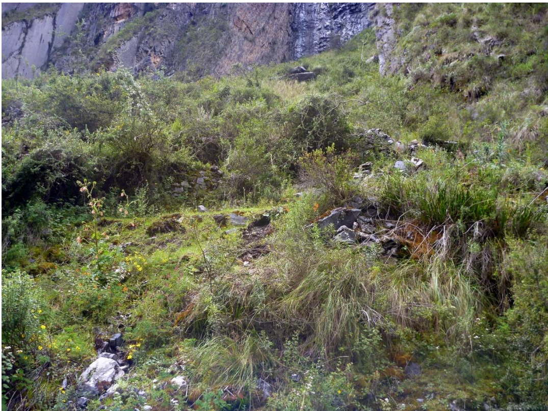
Foto 74: Andenes ubicados en la ladera media del cerro. Lo tupido de los arbustos dificultan la identificación de los muros de contención. Fuente: Franclyn Jayo; 2022
