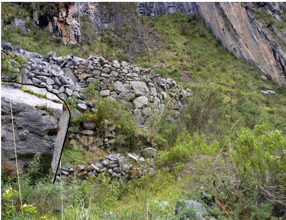
Foto 72: Aprovechamiento de las grandes rocas en la conformación del muro de contención. Fuente: Franclyn Jayo; 2022
