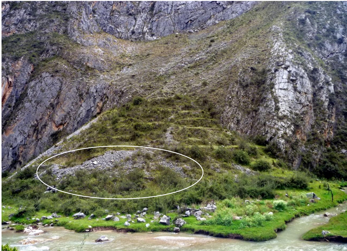
Foto 46: Tercer grupo de andenes en la margen derecha. Se resalta el espacio afectado por el colapso de los muros y el deslizamiento del relleno constructivo de los andenes.
