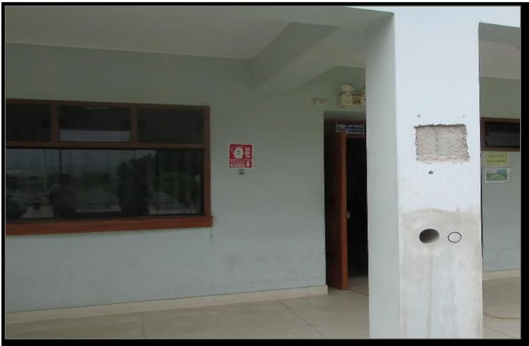
Figura 12: Picado de zona para ensayo de esclerometría
