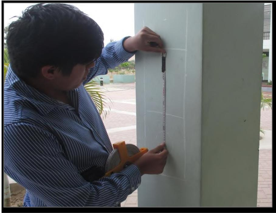
Figura 05: Trazo de ejes de ubicación del refuerzo
