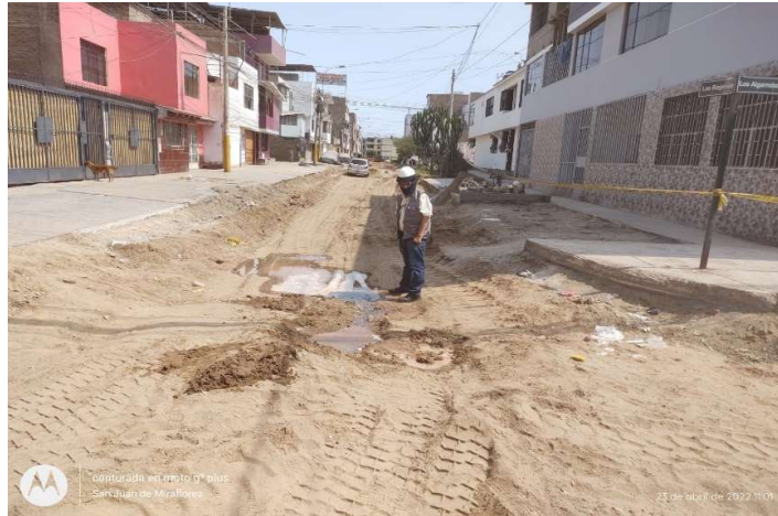
Fotografía 1. Corte de pavimento a nivel de subrasante
