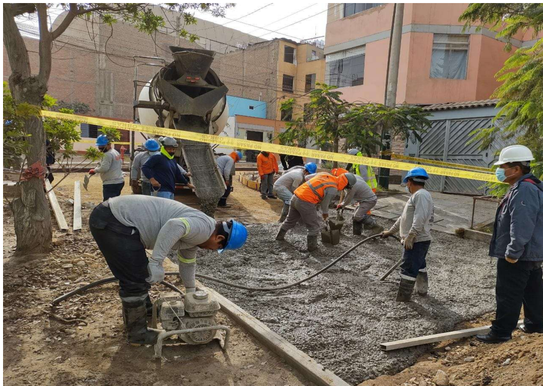
Fotografía 8. Vaciado de concreto de losa de concreto del pavimento rígido
