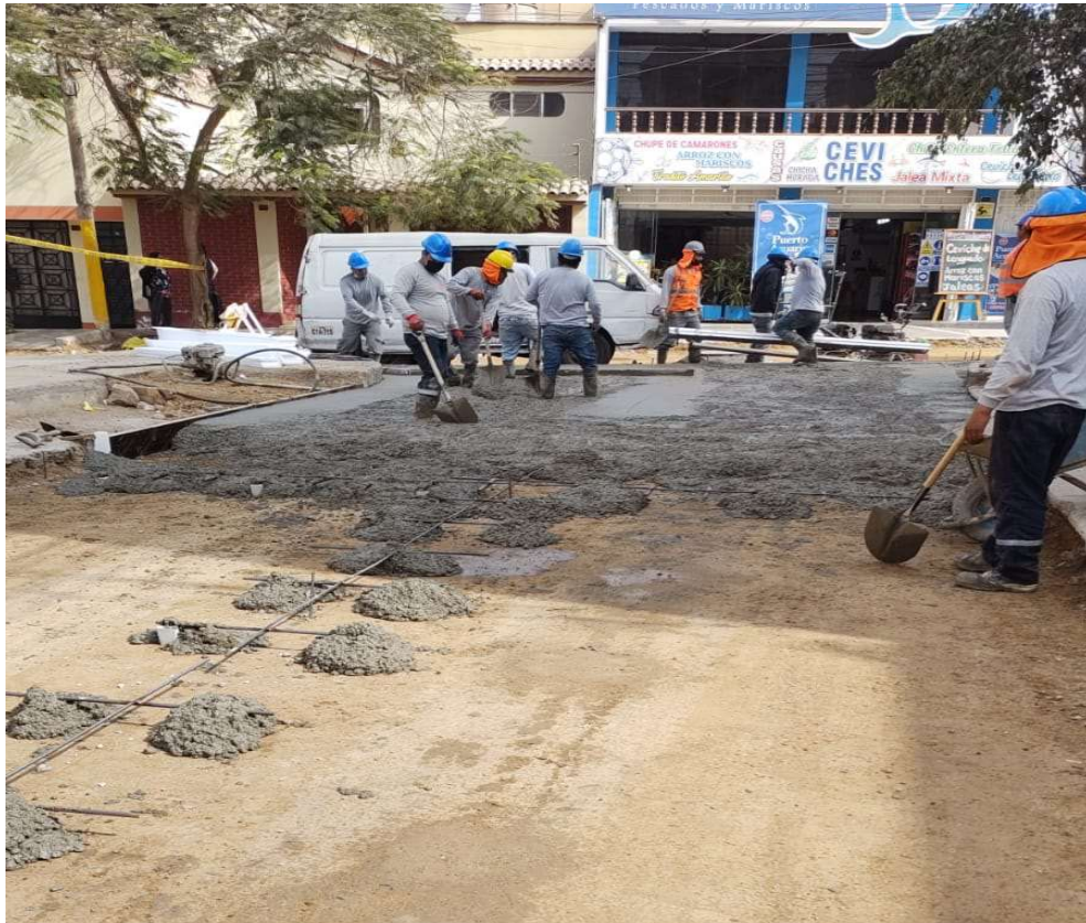
Fotografía 7. Colocación de tacos y niveles para vaciado de losa de concreto del pavimento rígido
