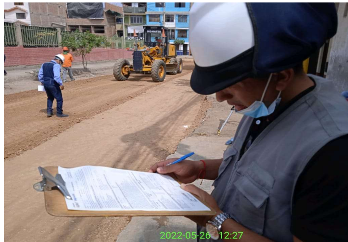
Fotografía 2. Colocación de afirmado a nivel de base
