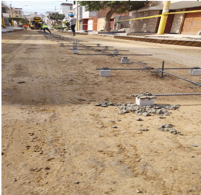
Fotografía 6. colocación de dowels y varilla de acero según detalle de planos
