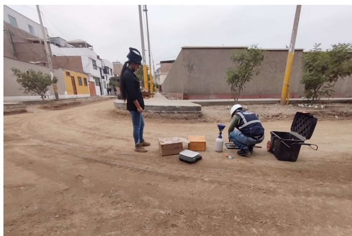
Fotografía 3. Ensayo de densidad de campo in situ para verificar el grado de compactación de la base
