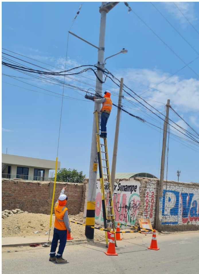
Figura N°4: Acondicionado de una mufa nodal.
