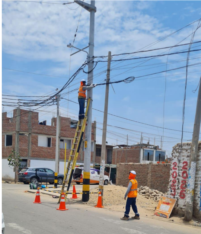
Figura N°3: Supervisión de instalación.
