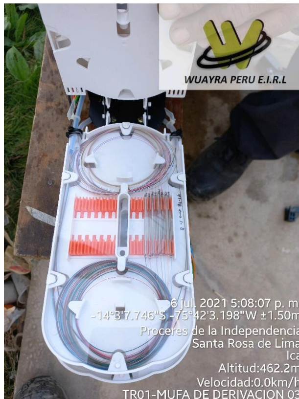
Figura N°13: Vista frontal de la primera bandeja de FO instalada en el poste 3.
