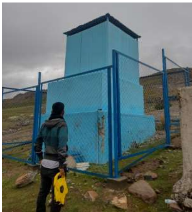
Fig. 10: Reservorio del Anexo Unión Santa Rosa
