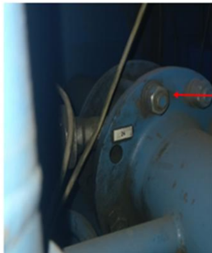
FIG. 1 Puntos de fijación de la brida que sostiene al sensor de flujo
