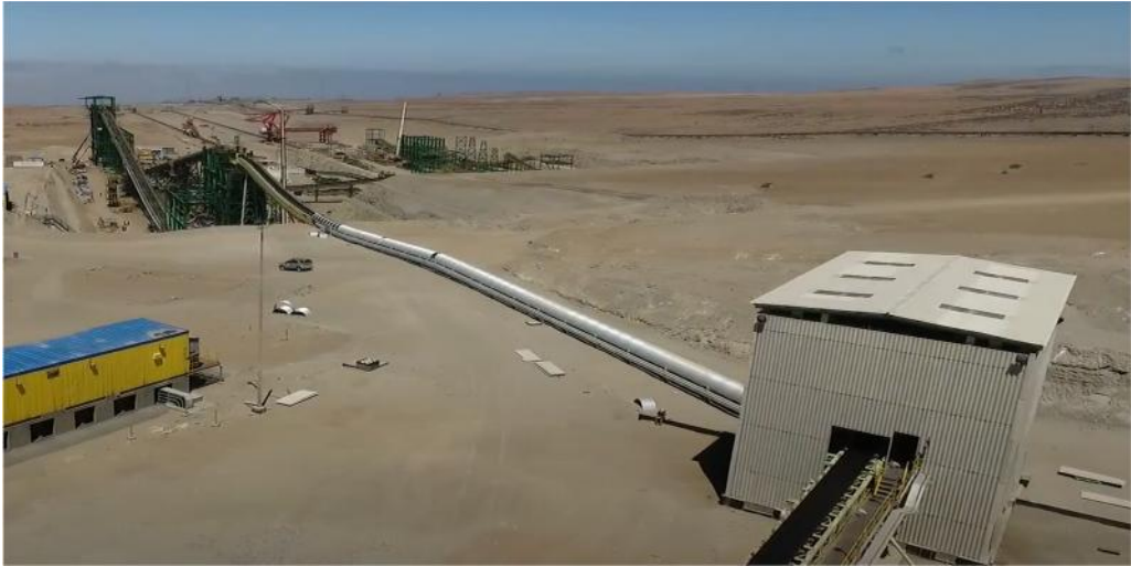
Fuente: Departamento de Planeamiento y Control de Mantenimiento Abengoa – Shougang Hierro Perú (2020)
