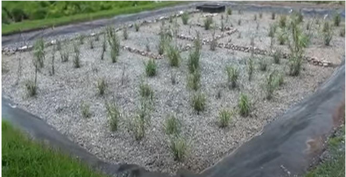
Figura 10 Piscina - Humedal de flujo subsuperficial
