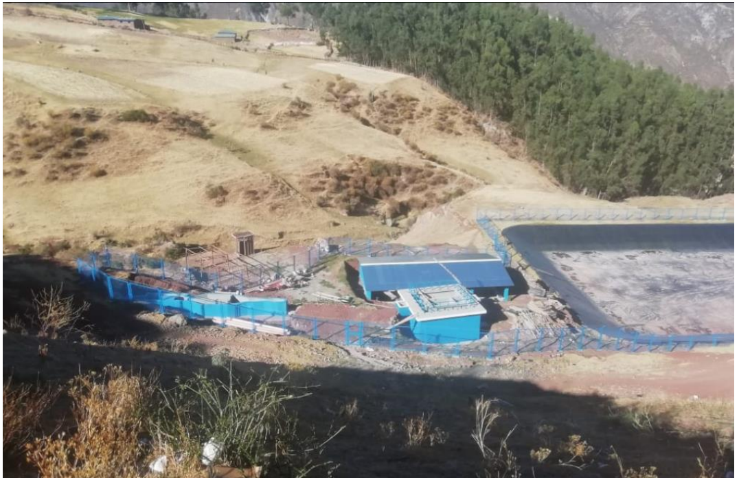
Figura 6 “Humedal de flujo subsuperficial” - Distrito Lucanas
