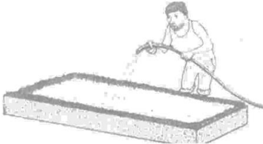
Fig. 6 Forma de realizar el curado.
