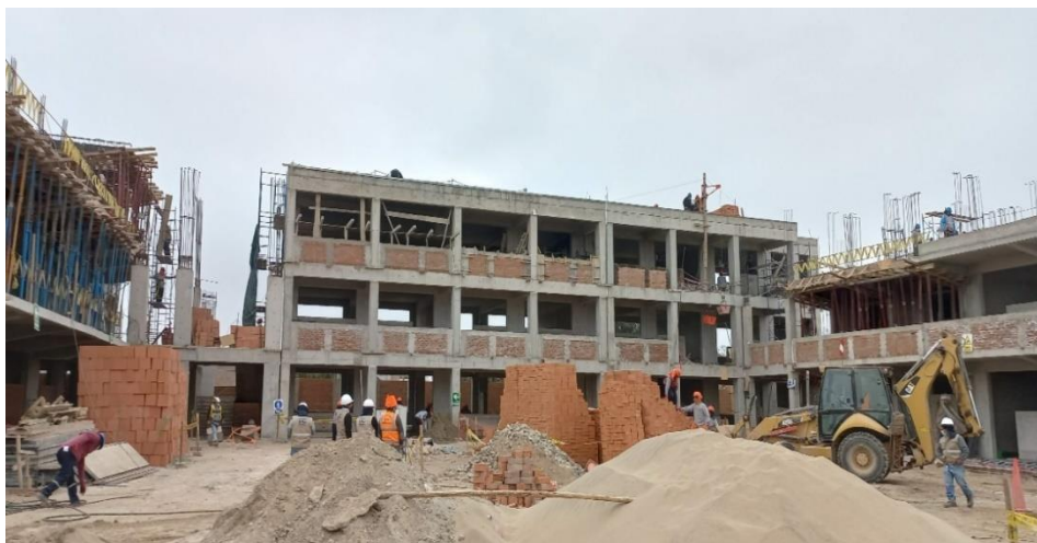
Levantamiento de muros no portantes en el sector 05.
