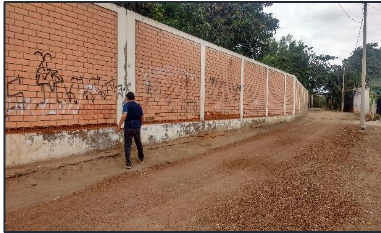
Figura 9. Vista externa del cerco perimétrico de la I.E. antes de la construcción
