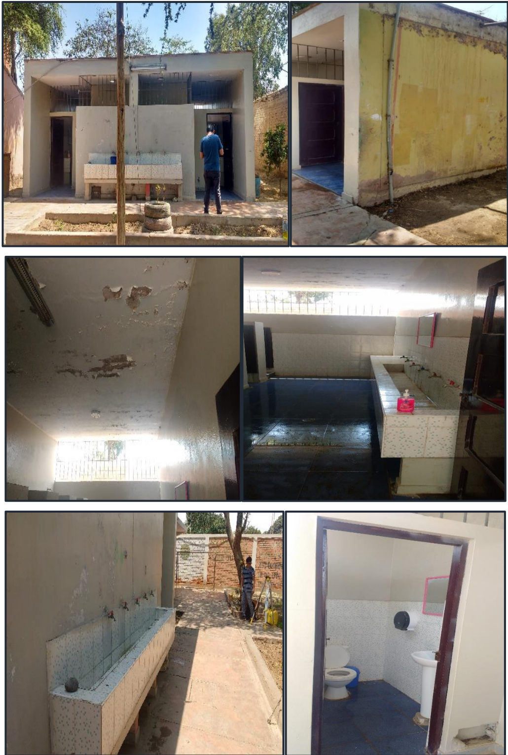
Figura 8. Servicios higiénicos antes de la construcción
