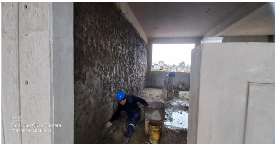
Trabajadores realizando el tarrajeo primario en el laboratorio de ciencias.
