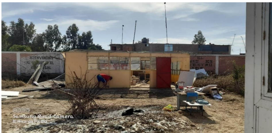
Desmontaje de estructuras existentes
