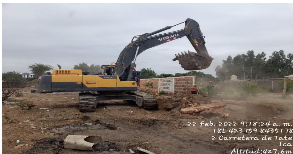
Demolición de muro perimétrico existente.
