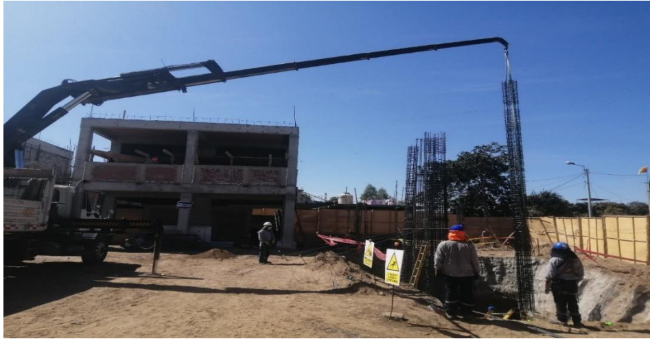
Instalación de armadura de columnas del cuarto de máquinas.
