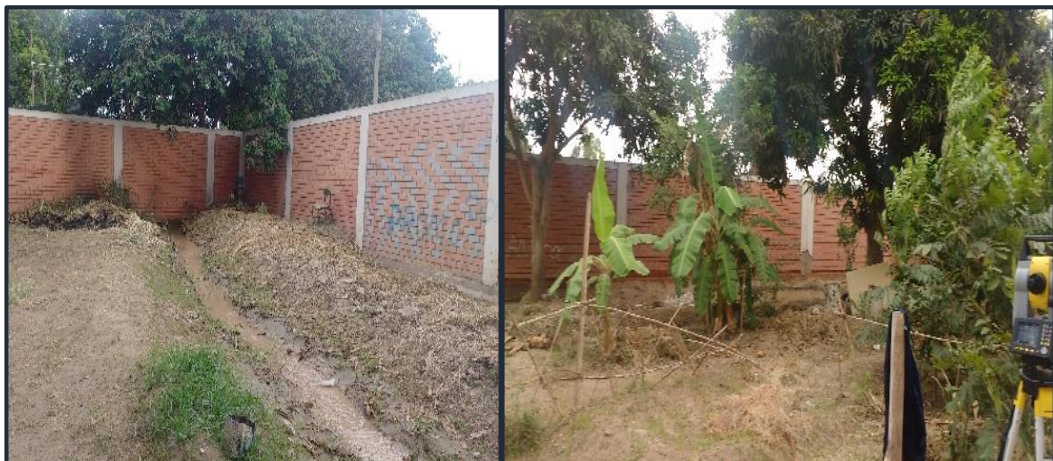
Figura 10. Vista interna del cerco perimétrico de la I.E. antes de la construcción
