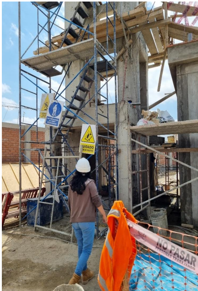
Vista del pórtico del cuarto de máquinas.
