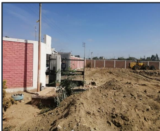
Figura 6. Vista panorámica de la I.E. antes de la construcción
