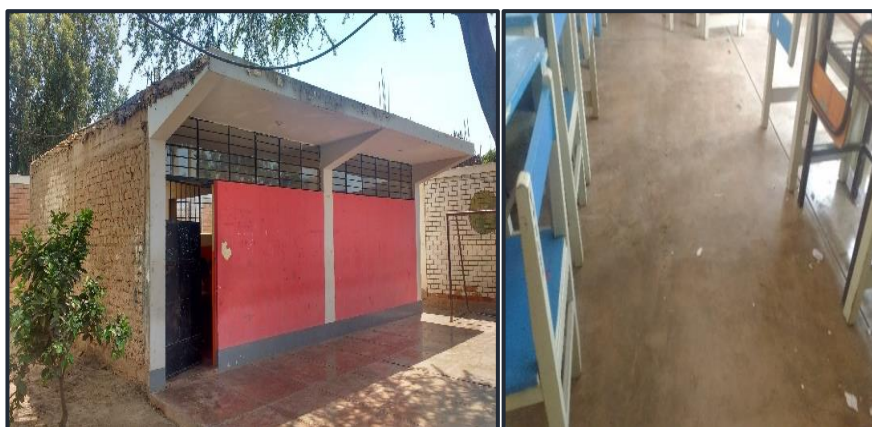
Figura 7. Módulo de aula antes de la construcción
