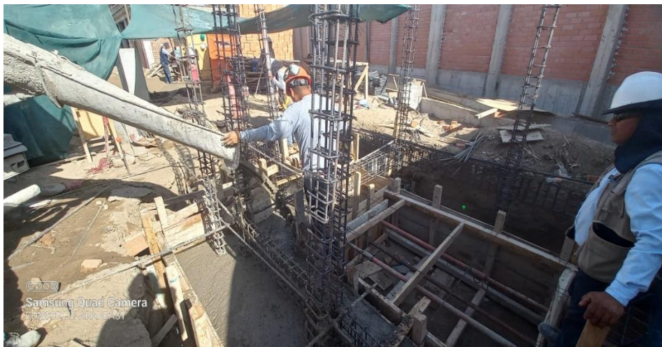
Vaciado de concreto en cimentación.
