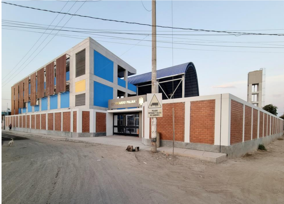
Vista de la fachada del colegio con la obra ya terminada.
