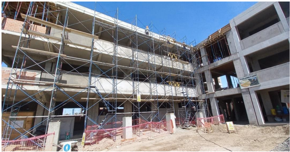
Vista del tarrajeo de los muros en el sector 01.
