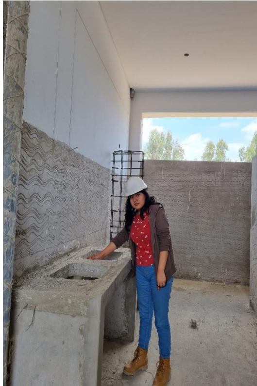
Vista de una mesa de concreto sin acabados.
