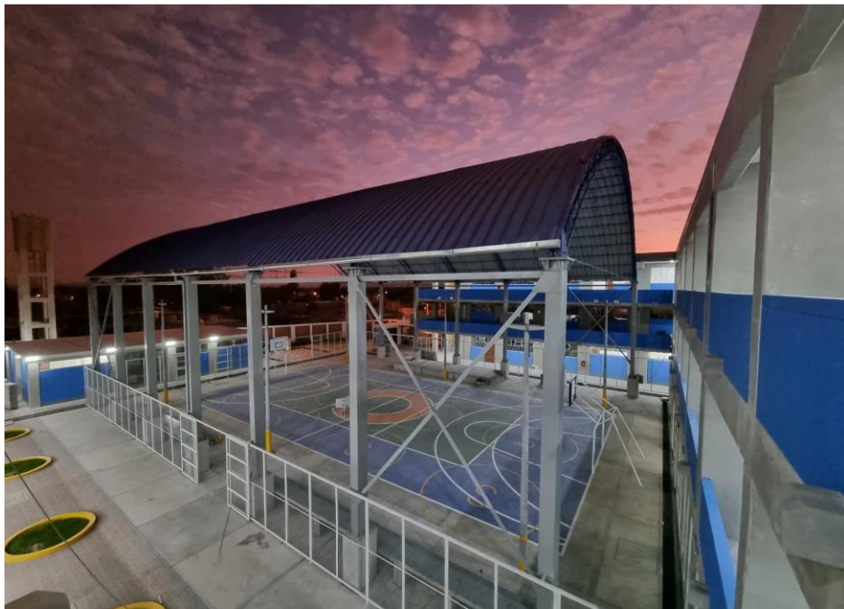
Vista de la losa deportiva y cobertura metálica terminada.
