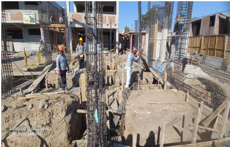
Vaciado de concreto para cimentaciones armadas.
