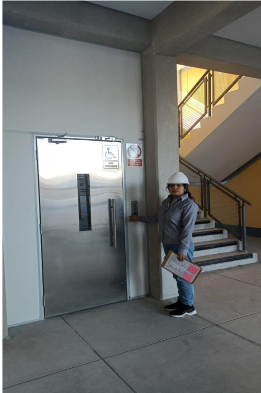
Vista del elevador vertical instalado.
