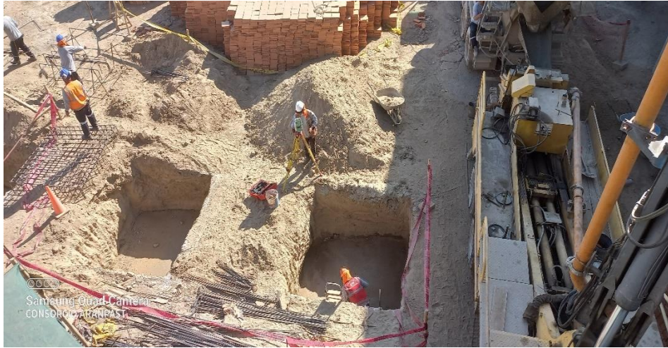
Control de niveles en excavaciones de zapatas.
