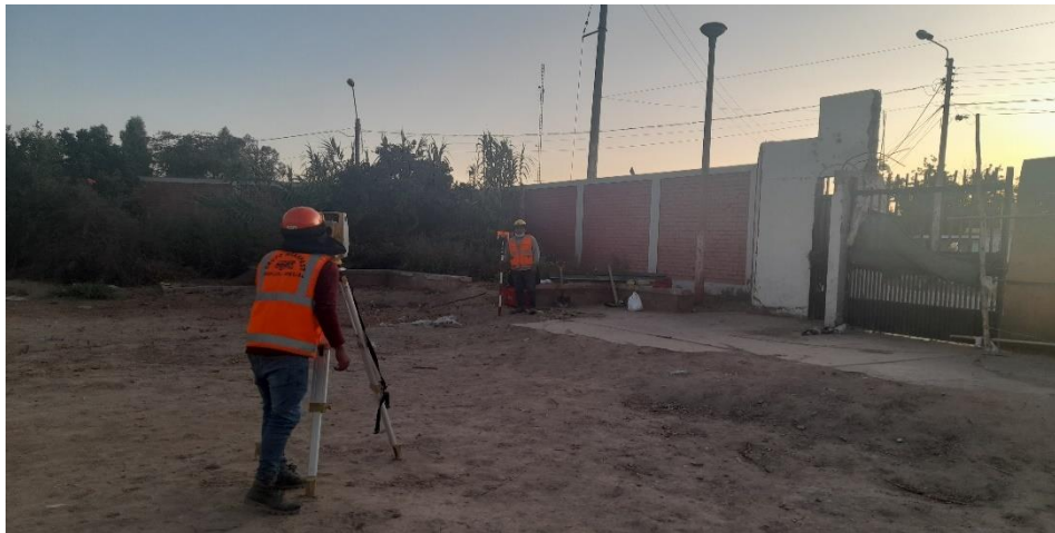
Levantamiento topográfico con estación total.
