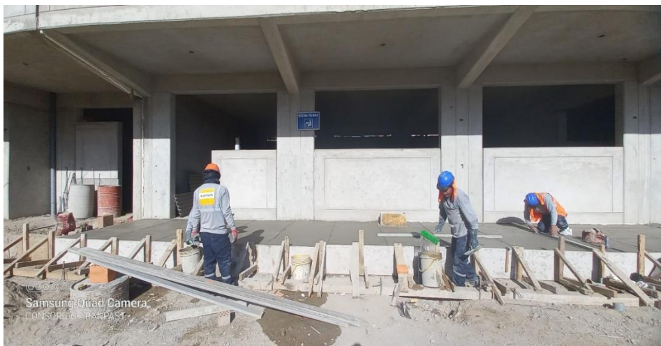
Trabajadores haciendo las brujas en las veredas de concreto.
