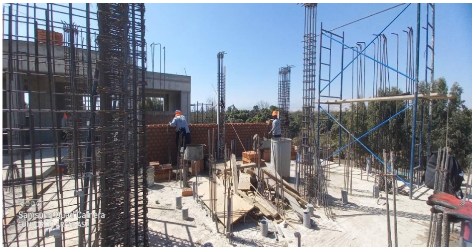
Levantamiento de muros portantes en el sector 04.
