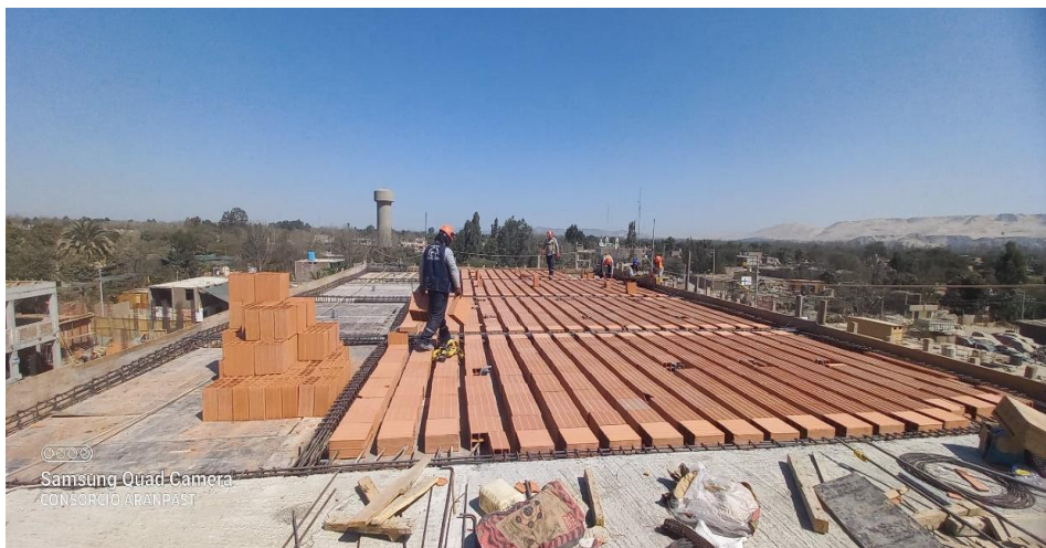
Colocación de ladrillos para techos en losa aligerada del 3er piso en el sector 01.
