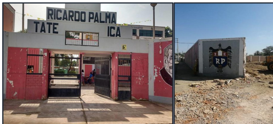
Figura 5. Fachada de la I.E. Ricardo Palma antes de la construcción
