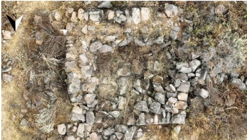
Figura 13: Vista de la planta de la estructura cuadrangular donde ofrece una visión detallada de la disposición precisa del material de construcción.
