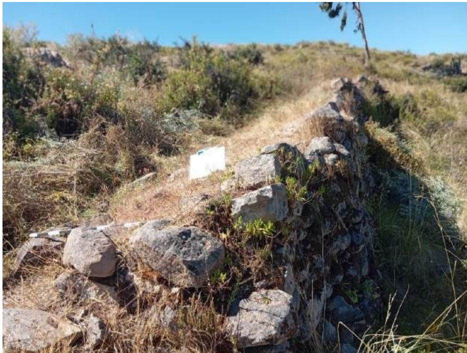
Figura 80: Vista de la conservación del muro que aún se mantiene.
