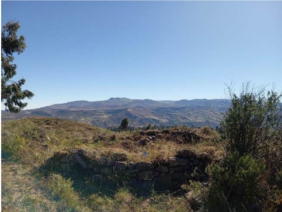
Figura 55: Vista a detalle del muro de la estructura N° 05 del sector B. Fuente: M.R.C.
