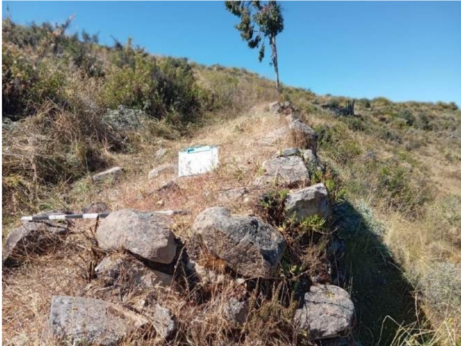
Figura 81: Estado actual del área donde se observa la continuidad del muro 3.
