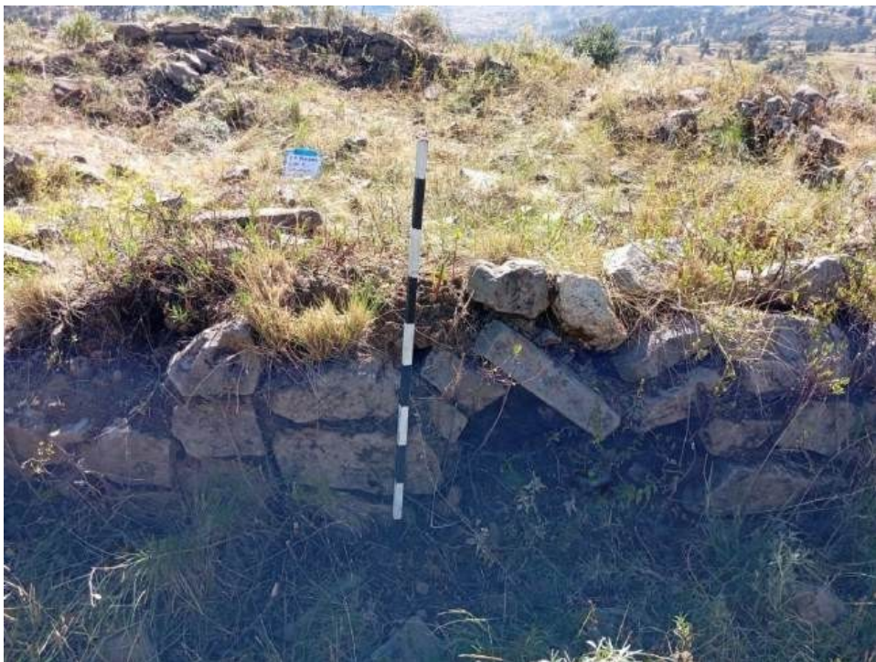
Figura 56: vista del muro a detalle, expone un ordenamiento y adherido con argamasa de tierra.
