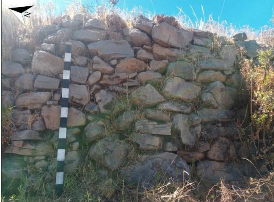
Figura 21: Vista frontal del muro 2 que circunda todo el sector A.
