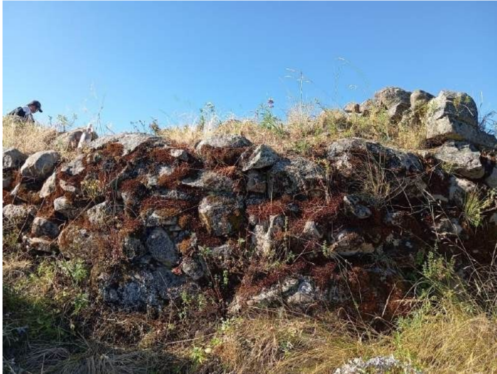
Figura 67: muro que presenta una buena conservación y expone la tecnología constructiva del sector B y la estructura 07.
