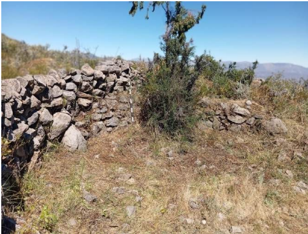
Figura 35: Lado este de la estructura 2 del sector b que ha sido reutilizado como parte de un muro.
