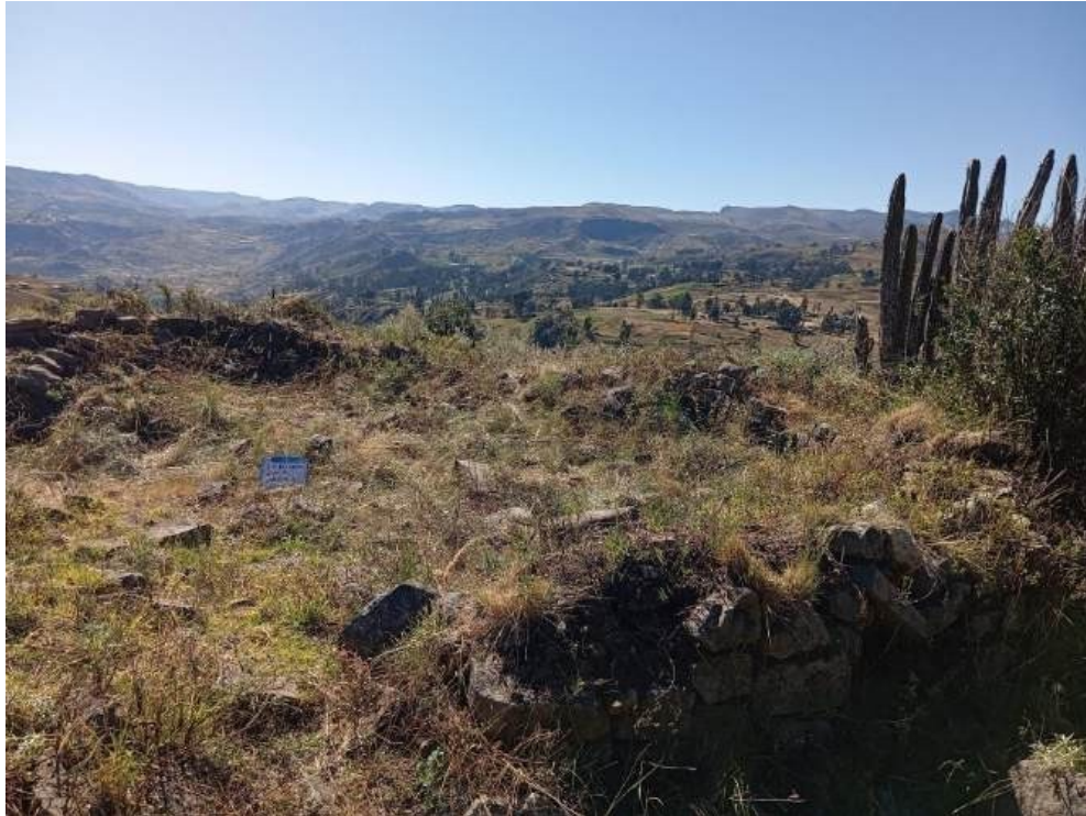
Figura 57: se observa la tecnología constructiva que han llevado a cabo, de doble hilera adherido con argamasa de tierra.
