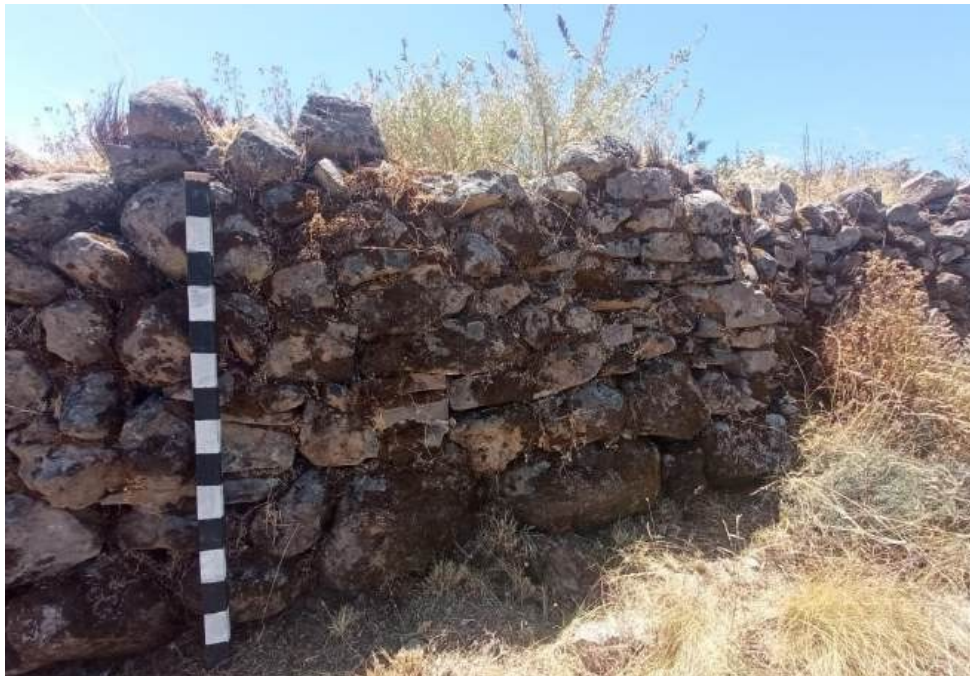
Figura 78: vista a detalle de la tecnología constructiva, y los materiales del muro 3.
