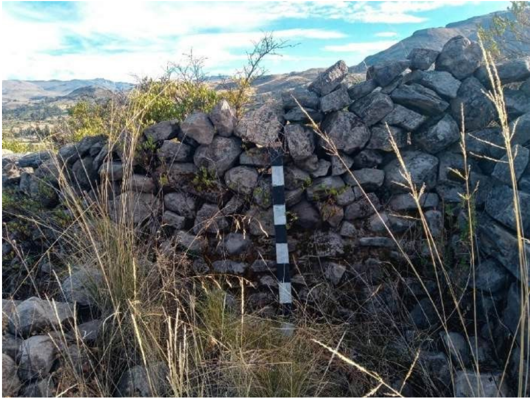
Figura 48: muro que forma parte de la estructura 4 reutilizado como parte de un cerco.
