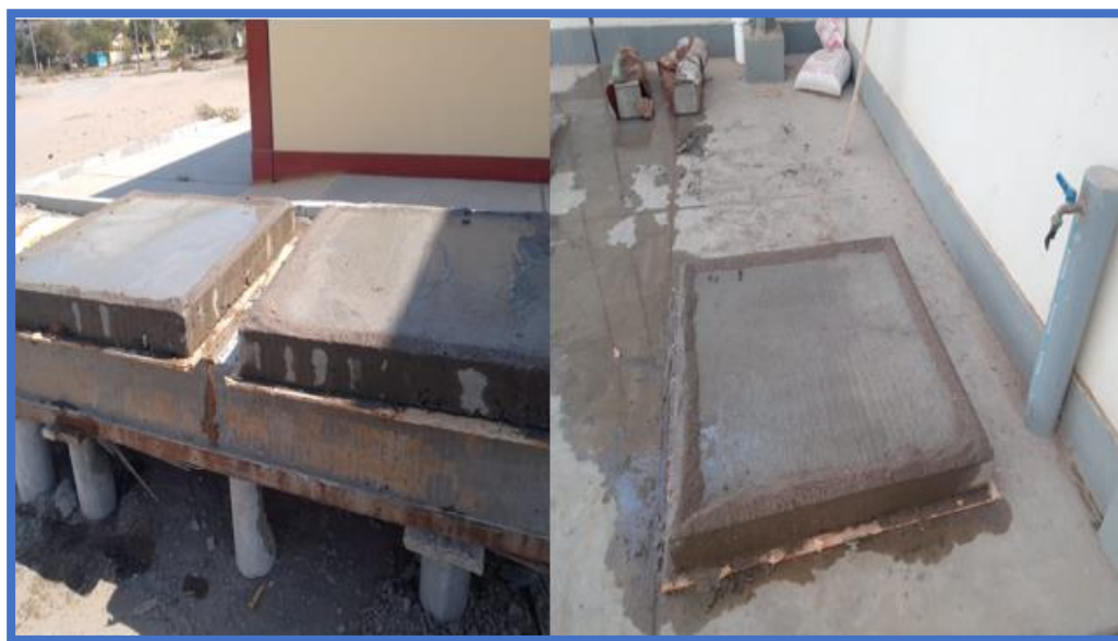
Figura 30 Elaboración de losas de concreto
