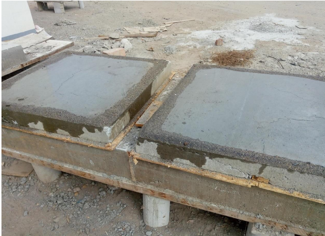
Figura 61 Curado con arroceras en losas de concreto de 1.00mx1.00x0.10m fabricadas temperatura ambiental promedio alta (30°C) a horas 12:00 pm
