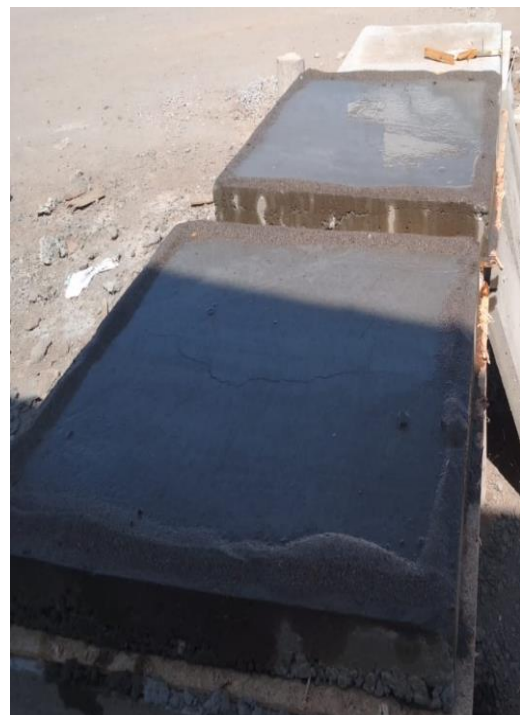
Figura 56 Curado de losa de concreto con arrocera
