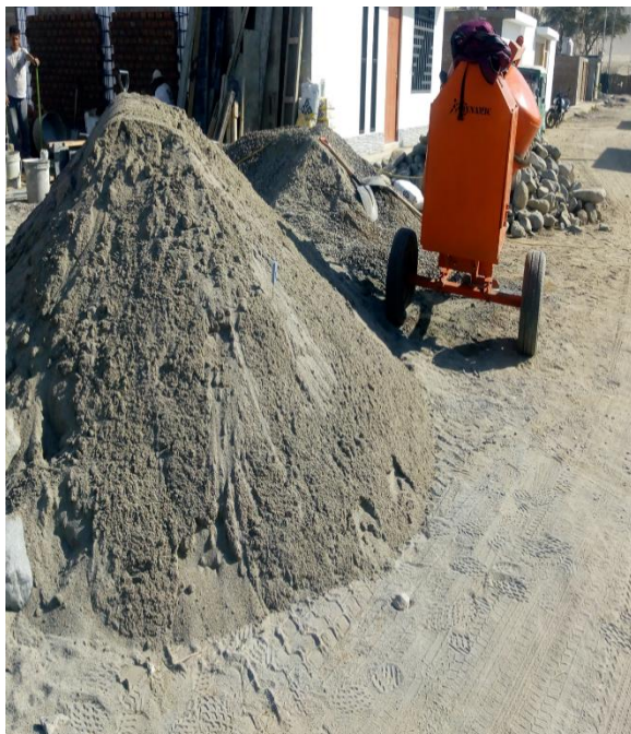
Figura 73 Acopio de agregados en obra expuestos a la temperatura ambiental
