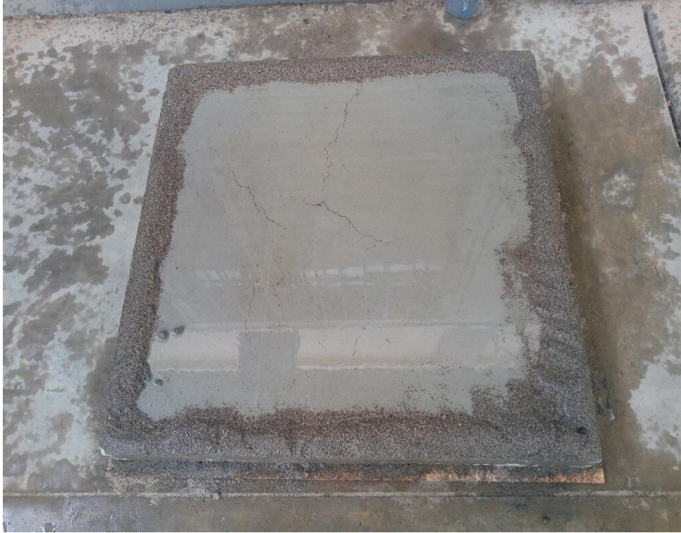
Figura 59 Aparición de fisuras en losa elaborada a una temperatura ambiental promedio (22°C) a horas 08:30 am
