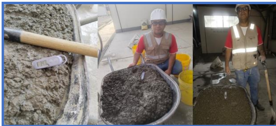
Figura 32 Toma de la temperatura de la mezcla del concreto fresco
