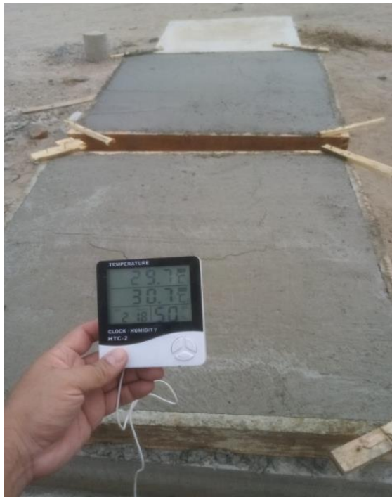
Figura 53 Endurecimiento inicial de la losa a una temperatura ambiental de 30.7°C y humedad relativa del 50%
