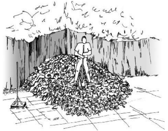
Fig.5. Compactación de los RSM con un compactador manual
