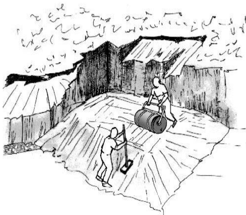
Fig.8. Compactación de la primera celda terminada con rodillo y compactador manual
