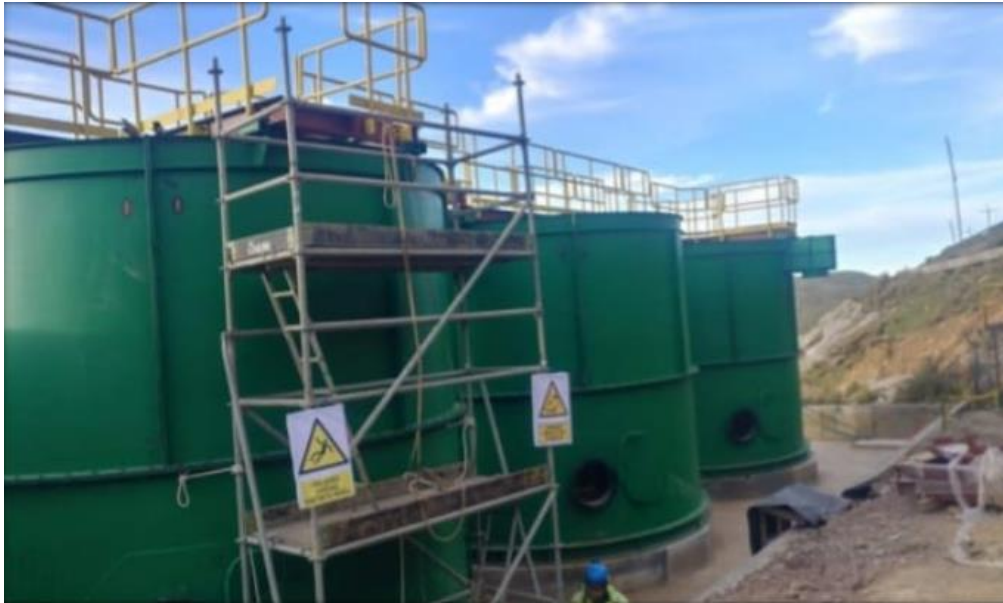
Fig. 4. Fabricación de 3 tanques, agua acida
