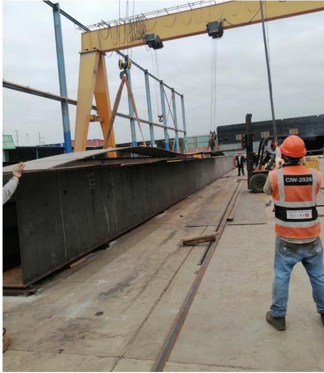
Fig. 8. Fabricación de puente grúa 20 toneladas
