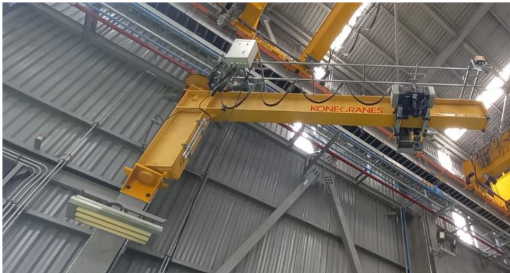
Fig. 4. Montaje e instalación de grúa pescante tipo viga
