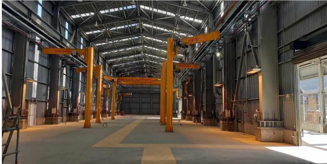
Fig. 23. Montaje e instalación de grúa pescante tipo columna
