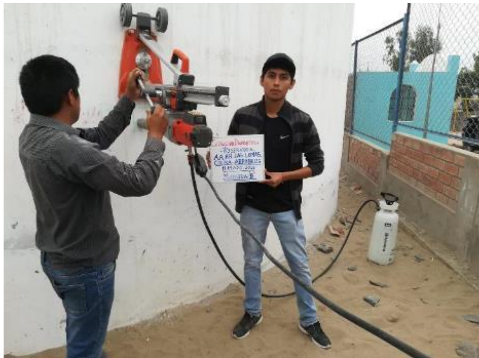
PERFORACIÓN DEL RESERVORIO (SUBTANJALLA-COLINA-ARRABALES)
