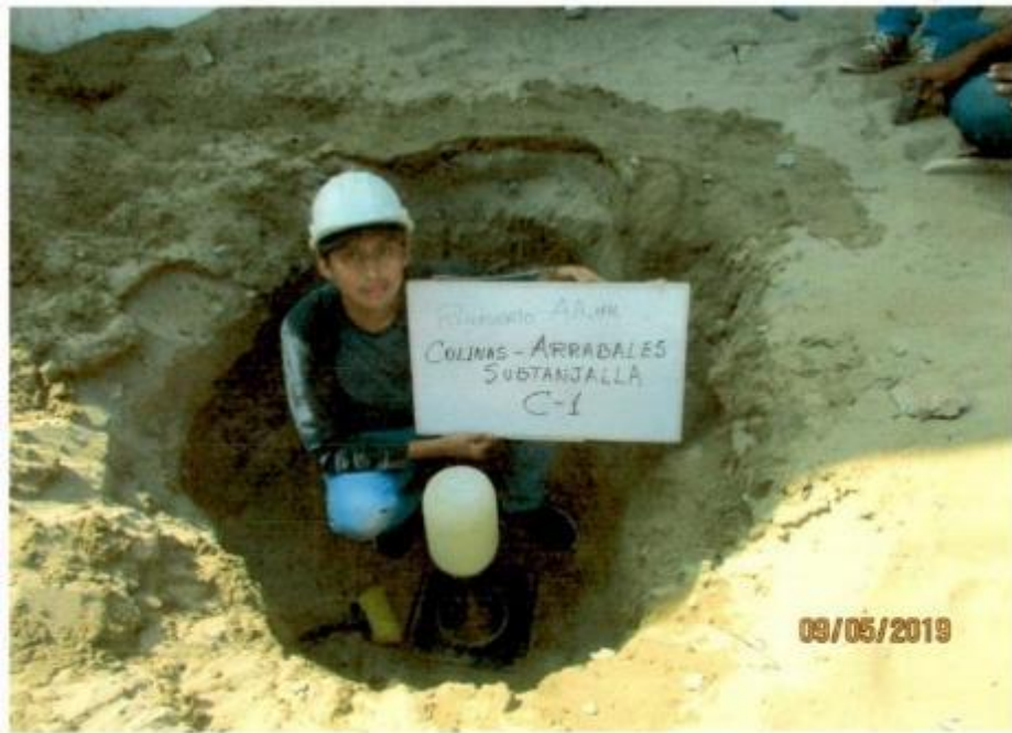
ENSAYO DE CONO DE ARENA (SUBTANJALLA-COLINA-ARRABALES)
