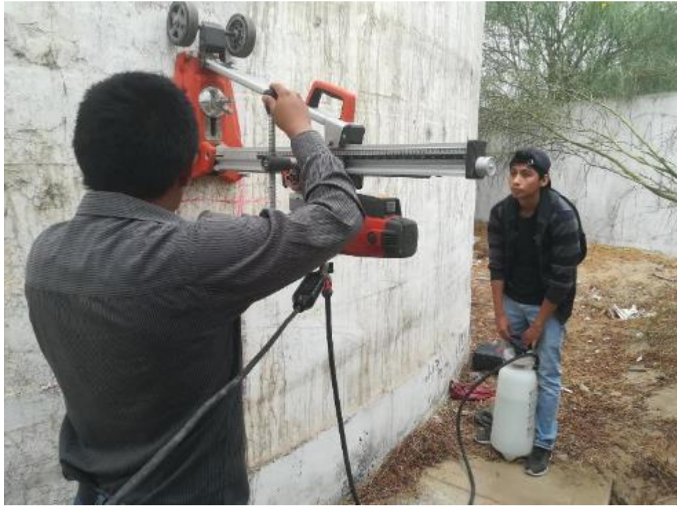
PERFORACIÓN DEL RESERVORIO ALTO SANTAMARÍA
