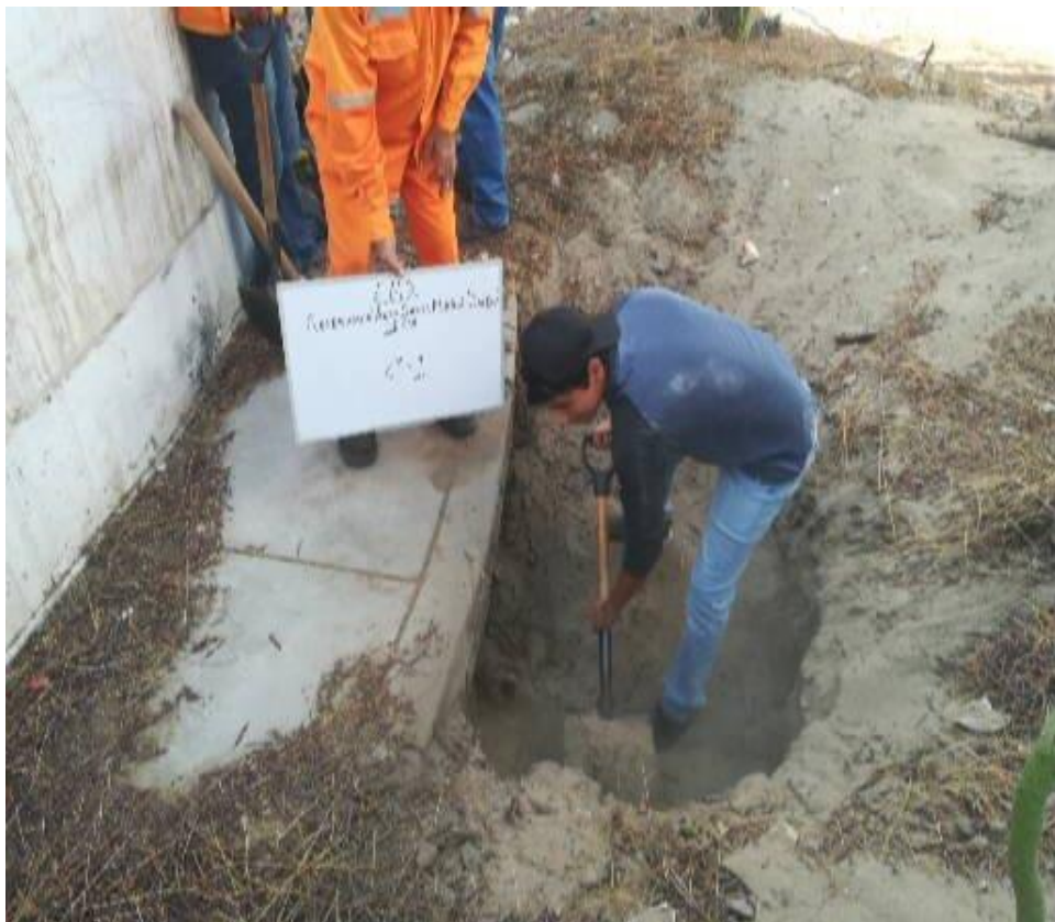
EXCAVACIÓN DE LA CALICATA DEL RESERVORIO ALTO SANTAMARÍA
