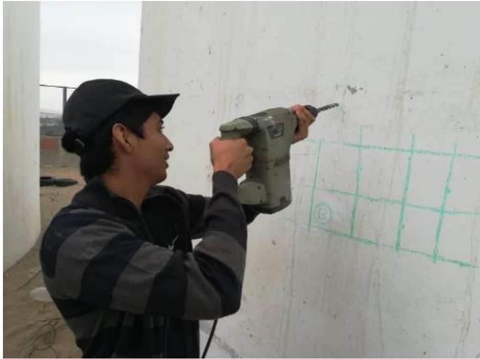
ENSAYO DE EXTRACCIÓN DE DIAMANTINA (SUBTANJALLA-COLINA-ARRABALES)
