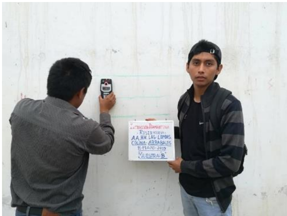
ENSAYO DE EXTRACCIÓN DE DIAMANTINA DETECTOR DE ESCÁNER (SUBTANJALLA-COLINA-ARRABALES)
