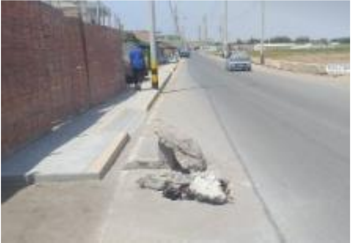
Fig. 13 Prolongación calle Simón Bolívar (La Marina)
