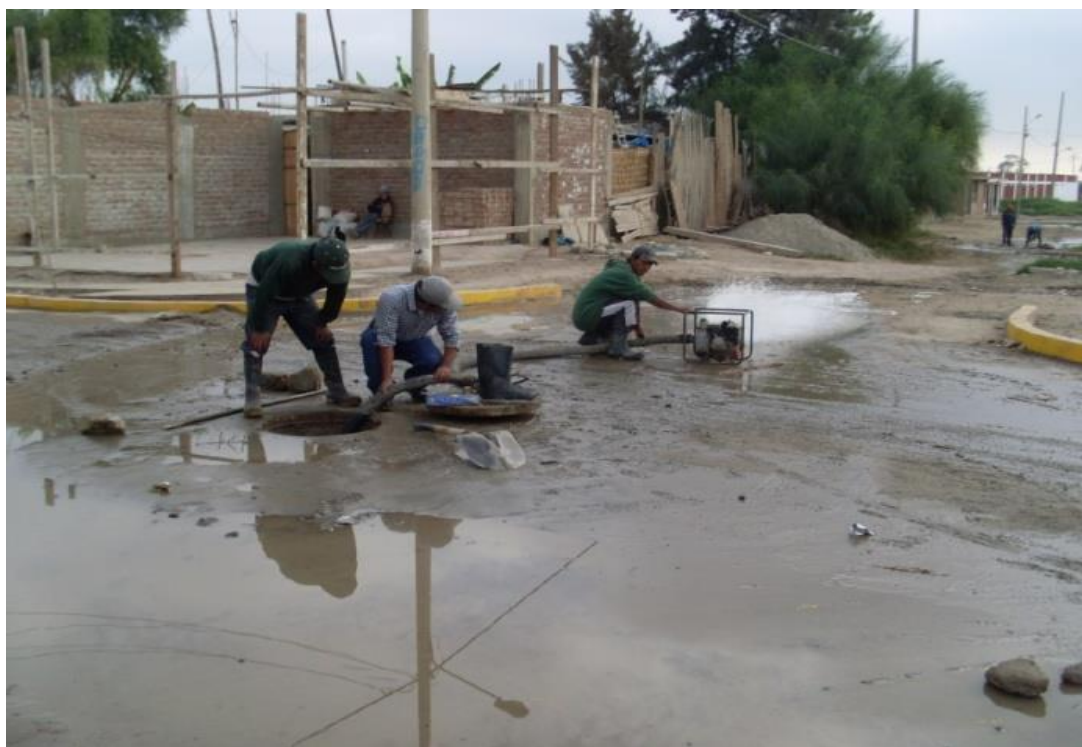
Fig. 1 Personal de mantenimiento drenando buzón represado
