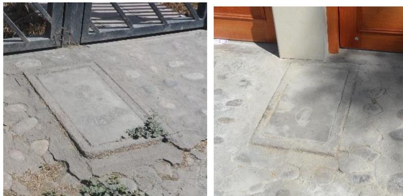
**Figura 21. Vista de tapas de cajas de conexión domiciliaria en mal estado.**
