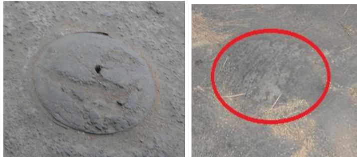
**Figura 25. Vista de tapas de buzones en regular estado.**
