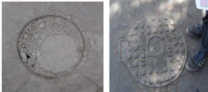
**Figura 24. Vista de tapas de buzones puestas al revés, con grietas y selladas por la carpeta asfáltica.**
