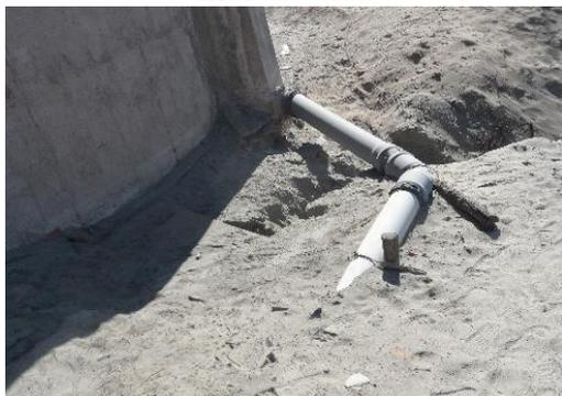
**Figura 18. Vista 02 de la línea de aducción del reservorio a la red en mal estado.**
