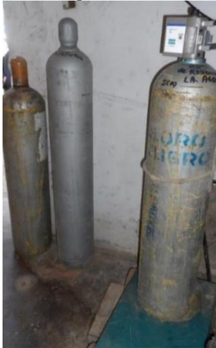
**Figura 13. Vista del equipo de cloración en el pozo IRHS 113.**
