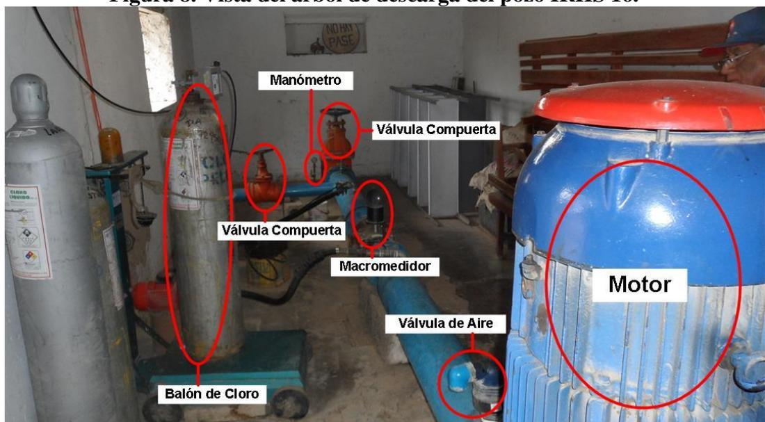
Para el pozo vertical IRHS 113, el árbol de descarga estará compuesta por una linterna, válvula de aire, válvula check bridada que sirve para proteger la línea contra el golpe de ariete, macromedidor tipo silleta, una línea de derivación con una válvula de control bridado que sirve para la toma de muestras, manómetro y válvula compuerta. Adicionalmente al árbol de descarga, se cuenta con un sistema de desinfección compuesto por un clorador de inyección directa, incluido balones de gas.
