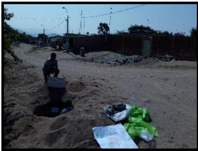
Excavación de la calicata 3
