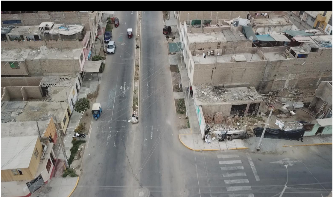
Fig. 37 Urb. San Miguel - Avenida anexa
