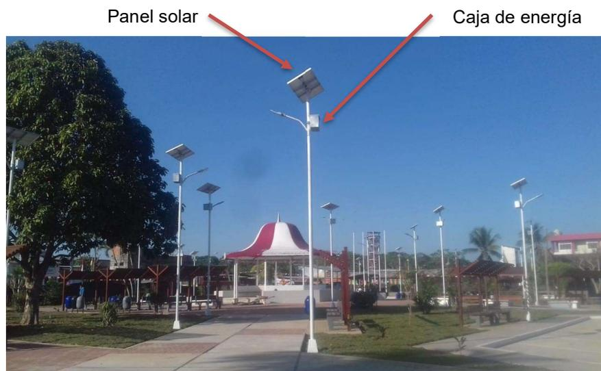
Figura N° 52: Solución de alumbrado con energía solar
