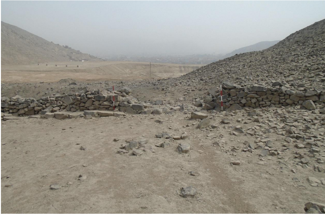
Figura 43. Vista Sur a Norte del muro perimétrico 01, sector A, lado Norte.
