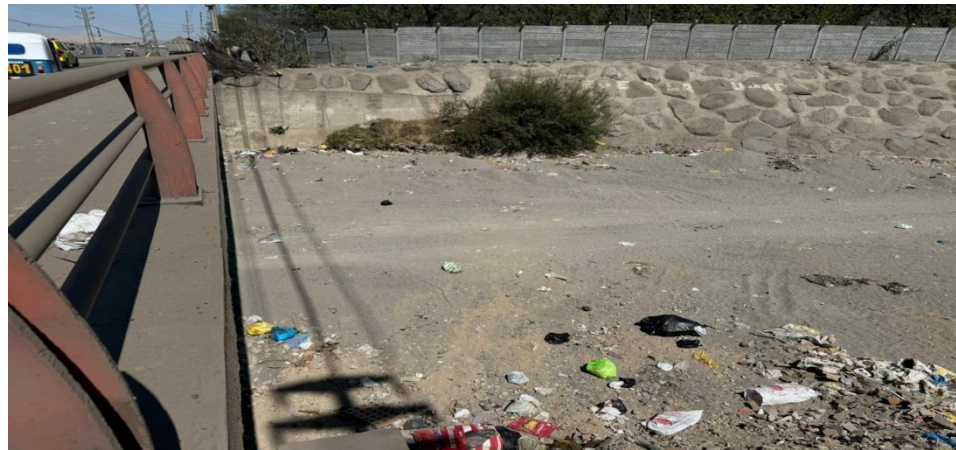
Fig. 7 Puente Los Maestros
