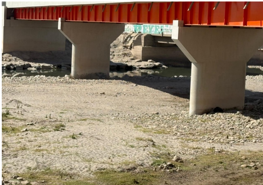
Anexo 6: Puente bocatoma
