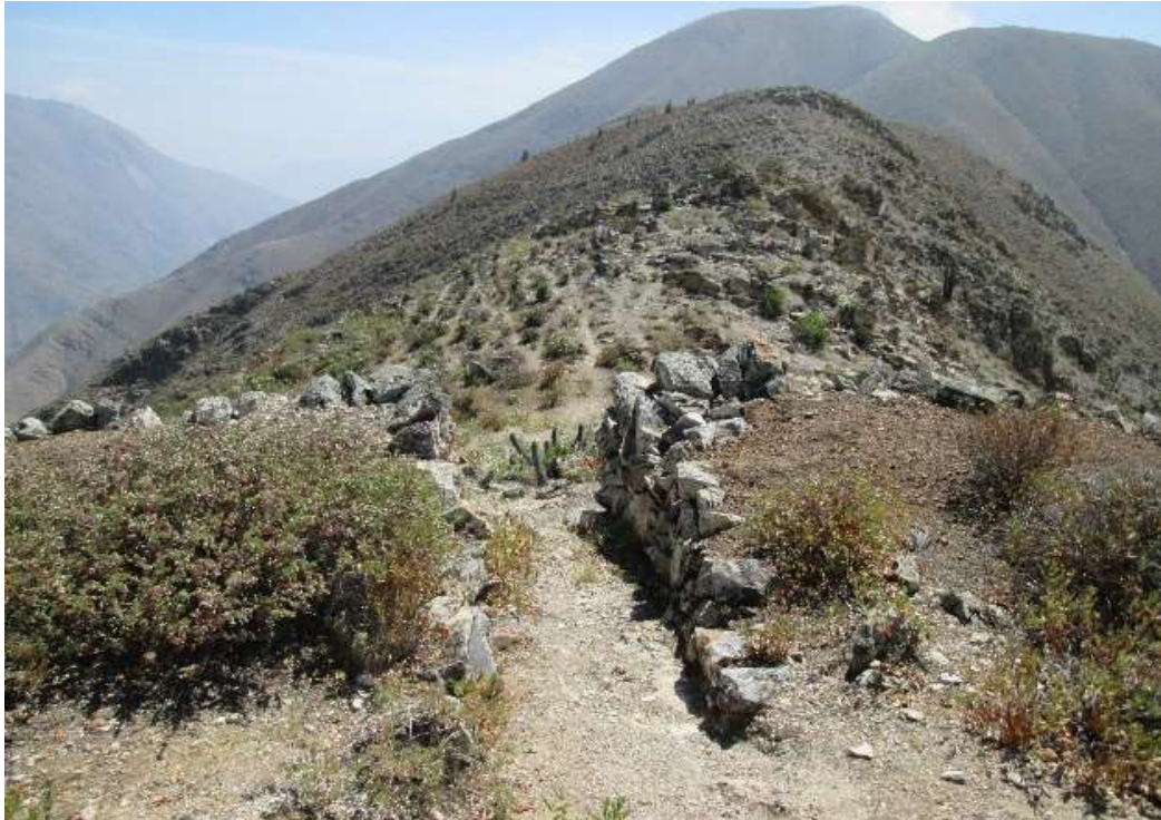
Figura 20. Vista desde el interior del acceso en la segunda muralla. Fuente: Otmard Castillon;2024.
