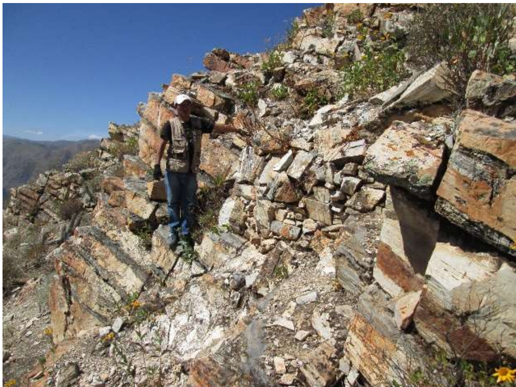
Figura 27. Muros de contención en espacios de pendiente pronunciada al lado Este del sitio. Fuente: Otmard Castillon;2024.
