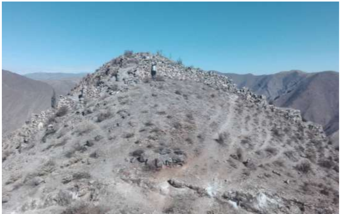
Figura 7. Vista en detalle de la primera muralla con sus detalles escalonados en los extremos. Fuente: Otmard Castillon;2024.
