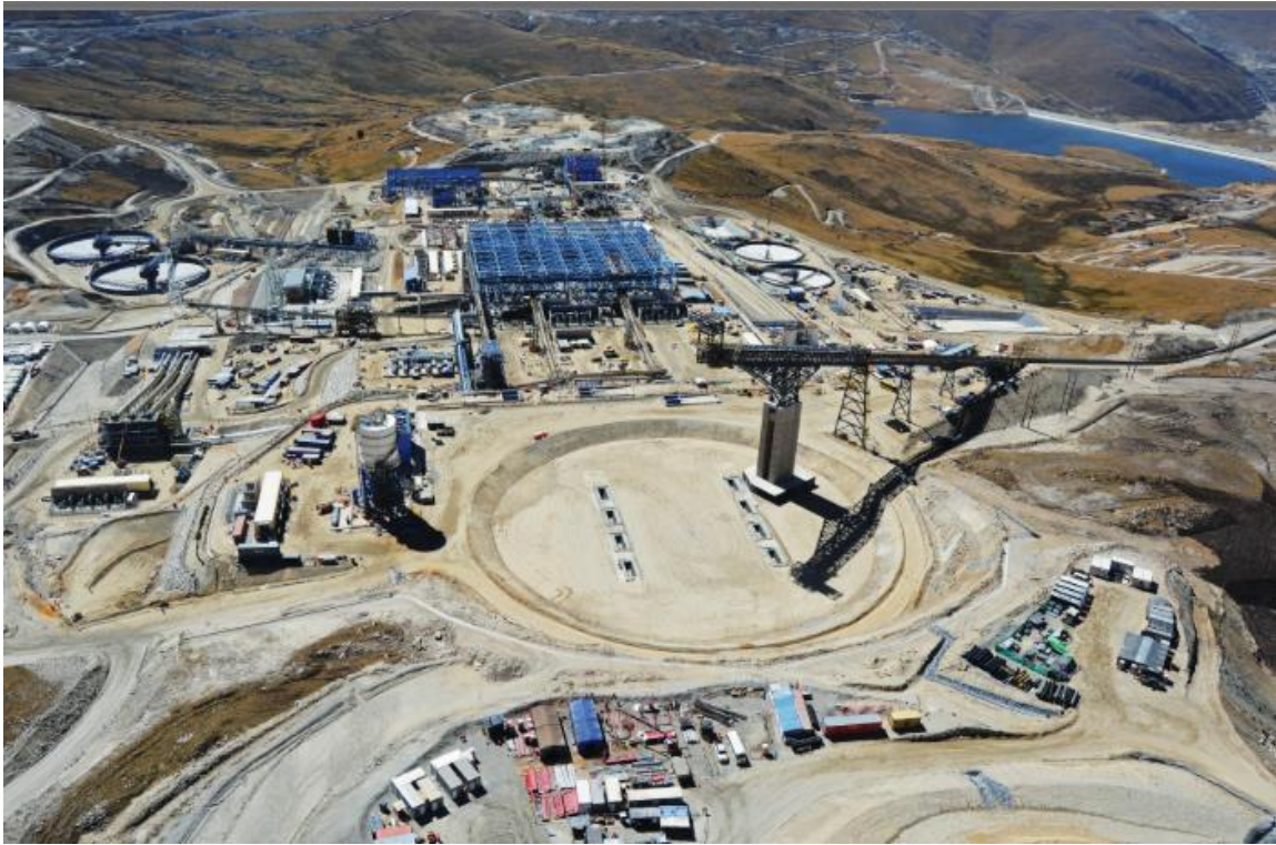
Fig. 6: Planta de Proceso las Bambas
