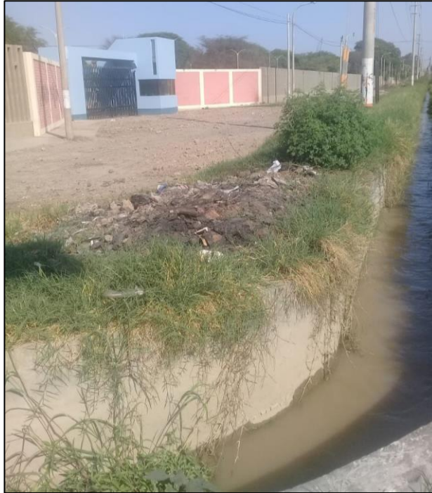
Fig. 11. Tramo exterior paralelo a la fachada principal
