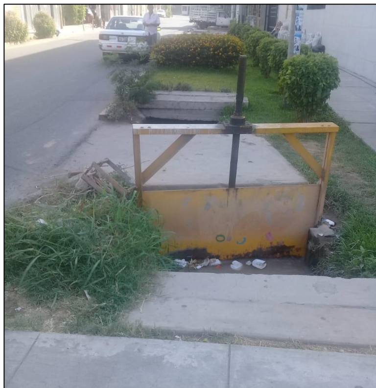
Fig. 18. Compuerta de regulación entre la Av. Arco real y Av. Los Maestros
