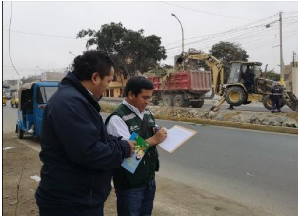
Fig. 4. Autoridades del Gobierno Regional de Ica verifican trabajos de limpieza del cauce La Mochica.
