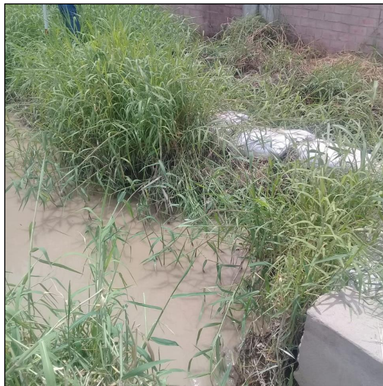
Fig. 17. Vista de una zona de desborde reforzada con sacos terreros
