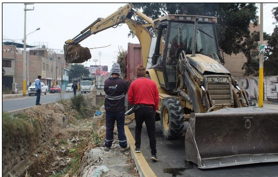
Fig. 3. Retiro de basura acumulada en el cauce La Mochica Fuente: Diario La Opinión – Ica [4]
