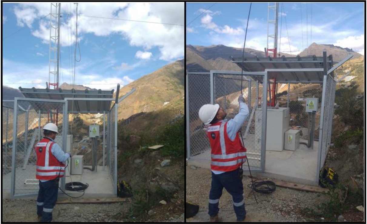
Fig.12 Día 2, izaje de cable coaxial
