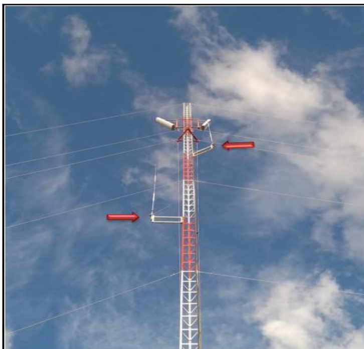
Fig.38 Día 5, distribución de las antenas g7 en la torre.
