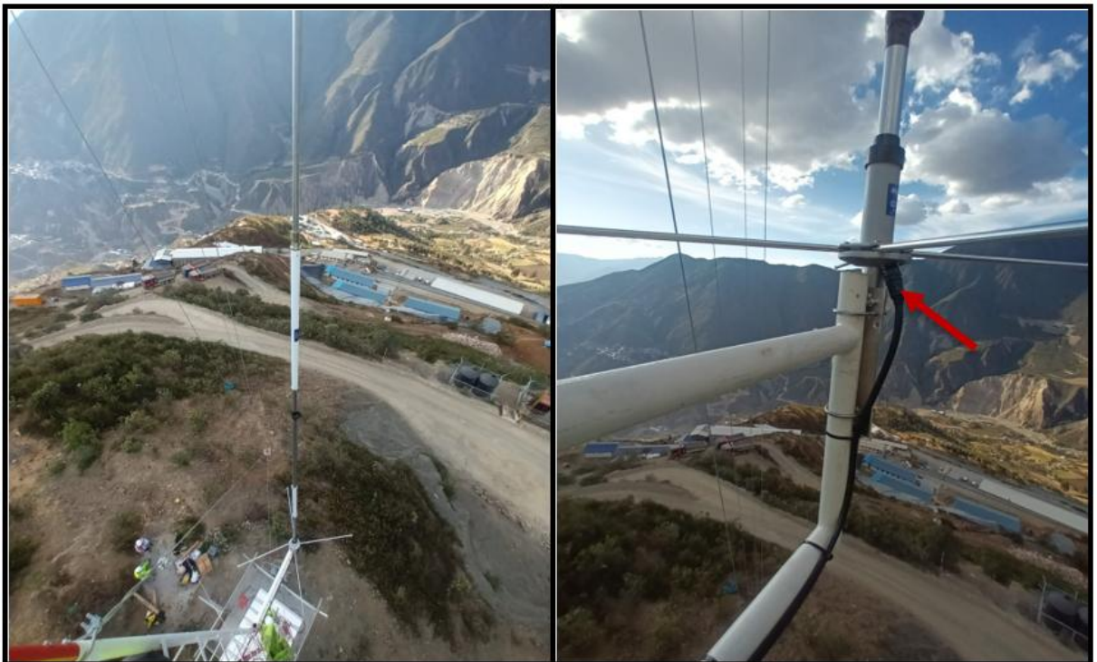
Fig.13 Día 2, instalación de cable coaxial
