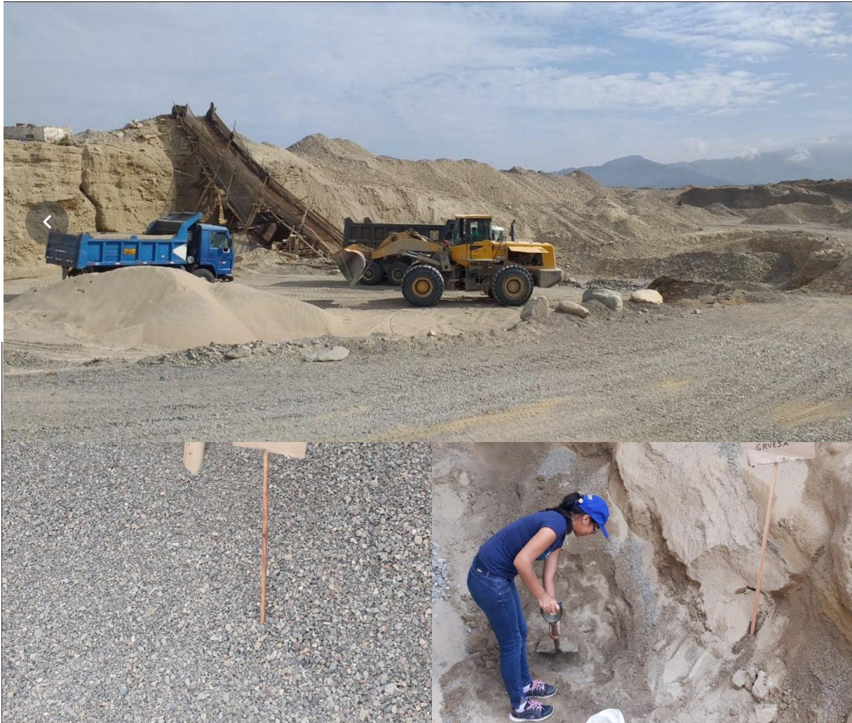
Fig. 4.0. Extracción del agregado grueso y fino
