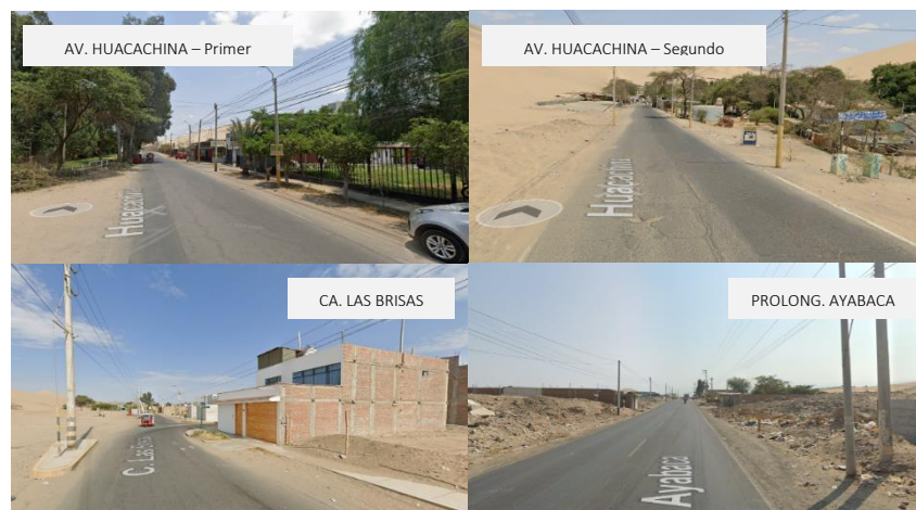
Figura N°12: Estado actual de vías
